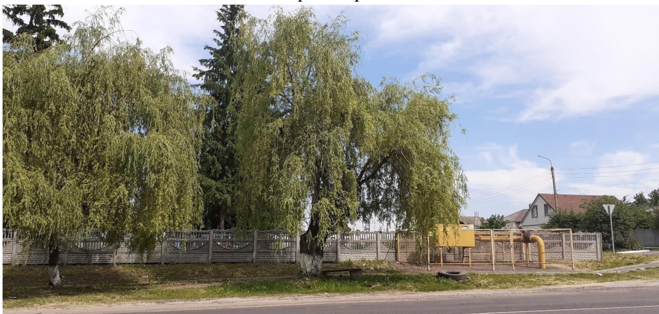
Фото 10. Газовое оборудование около Объекта на углу ул. Володарского и 25 Октября
