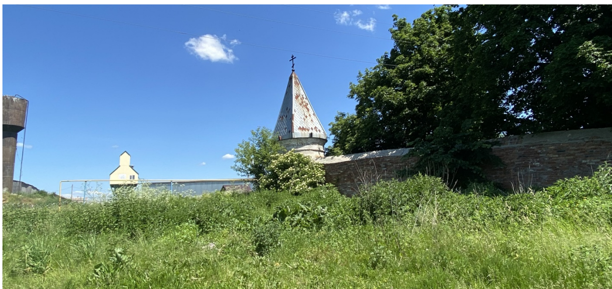
Фотография № 2. Вид с юго-запада на Объект.
