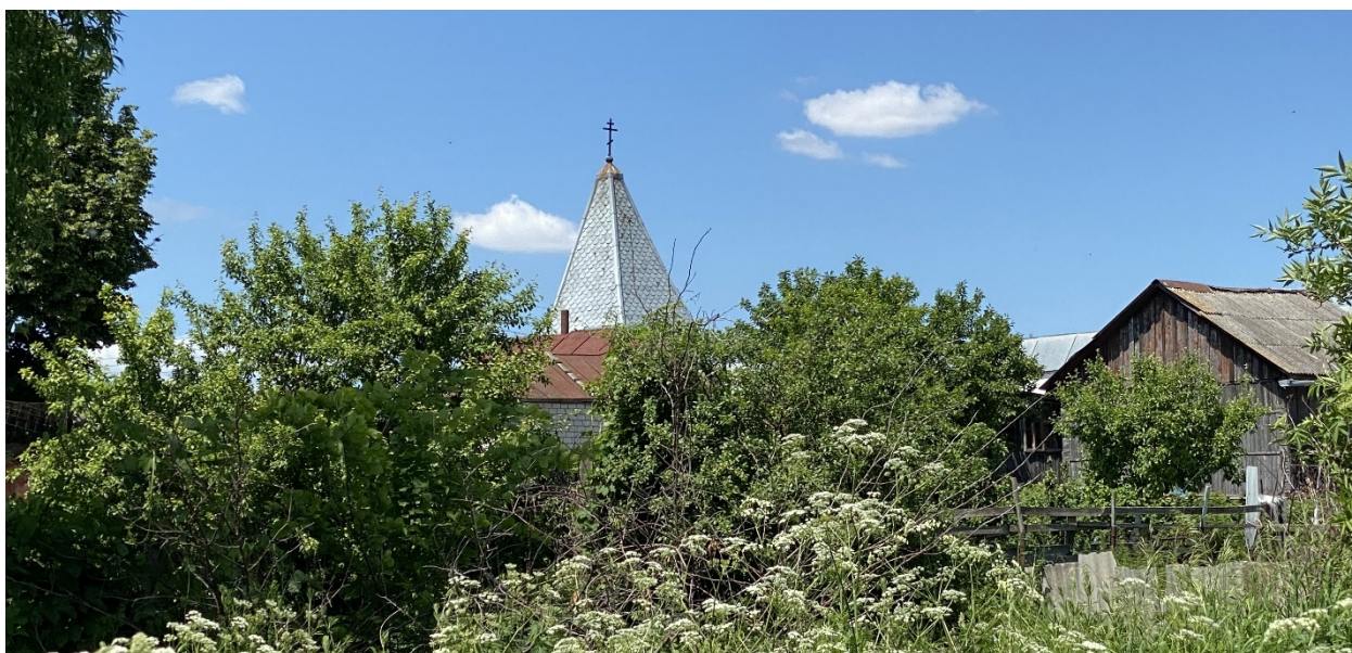
Фотография № 6. Вид с юго-востока на Объект.
