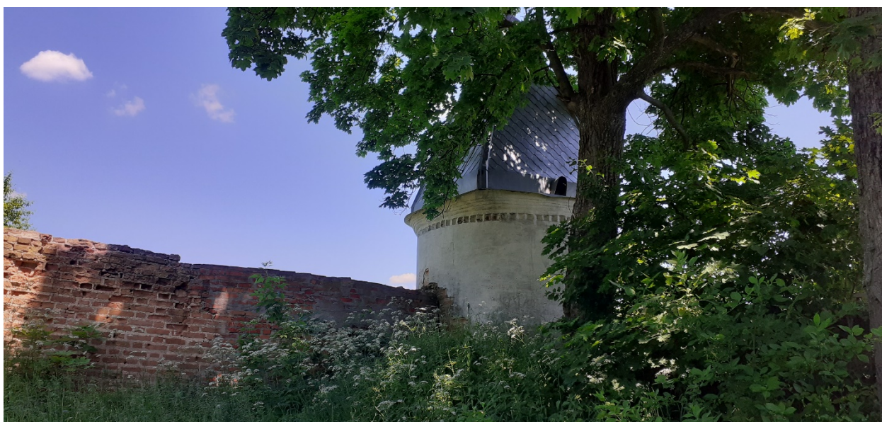
Фотография № 8. Вид с юго-запада на Объект.
