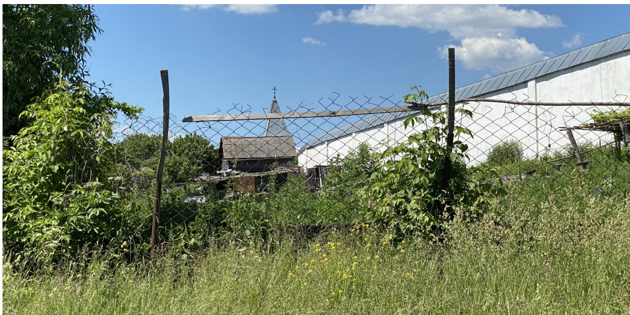
Фотография № 7. Вид с юго-востока на Объект.
