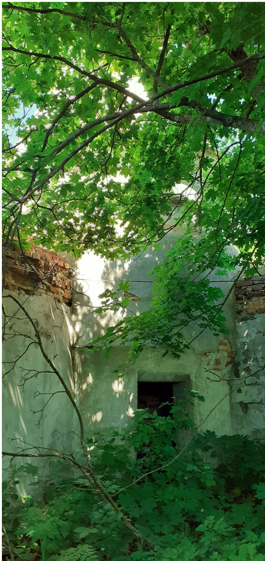
Фотография № 9. Вид с юго-востока на Объект.
