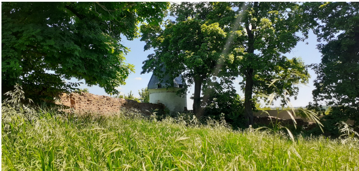
Фотография № 7. Вид с юго-запада на Объект.
