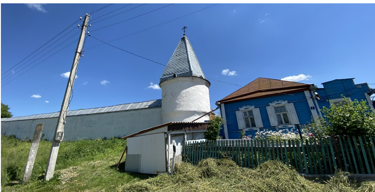
Фотография № 4. Вид с юго-запада на Объект.
