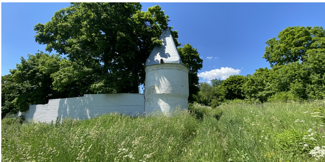
Фотография № 2. Вид с юго-востока на Объект.
