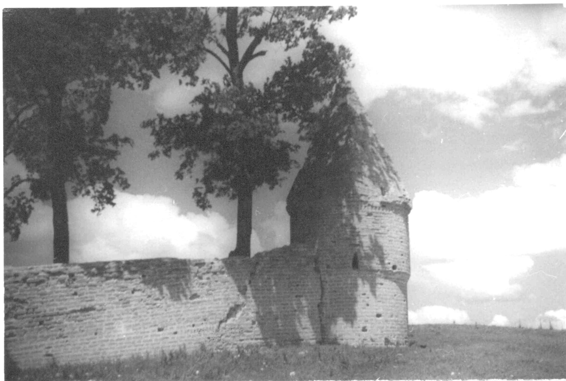
14. Северо-восточная башня. Вид снаружи монастыря с восточной стороны. Источник: ОКУ «ГАКО». Ф. Р-962. Оп. 1. Д. 24.
