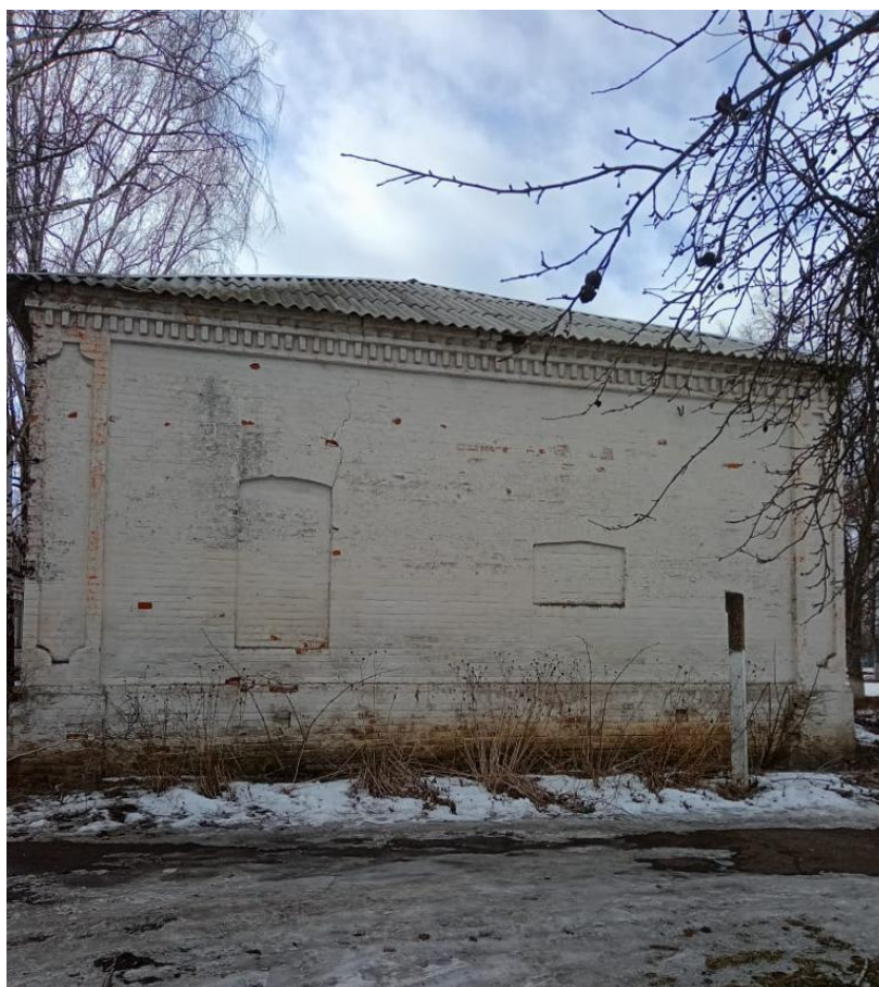
Т.ф. 4. Общій вид бокового фасада Объекта.
