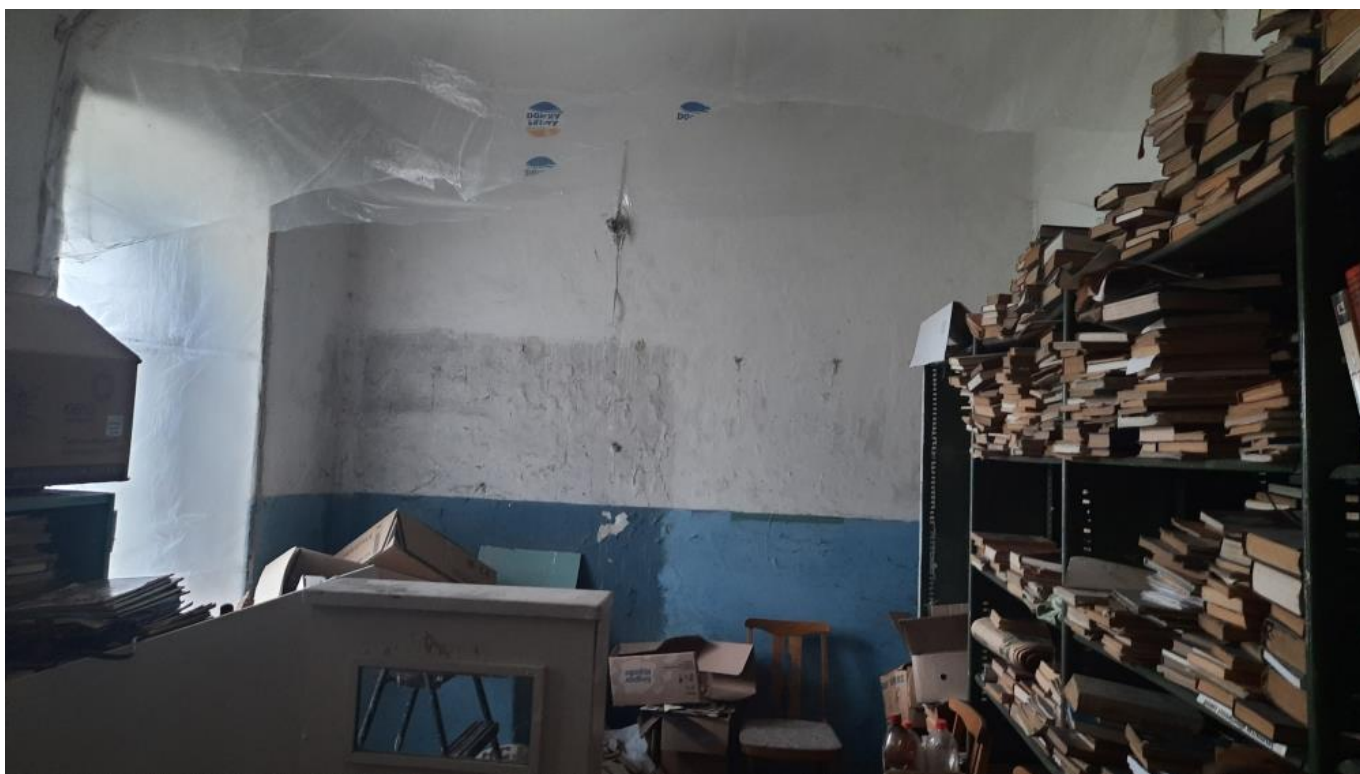
Т.ф. 6. Общий вид внутренних помещений Объекта.
