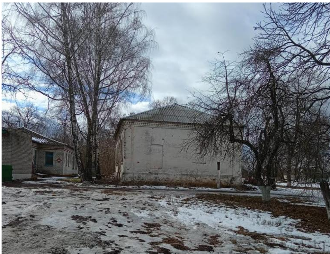
Т.ф. 5. Общий вид дворовой территории Объекта.
