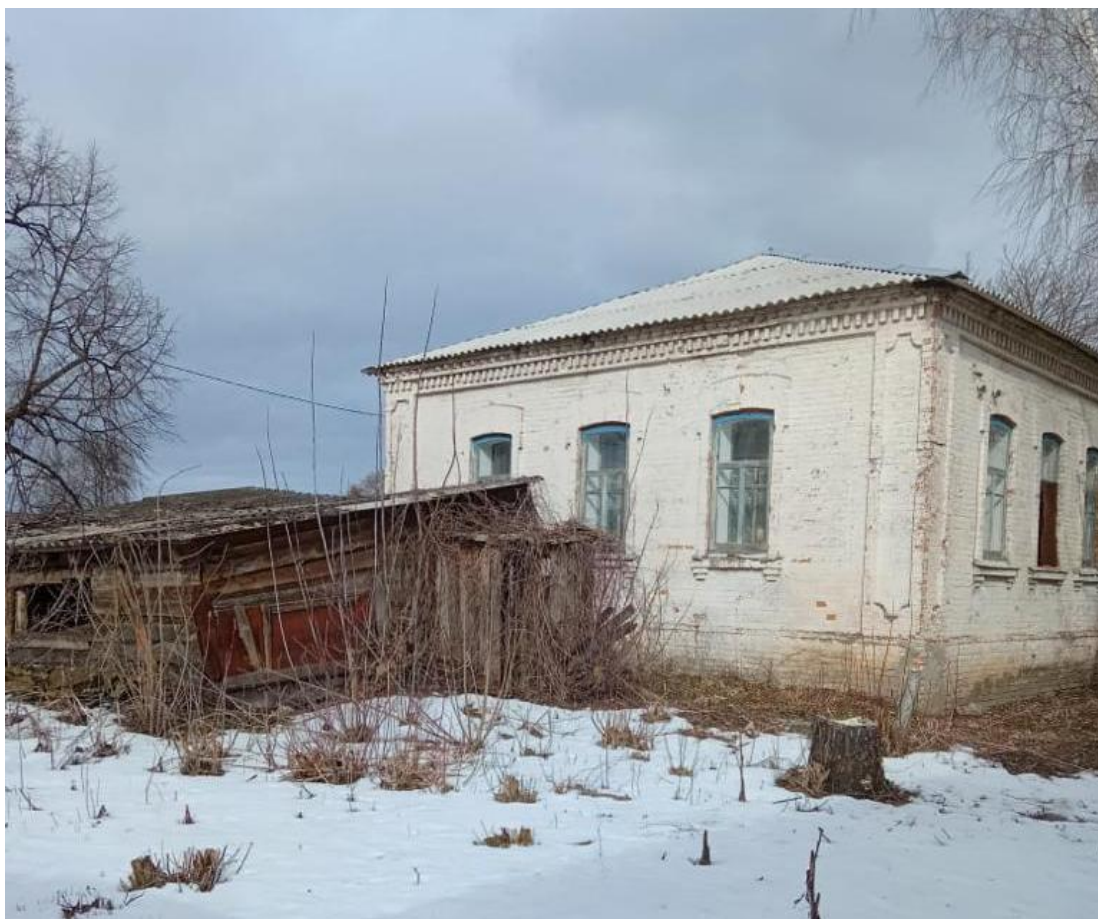
Т.ф. 3. Общій вид бокового фасада Объекта.
