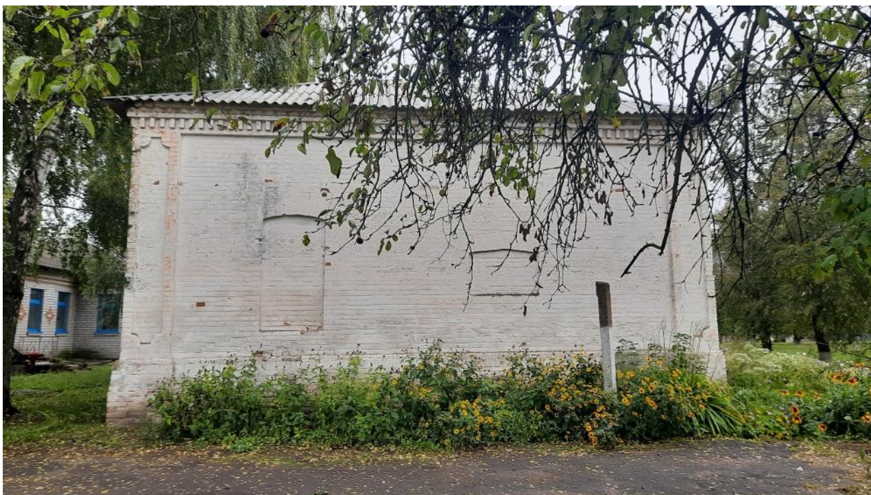
Т.ф. 3. Общий вид бокового фасада Объекта.
