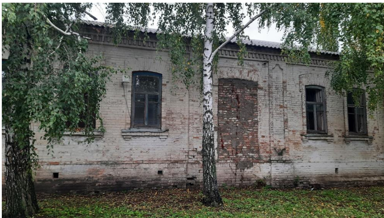
Т.ф. 2. Общий вид дворового фасада Объекта.
