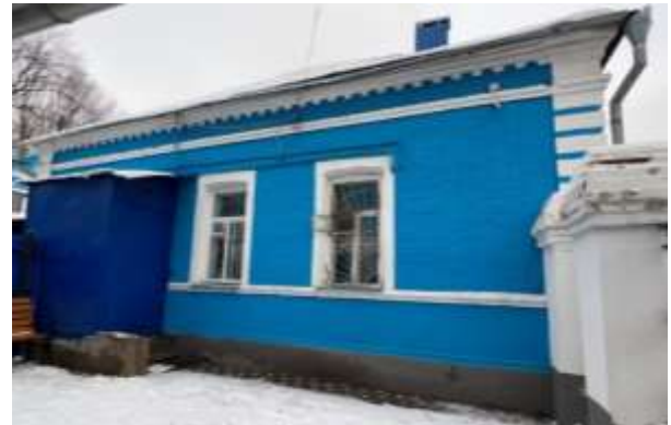
Вид на южный боковой фасада (без поздней пристройки)
