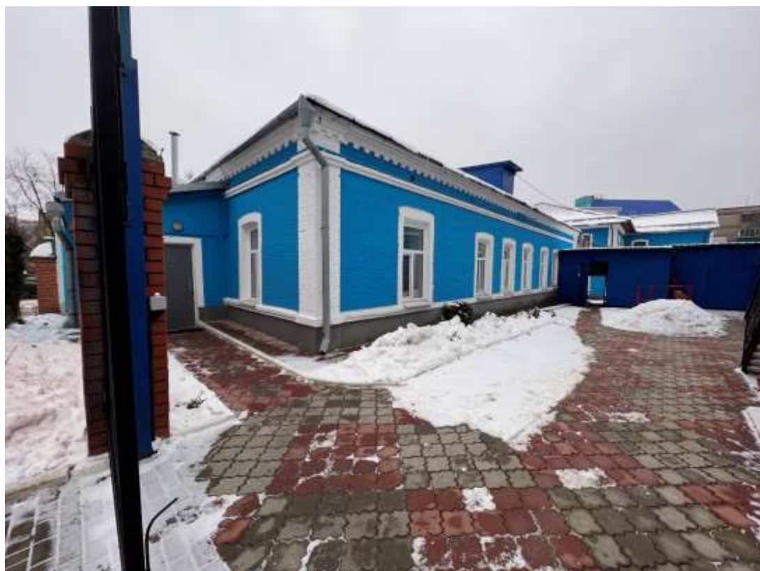
Фотография № 4. Вид с северо-запада на Объект.
