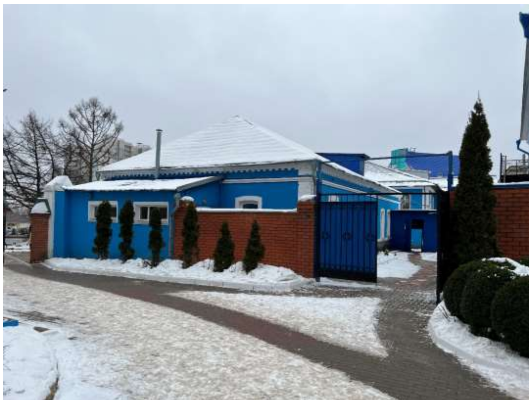
Фотография № 3. Вид с северо-запада на Объект.
