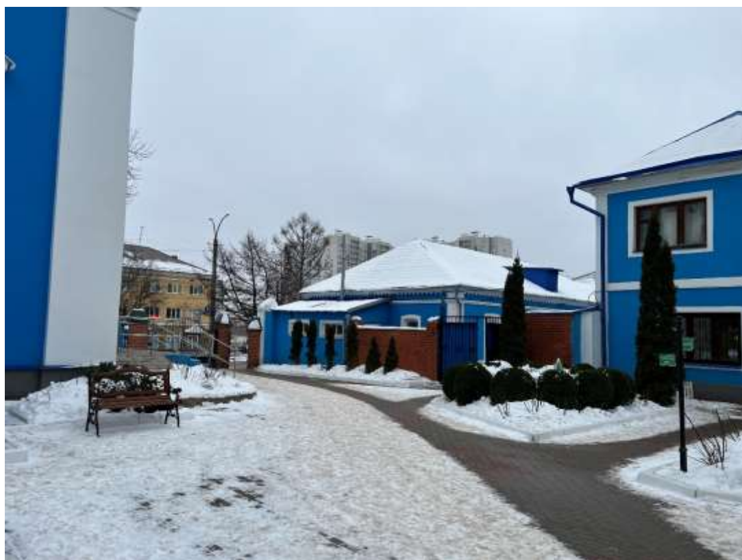
Фотография № 2. Вид с северо-запада на Объект.
