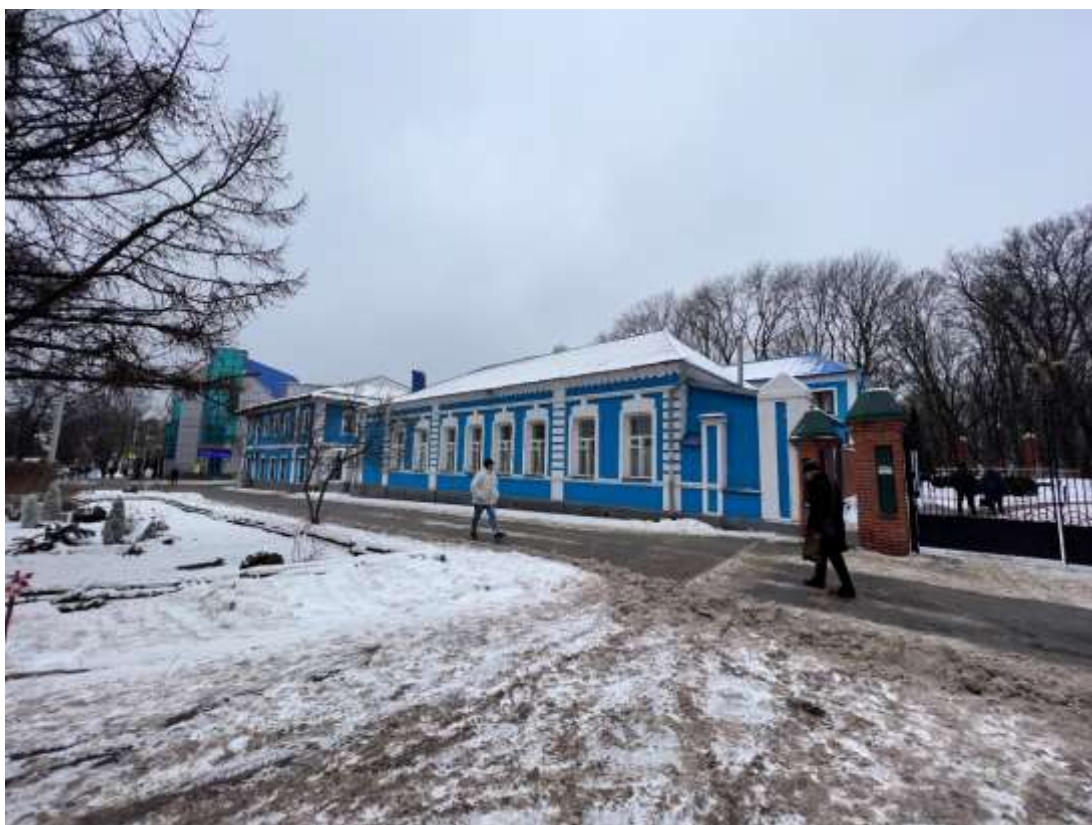
Фотография № 6. Вид с северо-востока на Объект.
