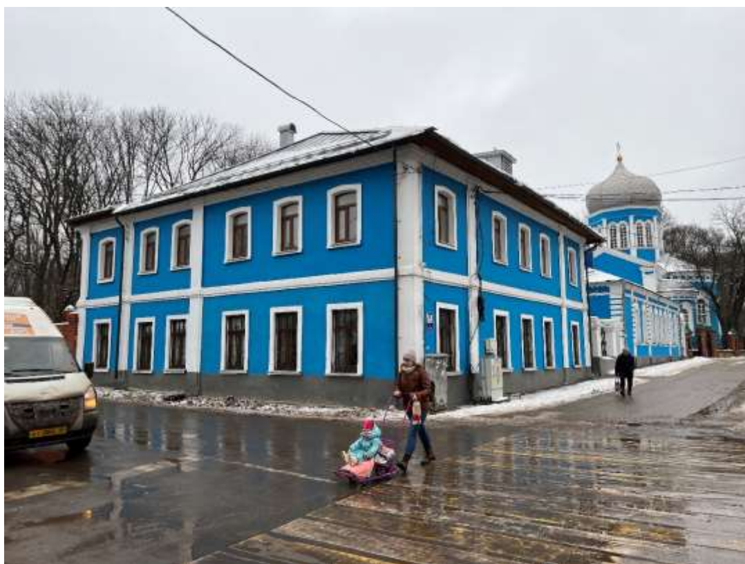
Фотография № 10. Вид с юго-востока на Объект.
