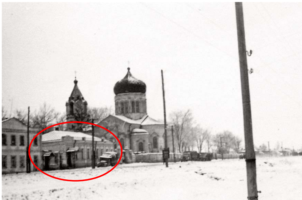
21. Вид с улицы Карла Маркса на Никитскую церковь и «церковные» здания. В левой части фотографии представлено здание Объекта.
