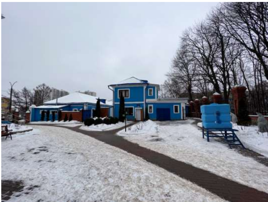
Фотография № 1. Вид с северо-запада на Объект.
