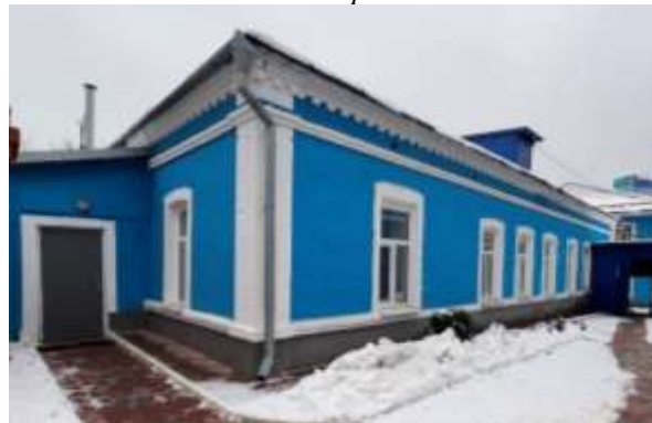
Вид на боковой северный фасад и дворовый западный фасад
