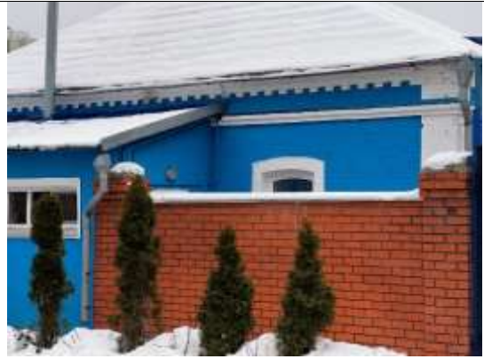
Венчающий карниз, фриз и тяга фасада
