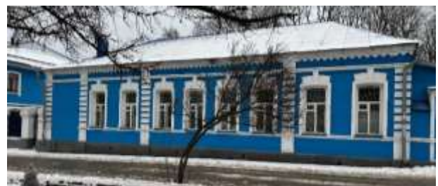
Вид на лицевой фасад по ул. Карла Маркса
