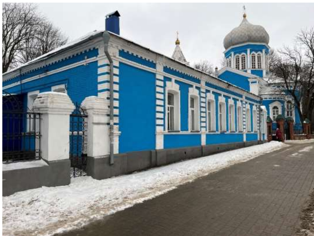
Фотография № 8. Вид с юго-востока на Объект.
