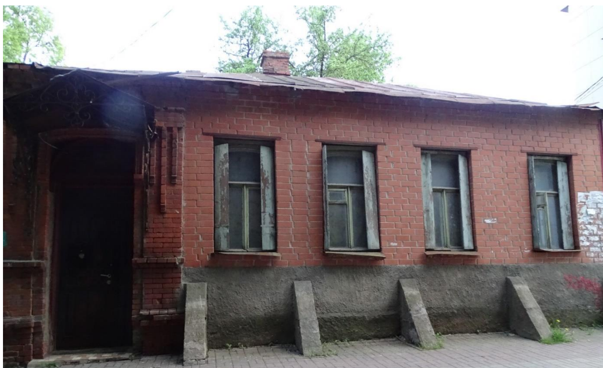
Фото 2. Уличный северный фасад
