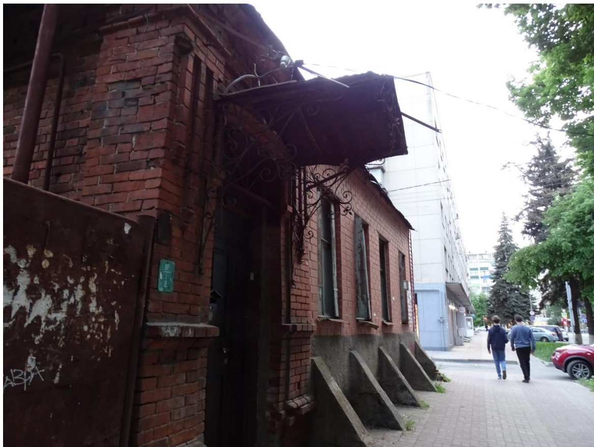
Фото 11. Панорама ул. Павлова в сторону к улице Радищева. За Объектом – жилой дом с адресом: ул. Павлова, д.6
