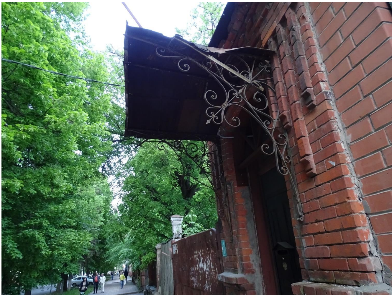
Фото 3. Архитектурный декор портала. Кованые кронштейны козырька.
