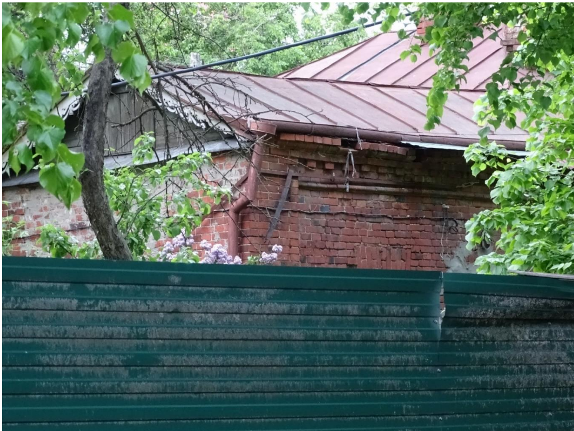
Фото 7. Общий вид дворового фасада Объекта
