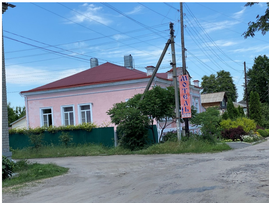
Фотография № 2. Вид с юго-востока на Объект.
