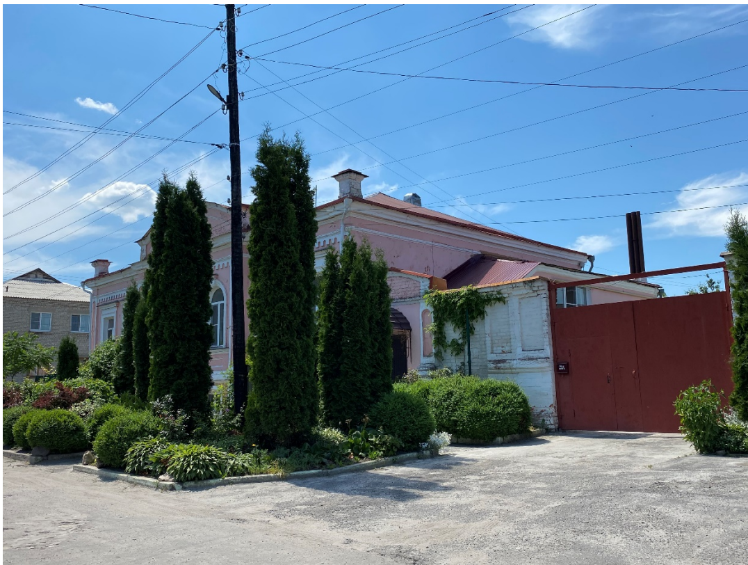
Фотография № 11. Вид с северо-востока на Объект.
