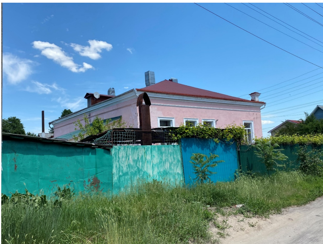
Фотография № 4. Вид с юго-запада на Объект.
