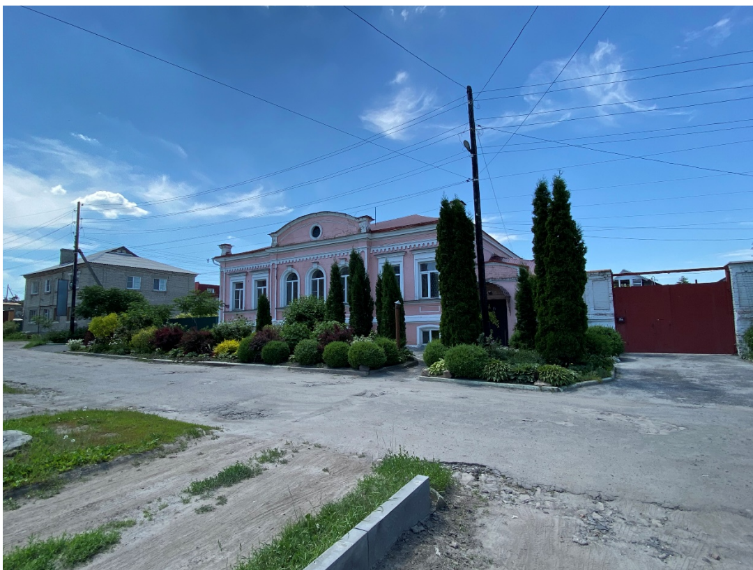
Фотография № 10. Вид с северо-востока на Объект.
