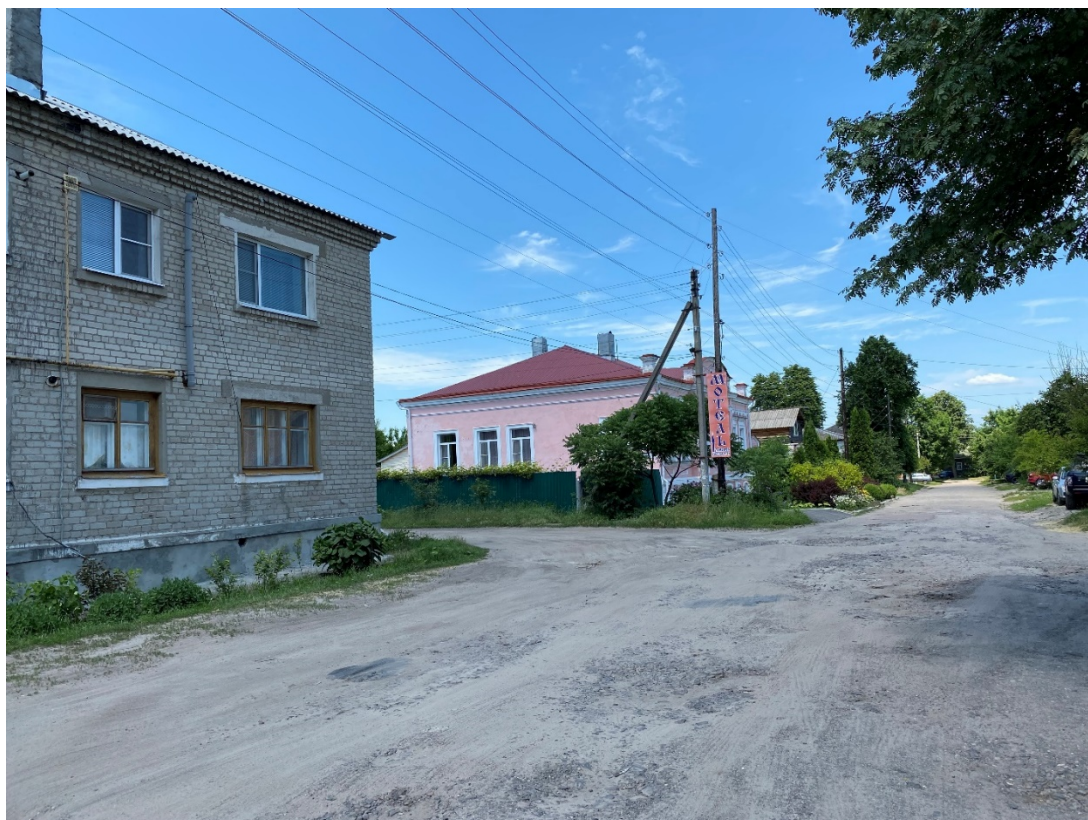
Фотография № 1. Вид с юго-востока на Объект.
