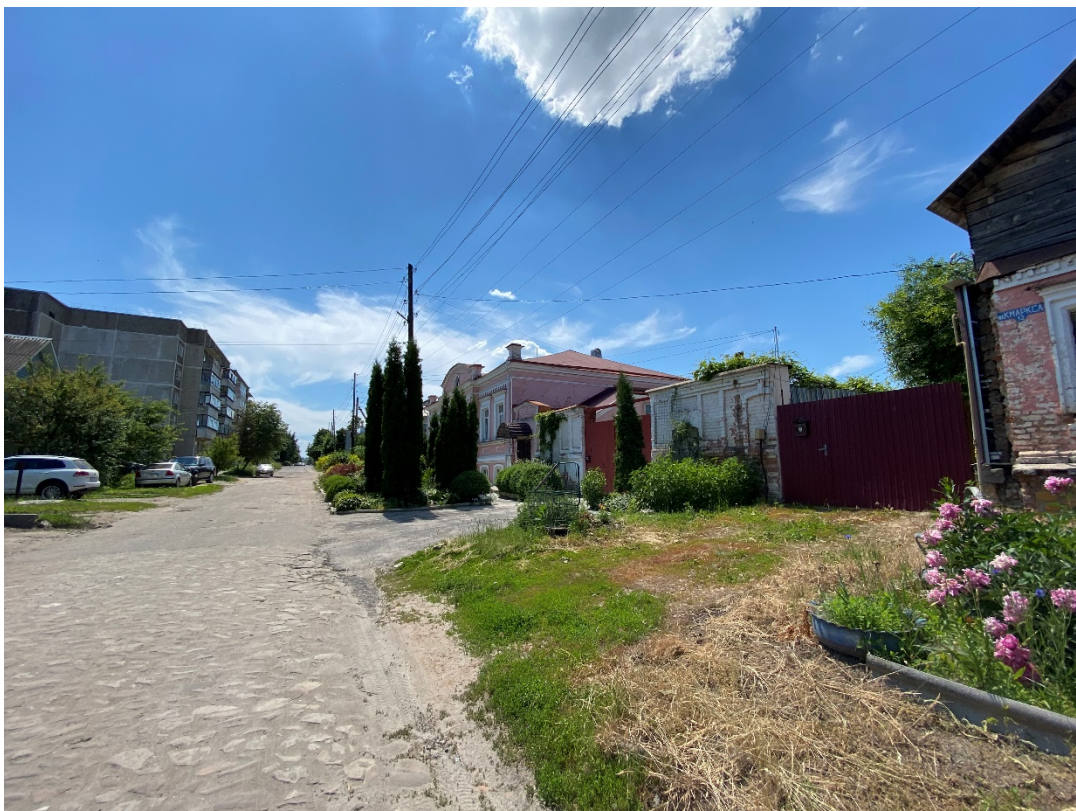
Фотография № 12. Вид с северо-востока на Объект.
