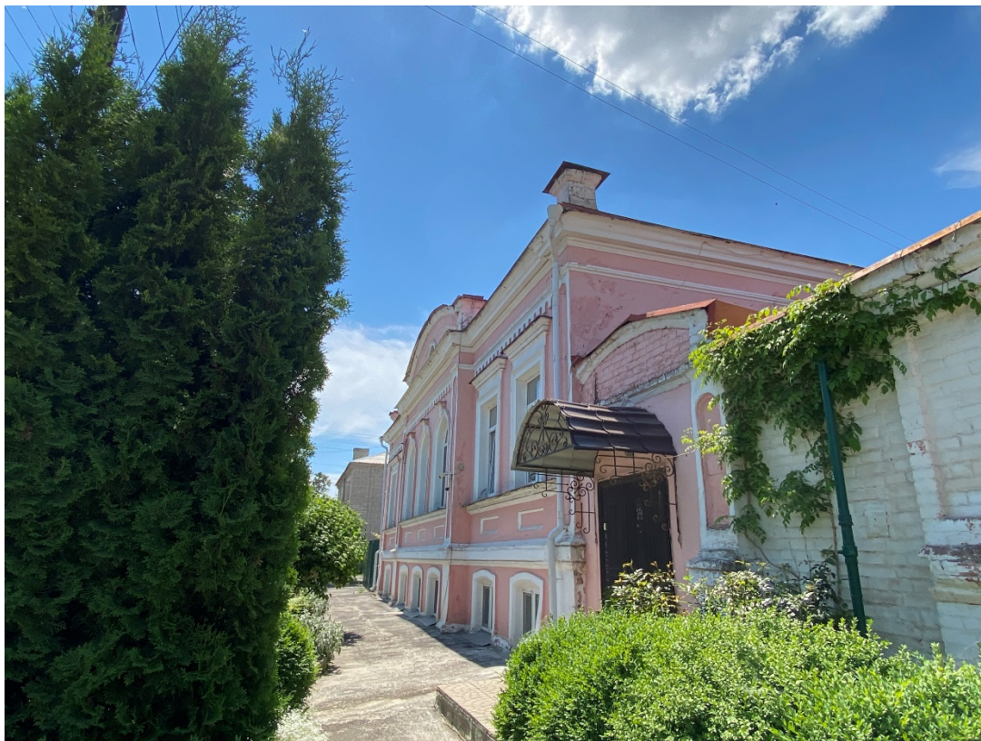
Фотография № 9. Вид с севера на Объект.
