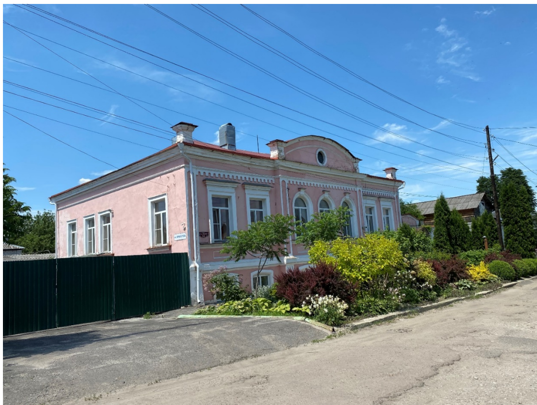
Фотография № 7. Вид с юго-востока на Объект.
