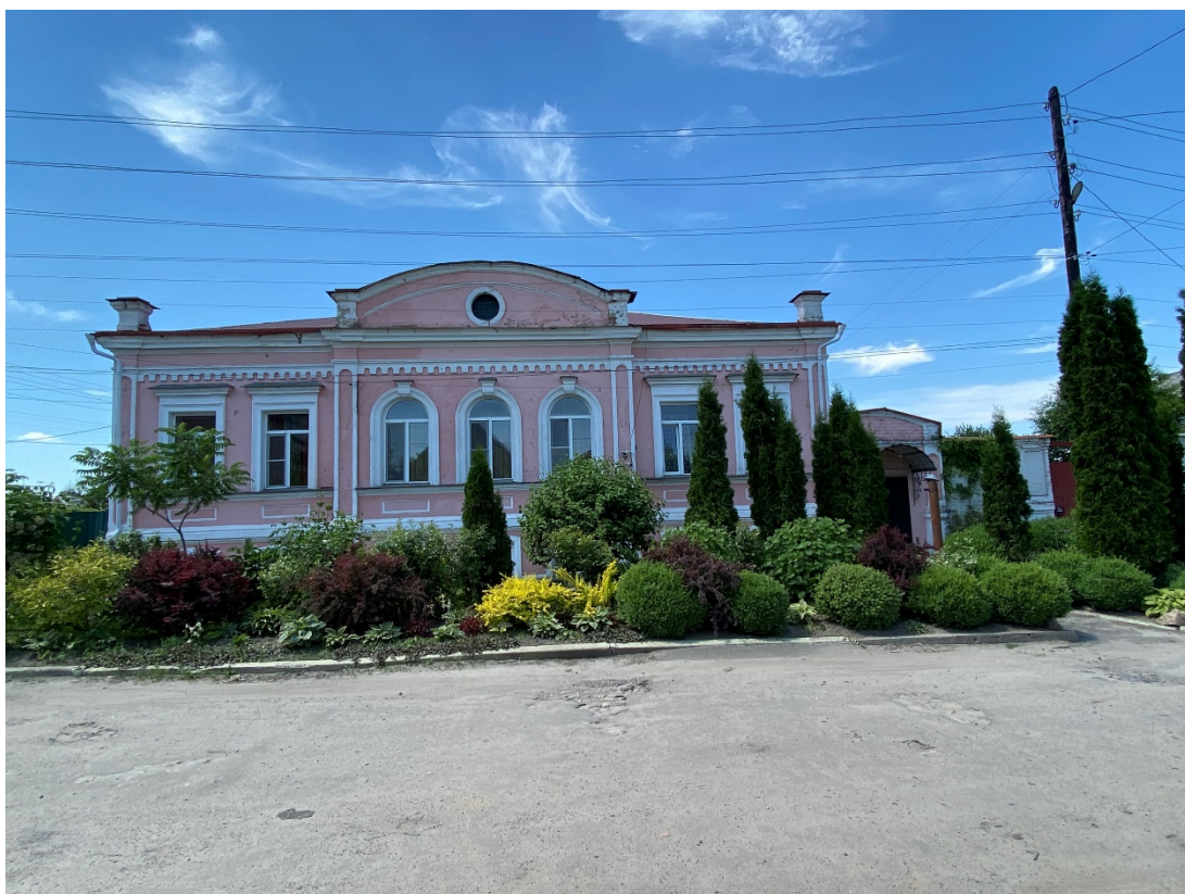
Фотография № 8. Вид с востока на Объект.
