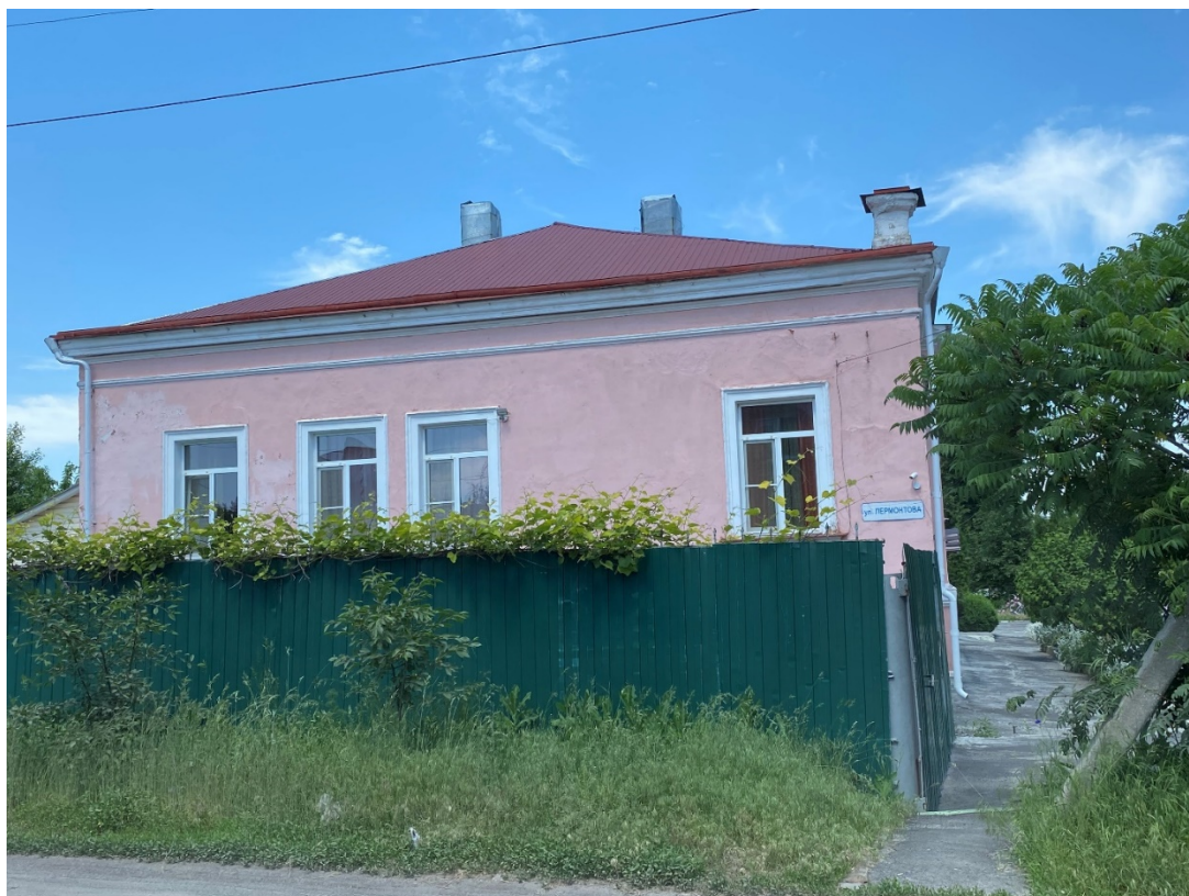
Фотография № 3. Вид с юга на Объект.
