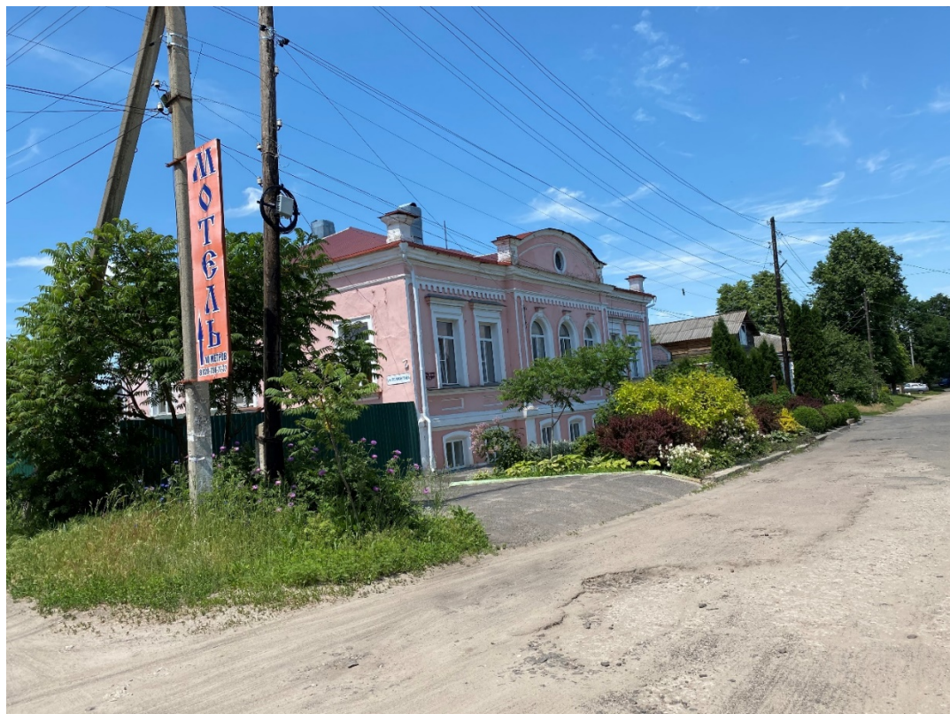
Фотография № 6. Вид с юго-востока на Объект.
