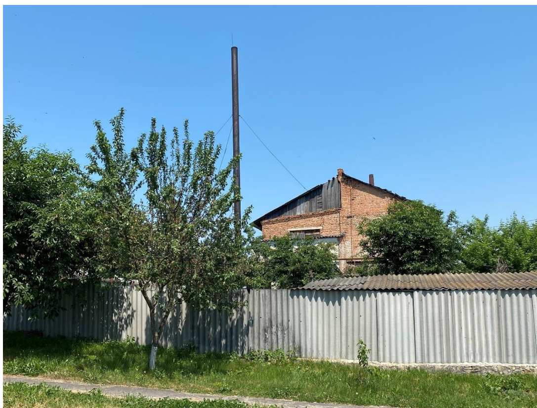
Фотография № 6. Вид с юго-востока на Объект.
