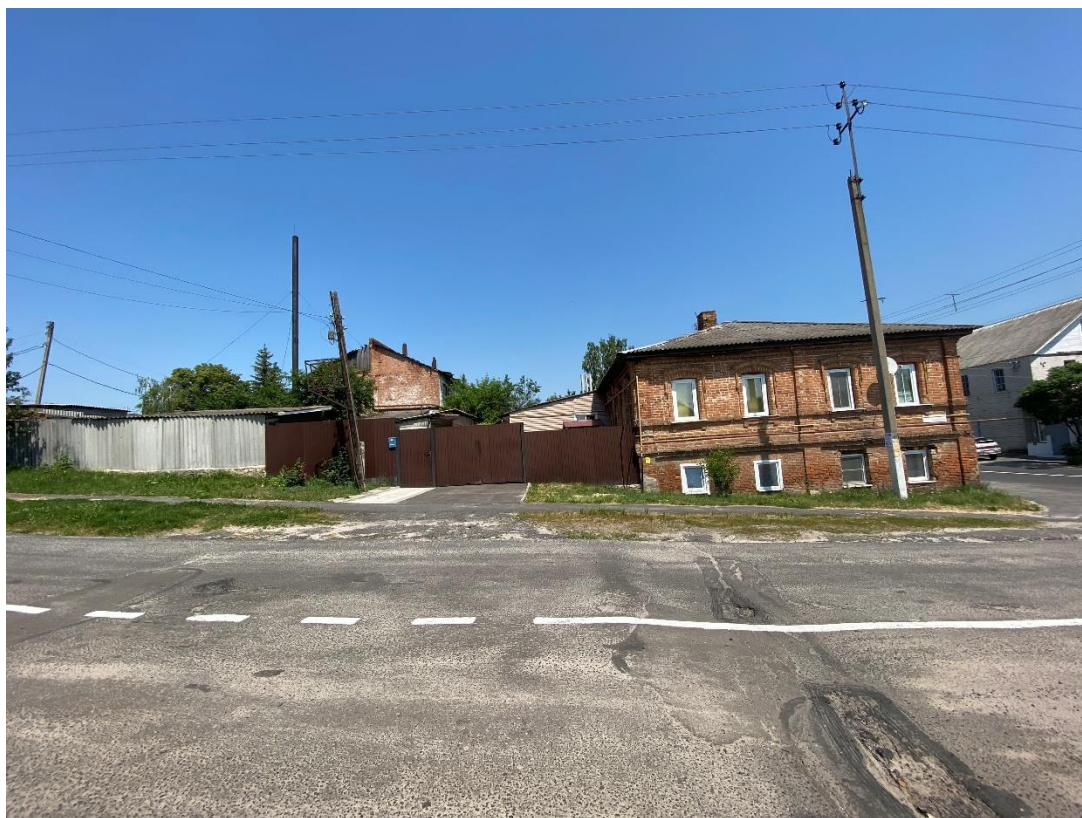
Фотография № 9. Вид с юго-востока на Объект.
