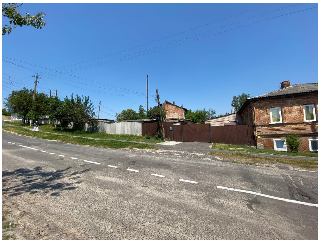
Фотография № 8. Вид с юго-востока на Объект.
