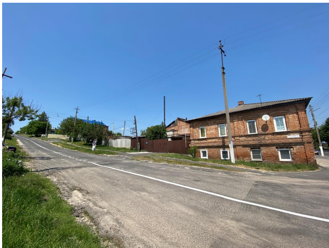
Фотография № 10. Вид с юго-востока на Объект.
