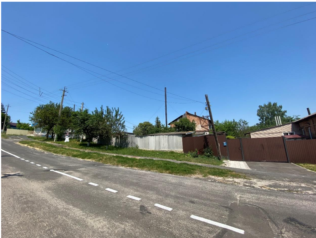
Фотография № 7. Вид с юго-востока на Объект.
