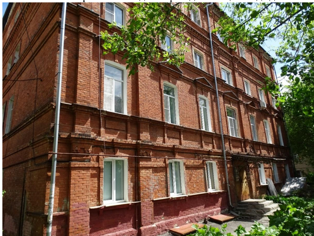
Фото 2. Общий вид западного фасада
