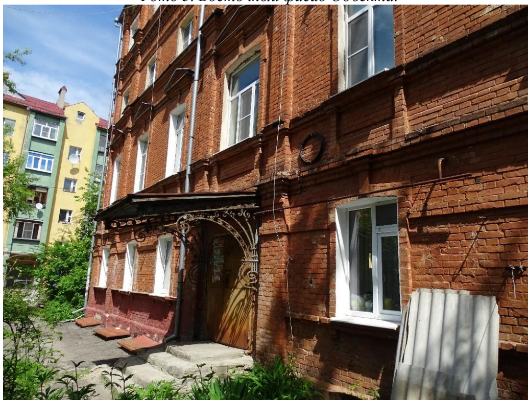
Фото 4. Навес над входной дверью.
