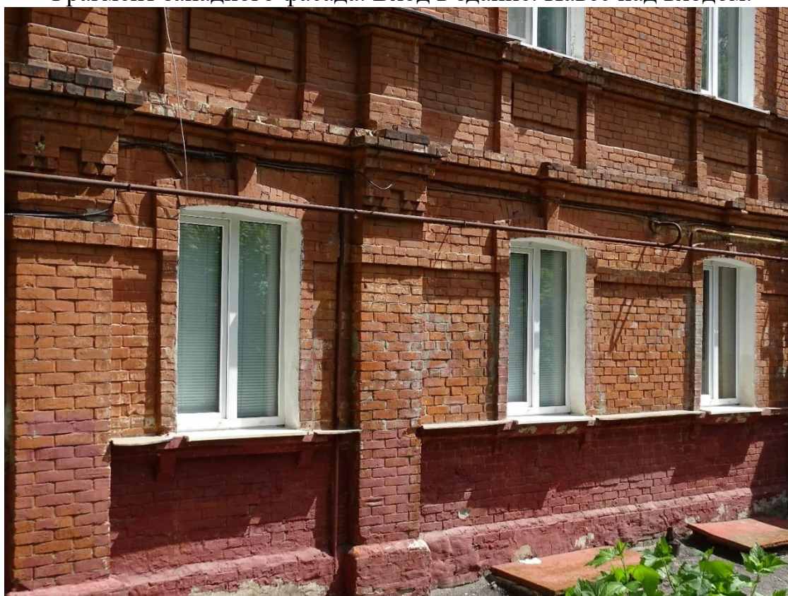
Фрагмент западного фасада. Окна первого этажа
