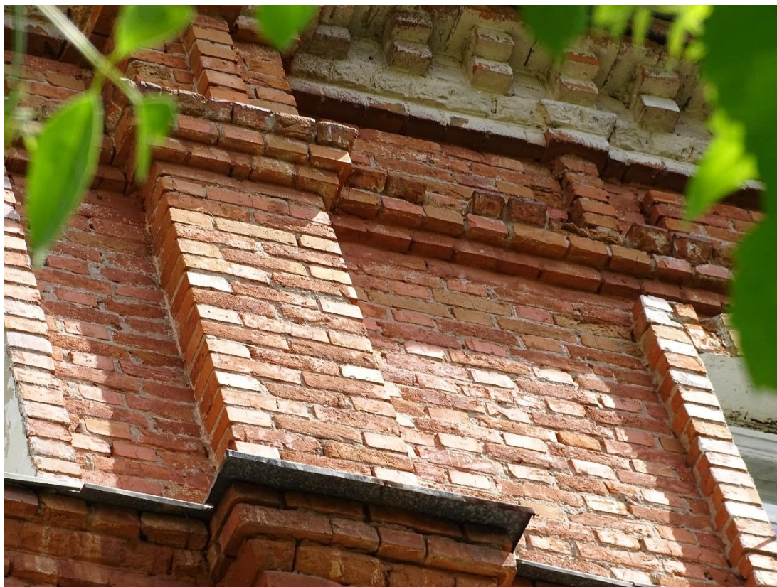
Фрагмент западного фасада. Пилястра в уровне четвертого этажа
