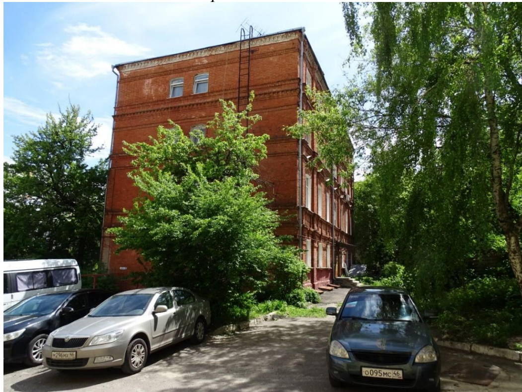
Фото 1. Северный и западный фасады. Общий вид здания
