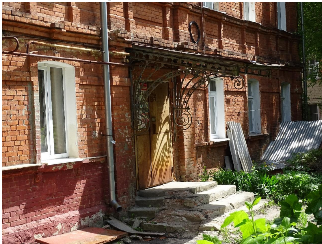
Фрагмент западного фасада. Вход в здание. Навес над входом.
