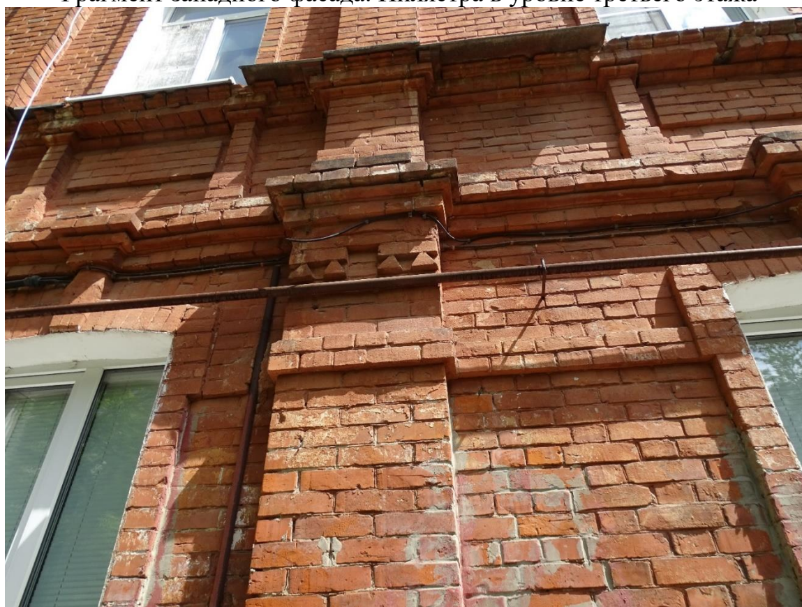
Фрагмент западного фасада. Пилястра в уровне первого и второго этажа
