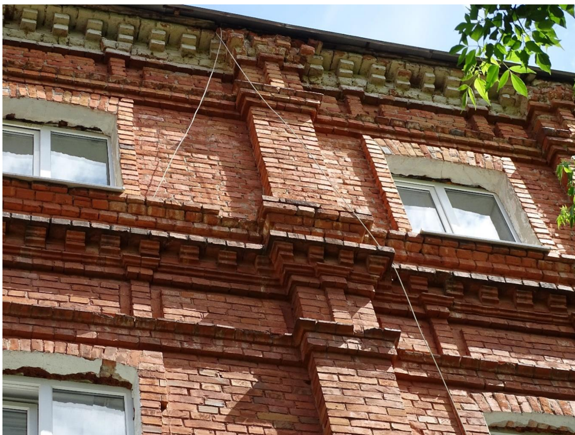
Фрагмент западного фасада. Венчающий карниз
