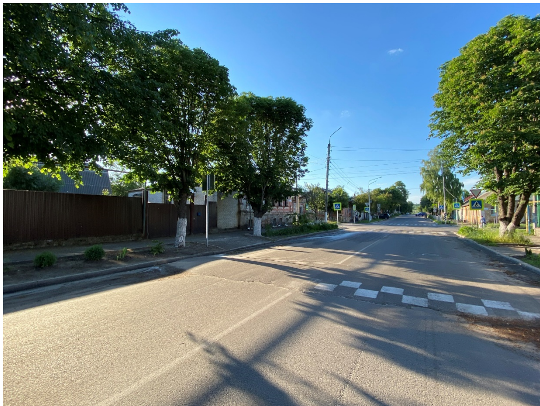
Фотография № 1. Вид с юго-востока на Объект.
