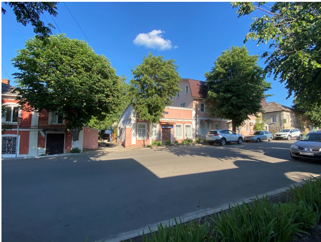
Фотография № 9. Вид с северо-запада на Объект.
