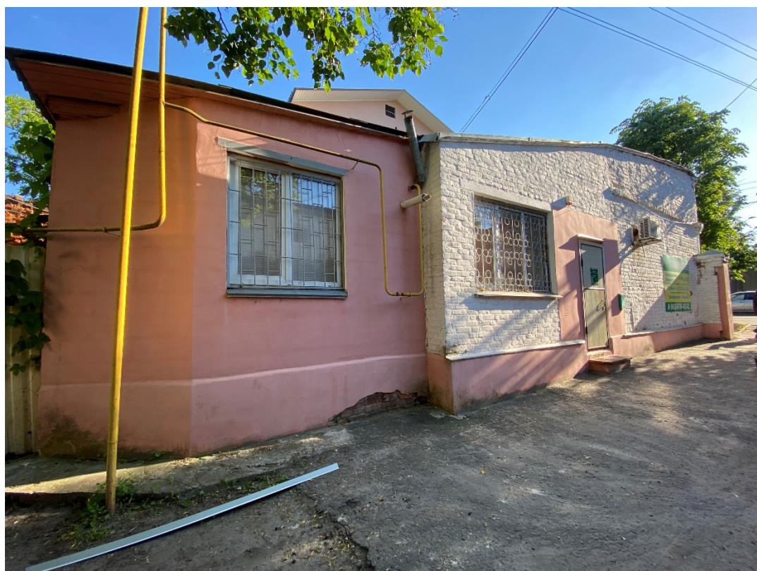
Фотография № 8. Вид с северо-востока на Объект.
