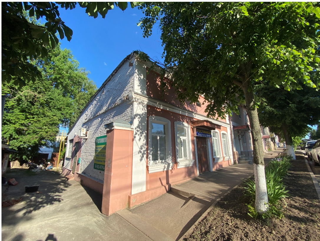
Фотография № 7. Вид с северо-запада на Объект.
