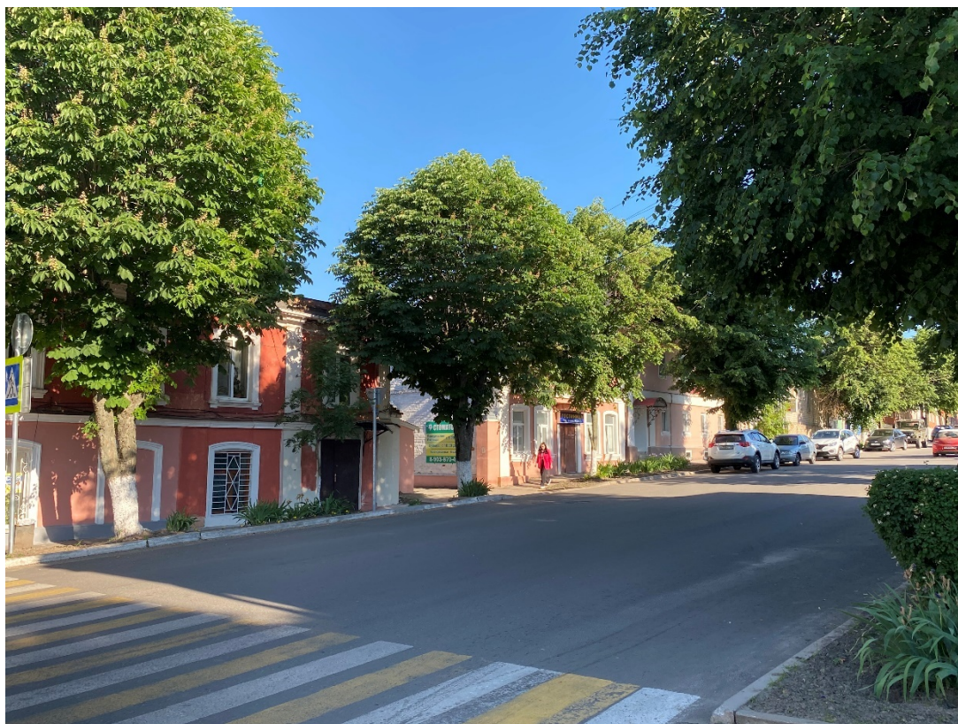
Фотография № 10. Вид с северо-запада на Объект.
