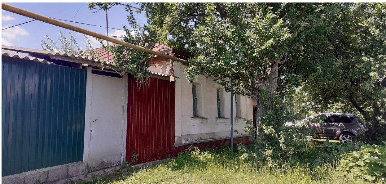
Фотография № 7. Вид с юго-востока на Объект.
