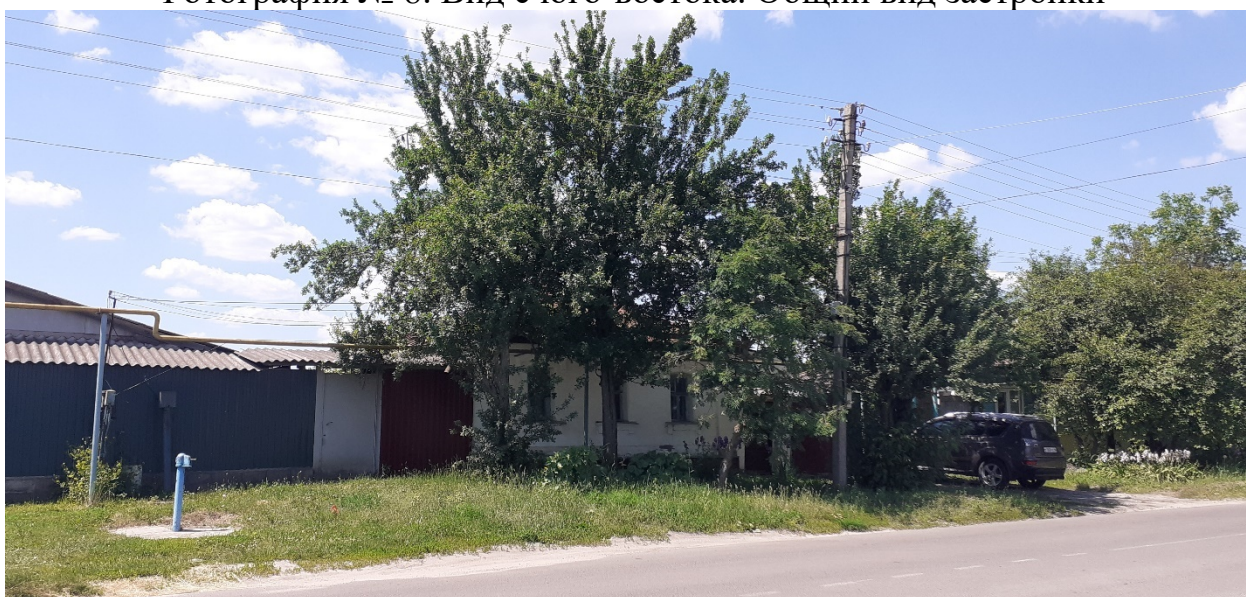
Фотография № 9. Вид с юго-востока на Объект.
