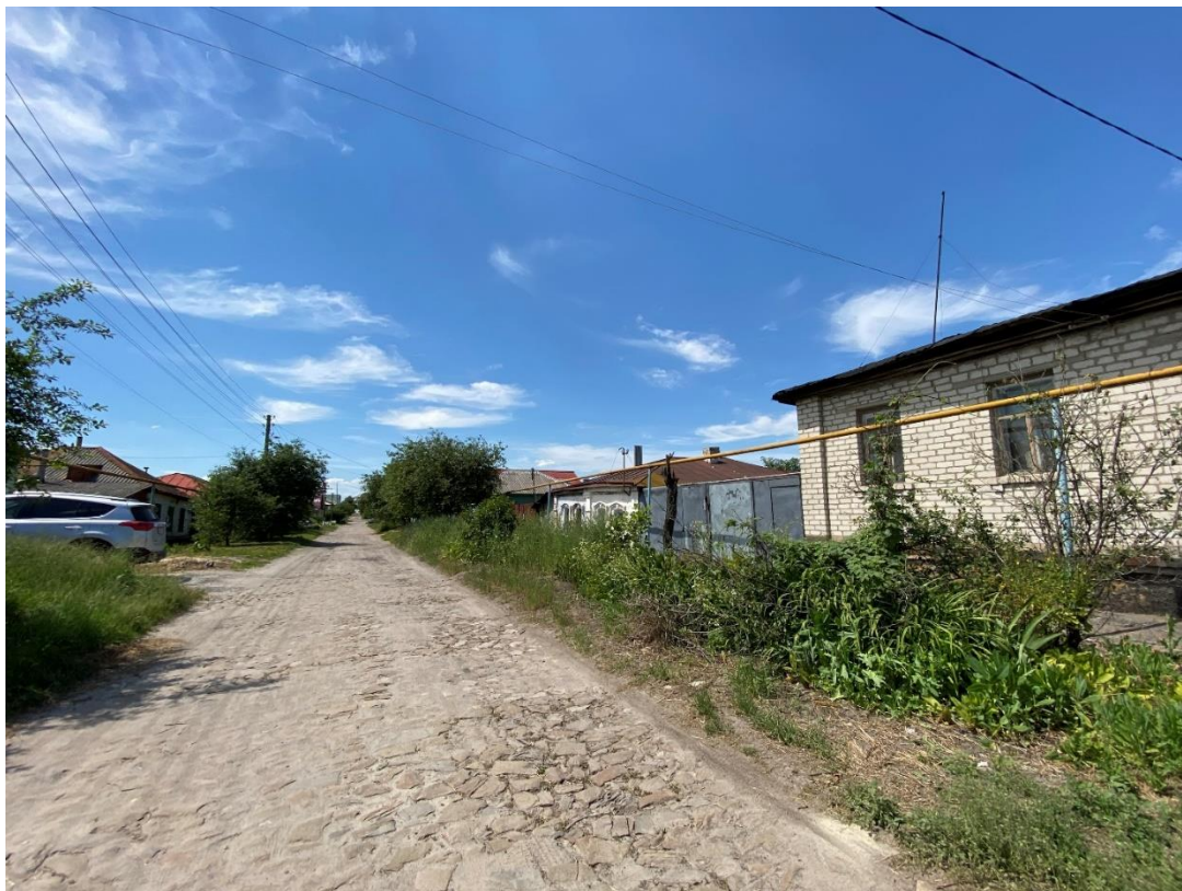
Фотография № 1. Вид с юго-востока на Объект.
