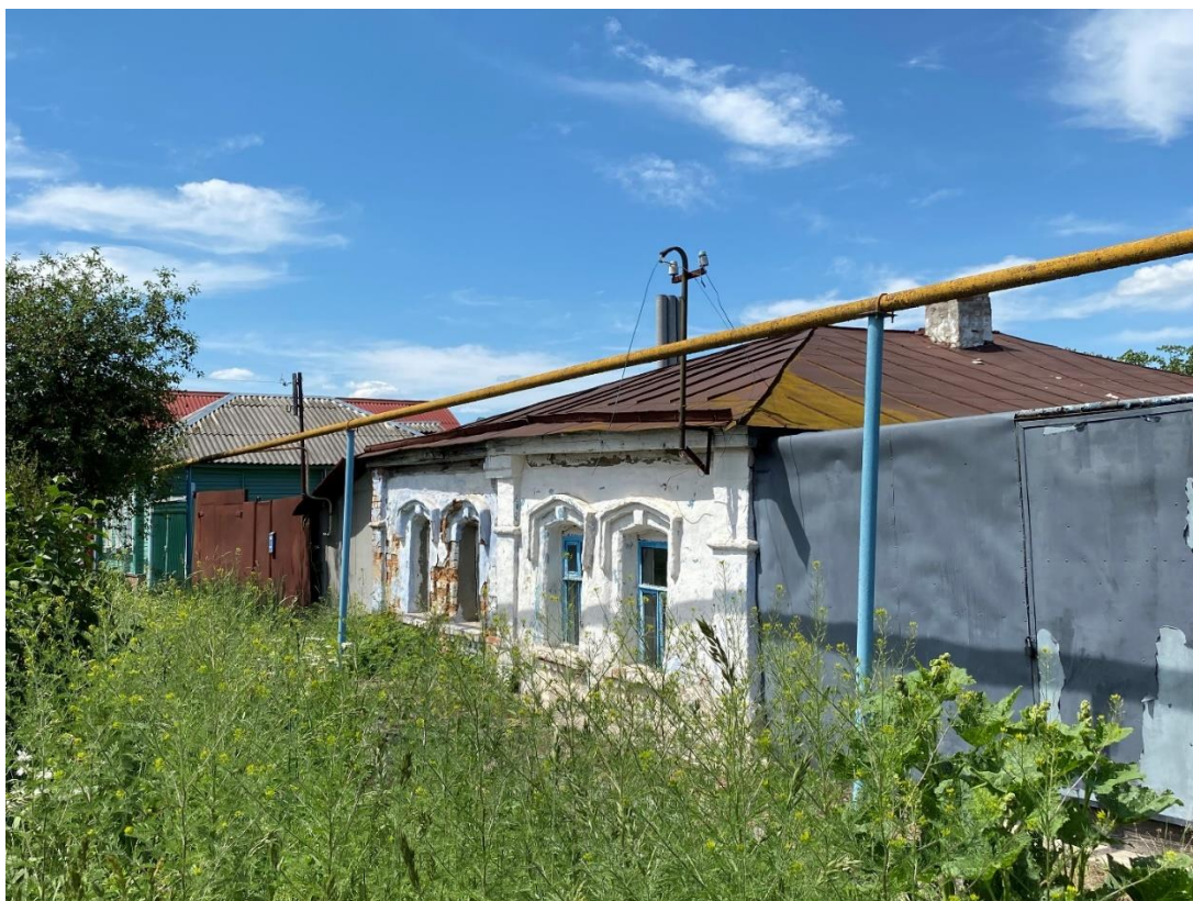
Фотография № 3. Вид с юго-востока на Объект.
