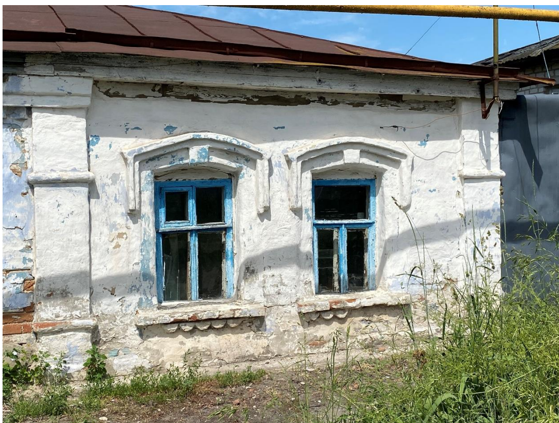
Фотография № 10. Вид с юга на Объект. Центральный фасад. Фрагмент.
