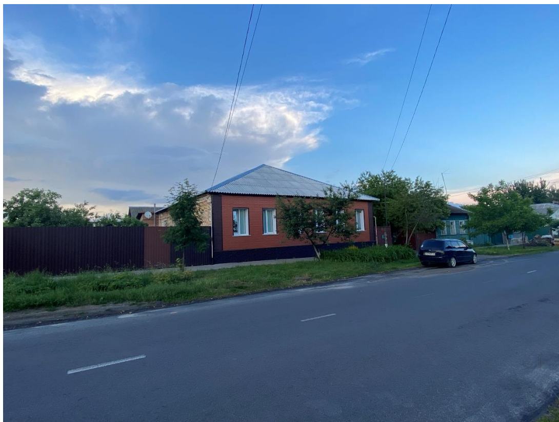
Фотография № 5. Вид с юго-запада на Объект.
