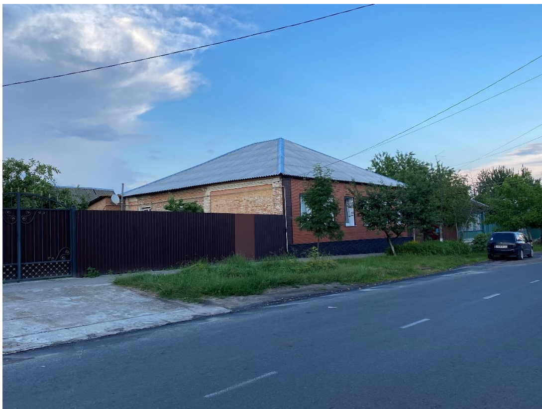
Фотография № 3. Вид с юго-запада на Объект.
