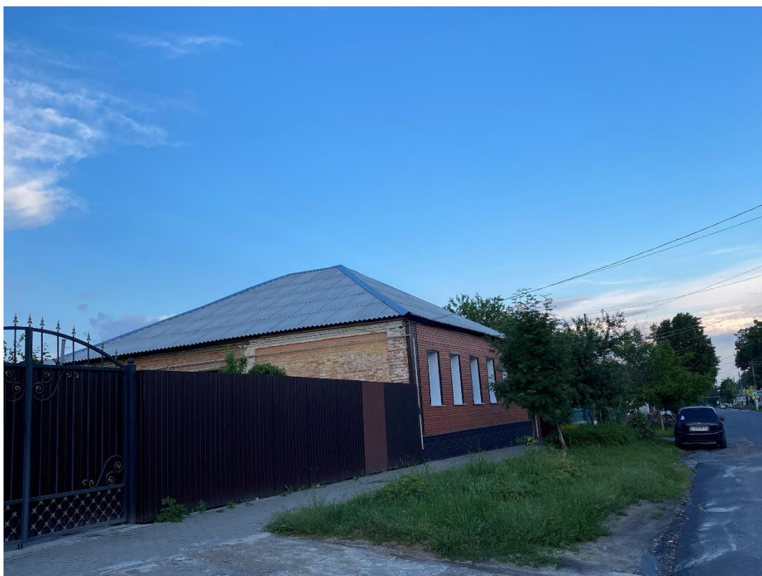
Фотография № 2. Вид с юго-запада на Объект.
