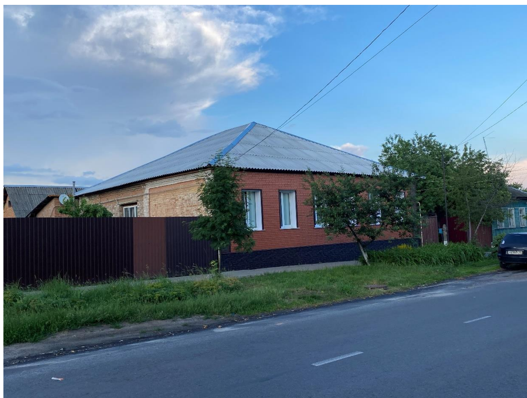
Фотография № 4. Вид с юго-запада на Объект.
