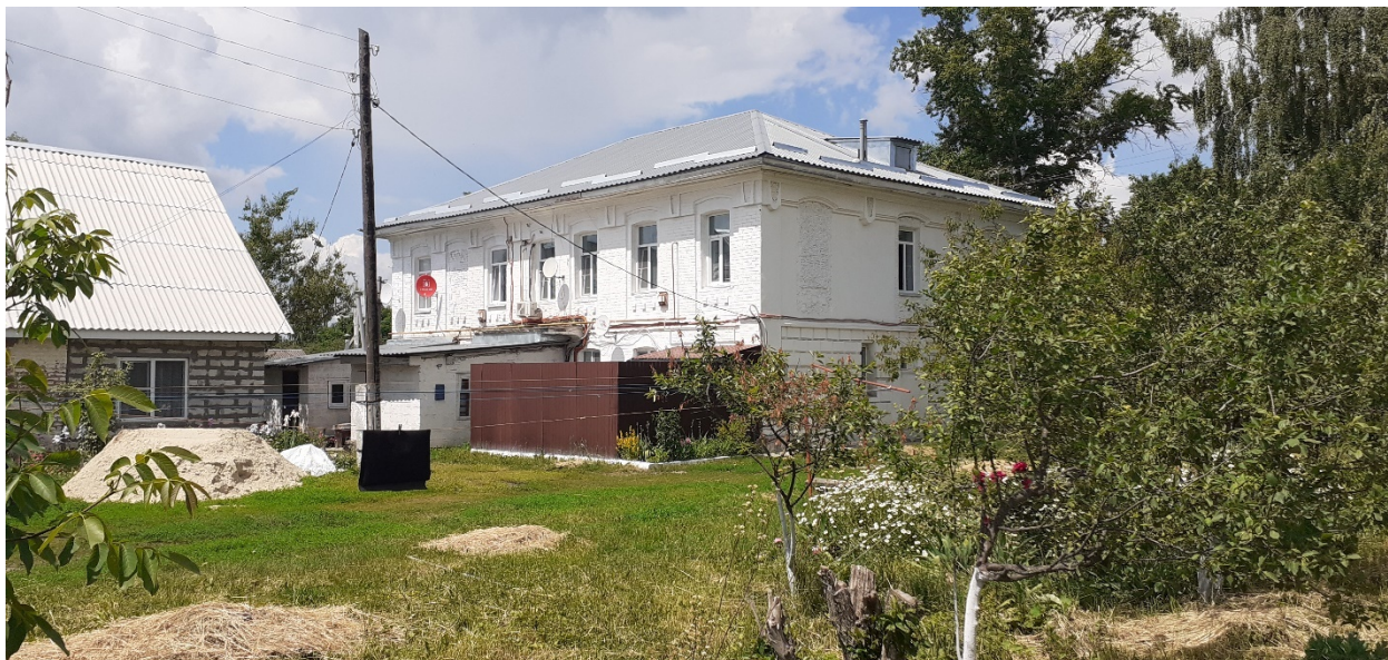
Фотография № 9. Вид с юго-востока на Объект.
