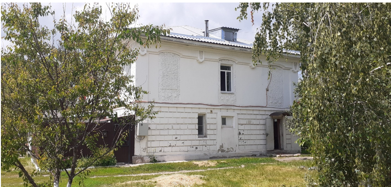
Фотография №8. Вид с юго-востока на Объект.
