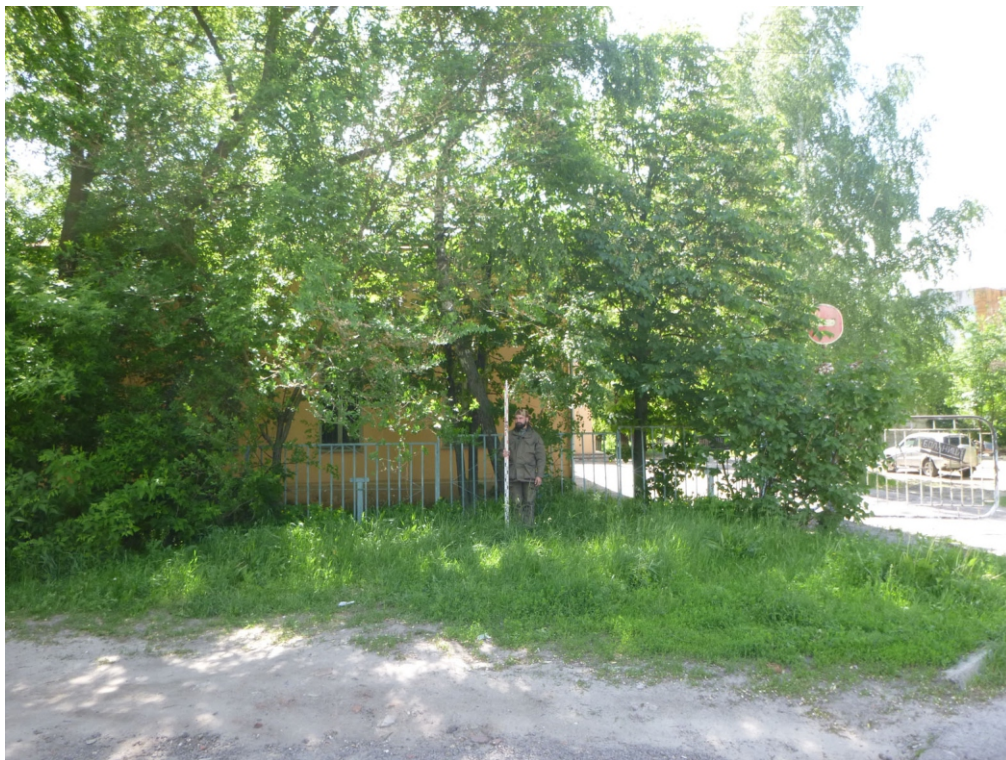
Илл. 10. КРО-2021. Г. Курск. Ул. Черняховского, стр. 52-а. Общий вид участка обследования. Точка № 1. Снимок № 2. Вид с СЗ.
