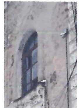
Оконное заполнение оконного проема с арочной фрамугой
