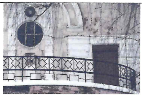
Фрагмент второго этажа северо-западного фасада
