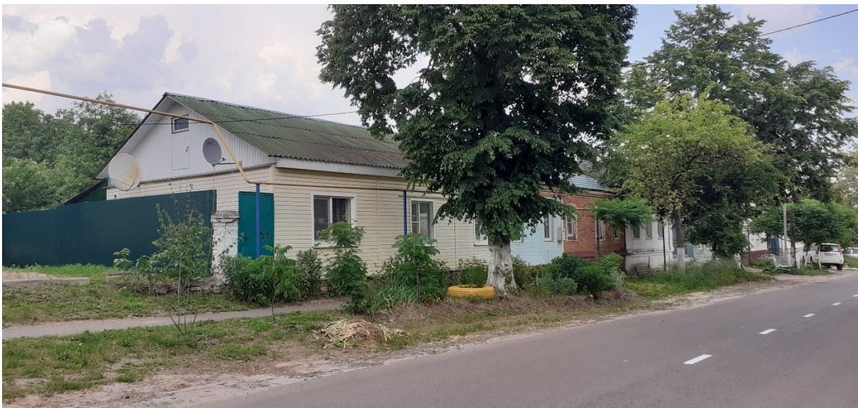
Фотография № 3. Вид с юго-запада на Объект.
