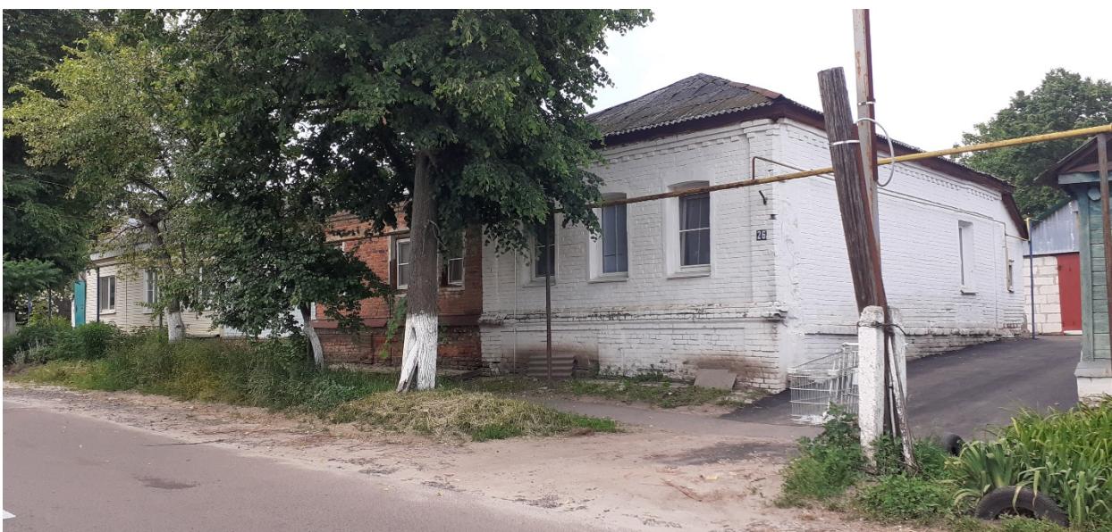
Фотография № 10. Вид с юго-востока на Объект.
