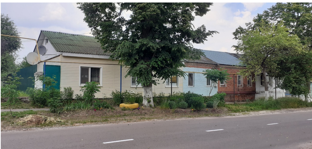
Фотография № 4. Вид с юго-запада на Объект.
