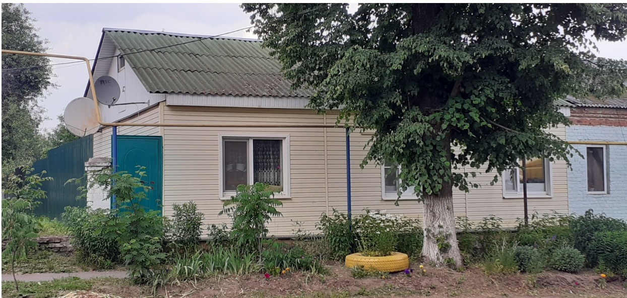
Фотография № 5. Вид с юго-запада на Объект.
