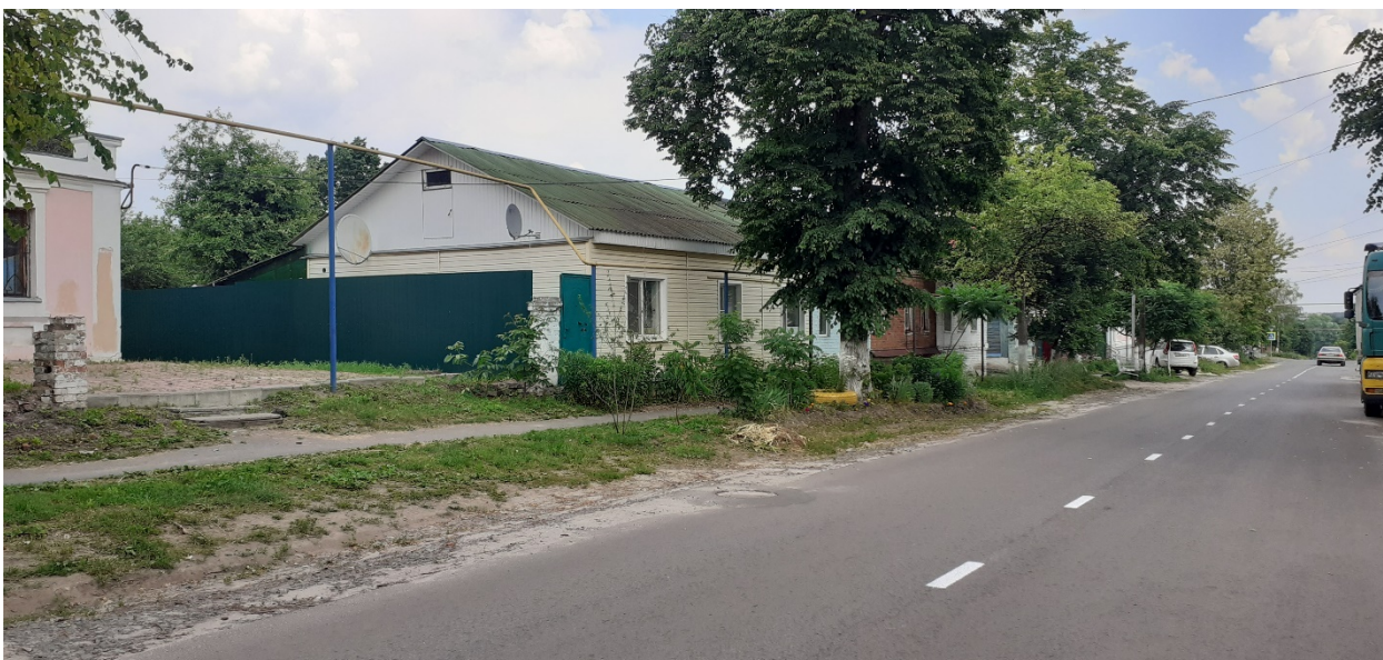
Фотография № 2. Вид с юго-запада на Объект.
