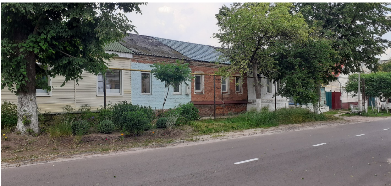
Фотография № 6. Вид с юго-запада на Объект.
