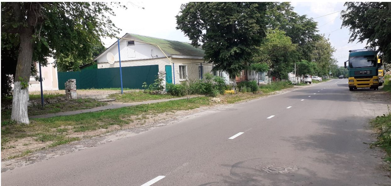
Фотография № 1. Вид с юго-запада на Объект.
