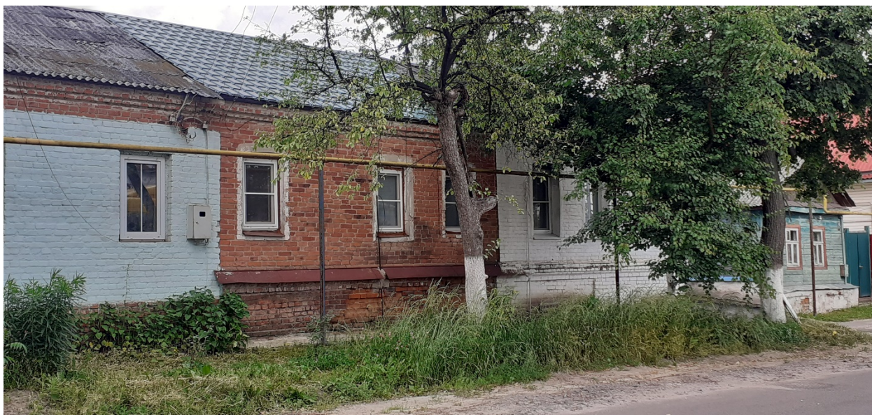
Фотография № 7. Вид с юго-запада на Объект.
