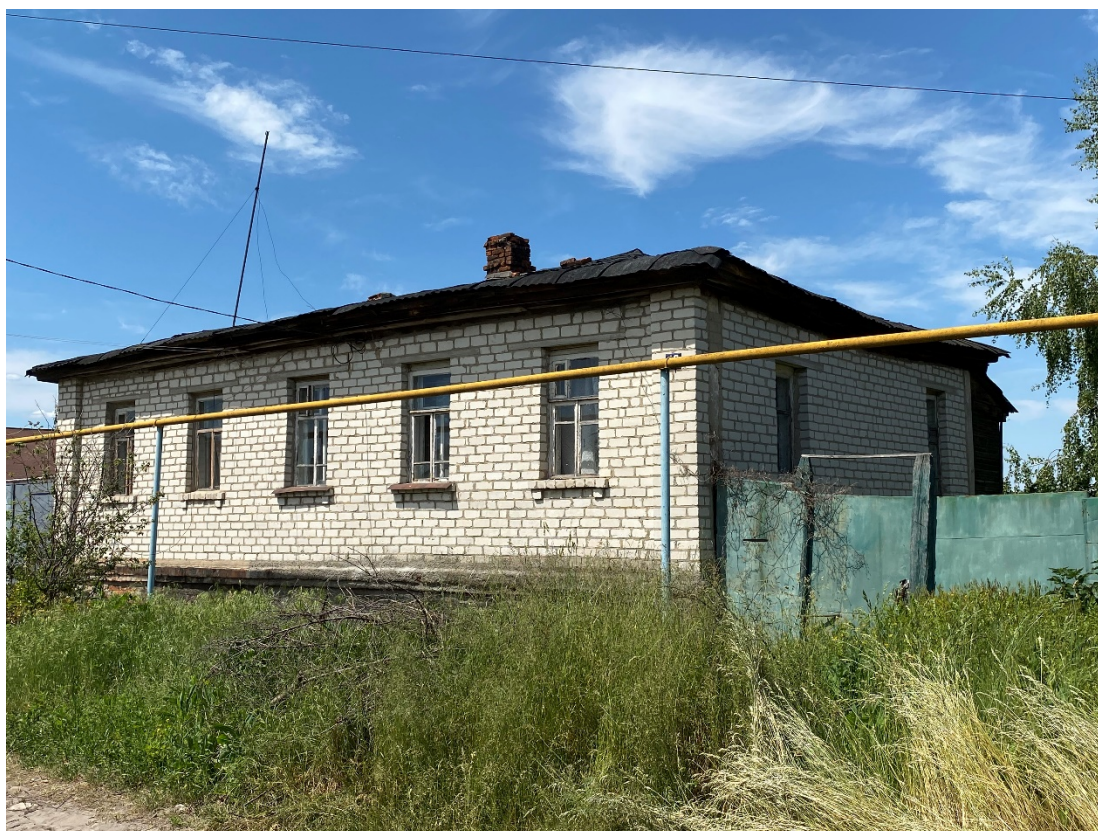
Фотография № 4. Вид с юго-востока на Объект.
