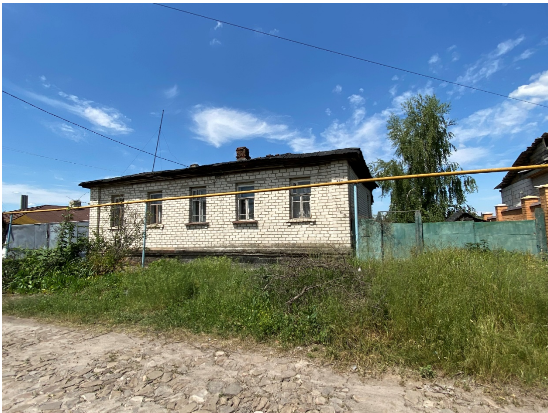
Фотография № 5. Вид с юго-востока на Объект.
