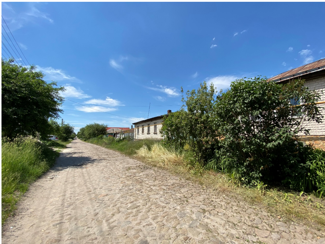
Фотография № 1. Вид с юго-востока на Объект.
