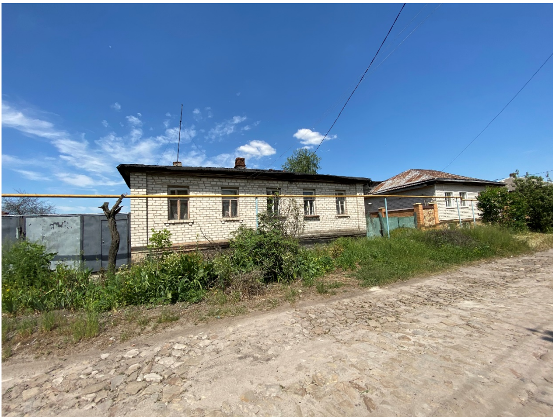
Фотография № 7. Вид с юго-запада на Объект.
