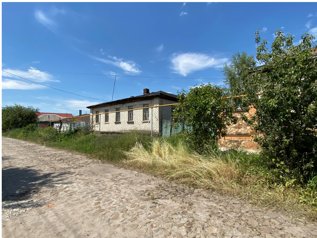
Фотография № 2. Вид с юго-востока на Объект.
