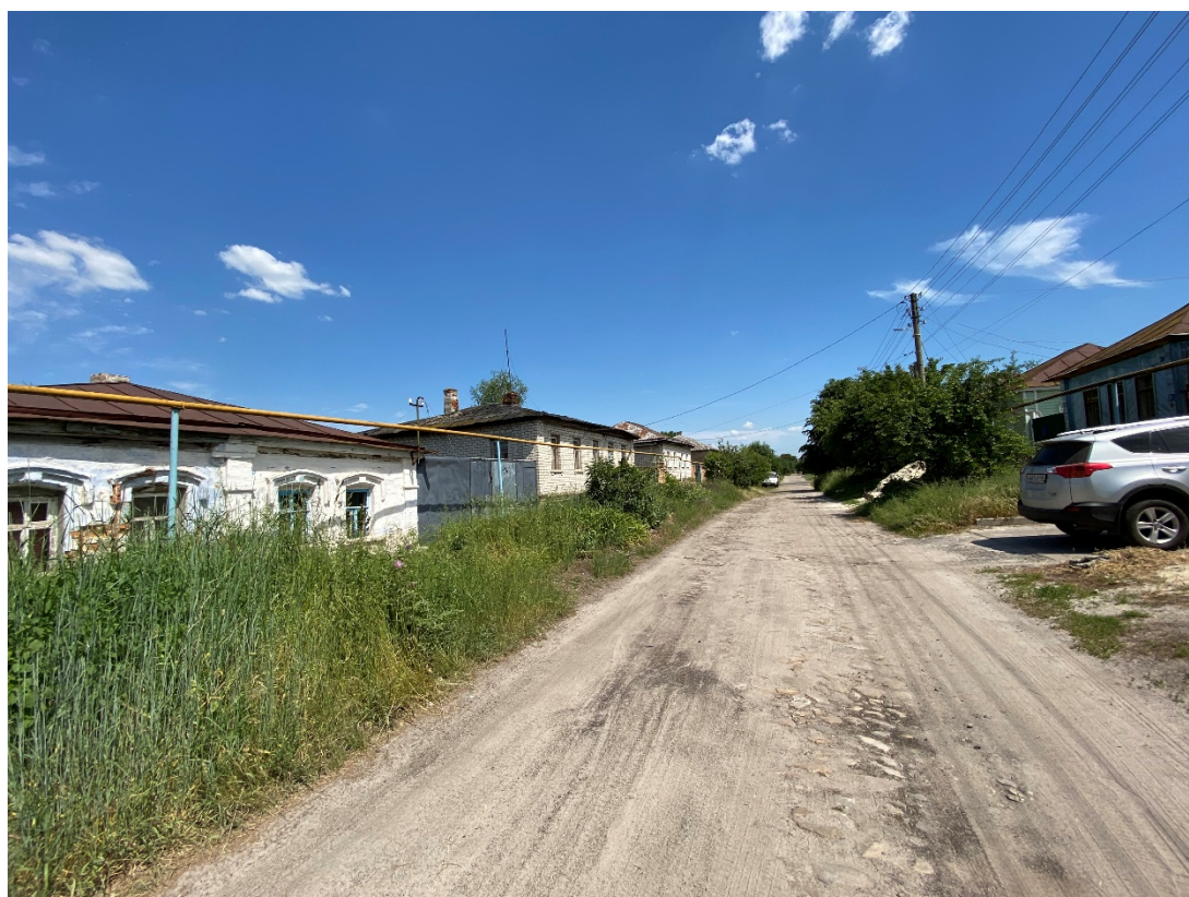
Фотография № 10. Вид с юго-запада на Объект.
