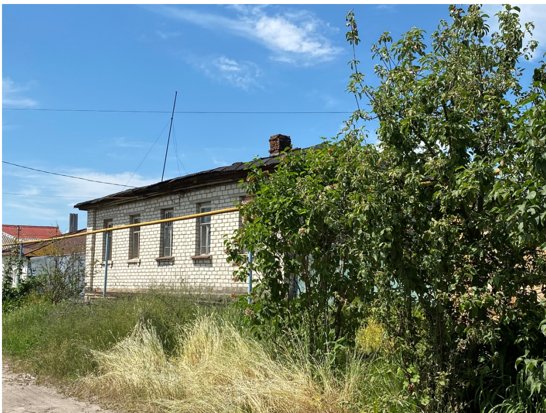
Фотография № 3. Вид с юго-востока на Объект.
