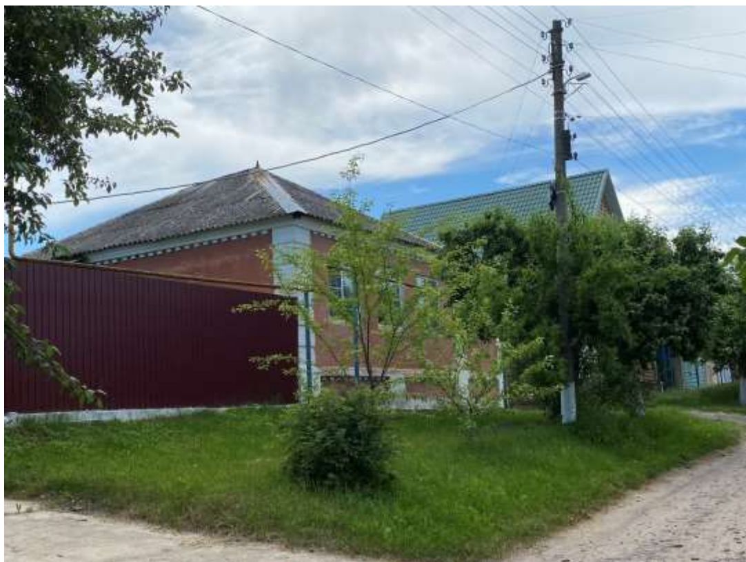
Фотография № 3. Вид с северо-востока на Объект.
