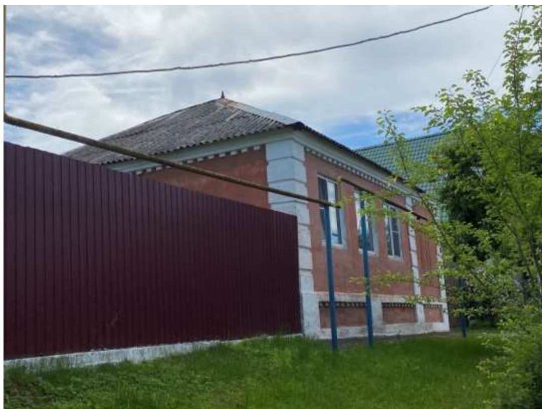
Фотография № 4. Вид с северо-востока на Объект.
