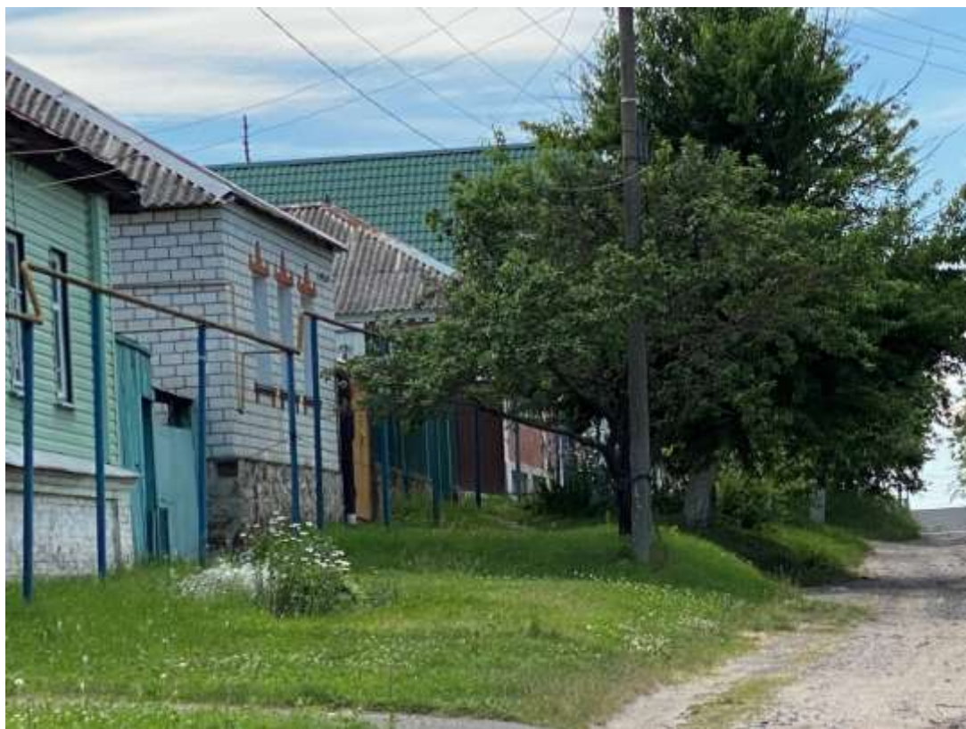
Фотография № 1. Вид с северо-востока на Объект.
