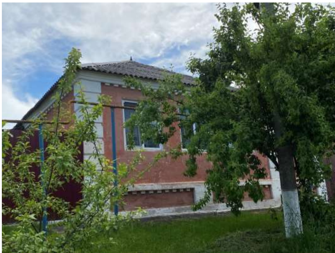
Фотография № 5. Вид с северо-востока на Объект.
