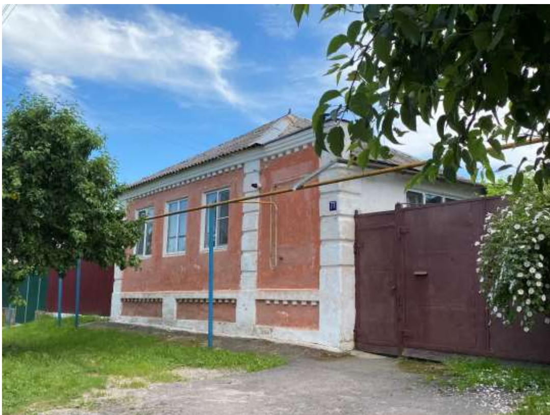
Фотография № 8. Вид с северо-запада на Объект.
