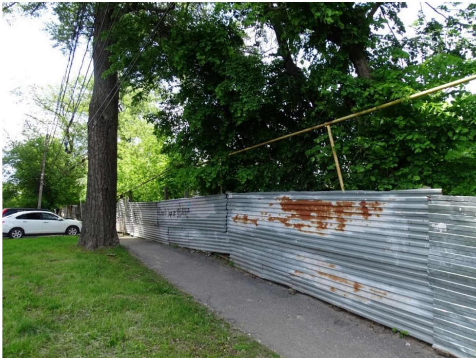
Фото 1. Фрагмент ограждающей конструкции.
