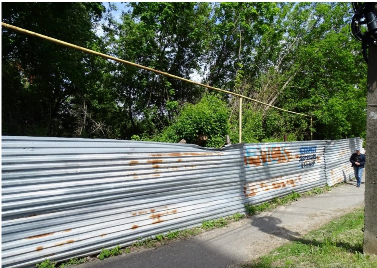
Фото 3 Фрагмент ограждающей конструкции.
