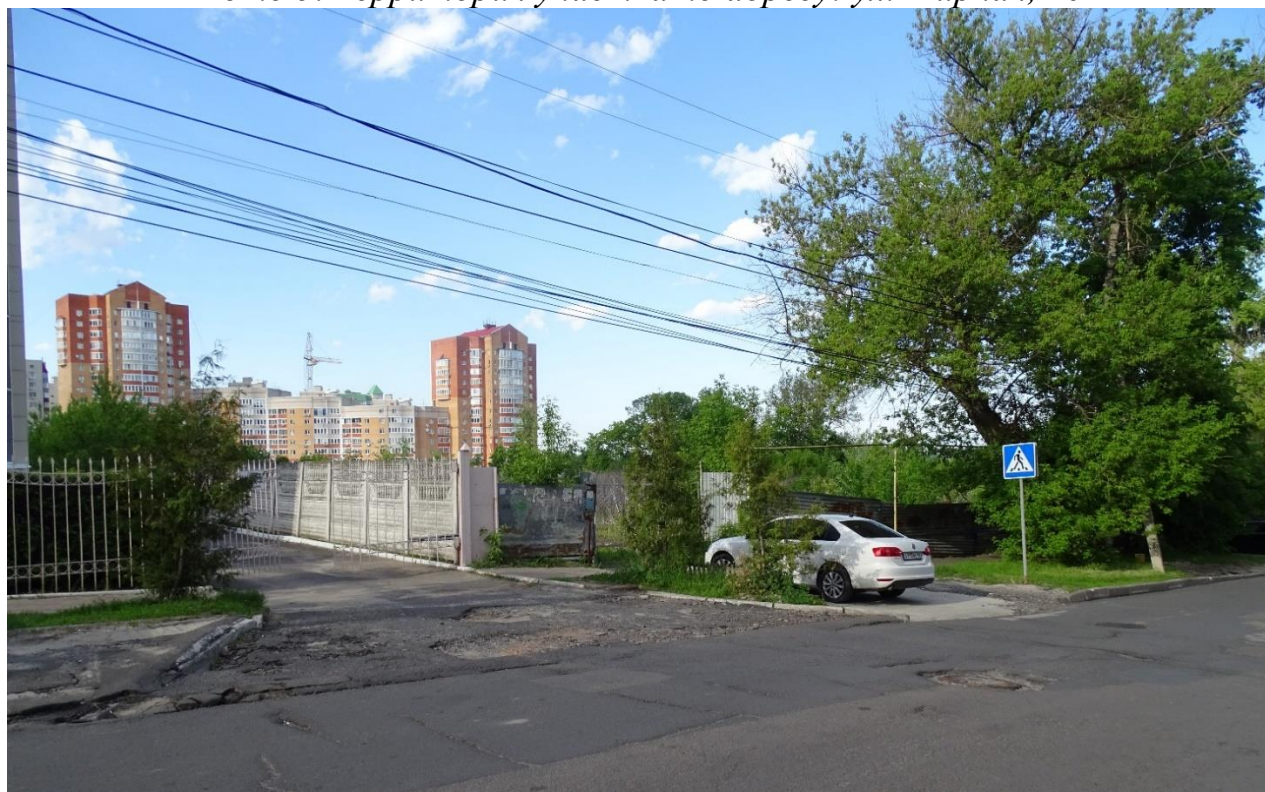
Фото 6. Фрагмент ограждающей конструкции. Проезд между домом № 20 и пустующей территорией
