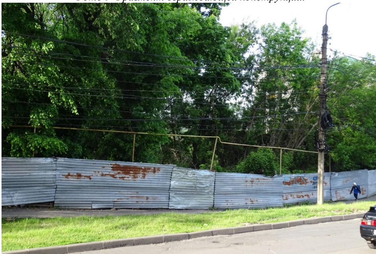
Фото 10. Фрагмент ограждающей конструкции.
