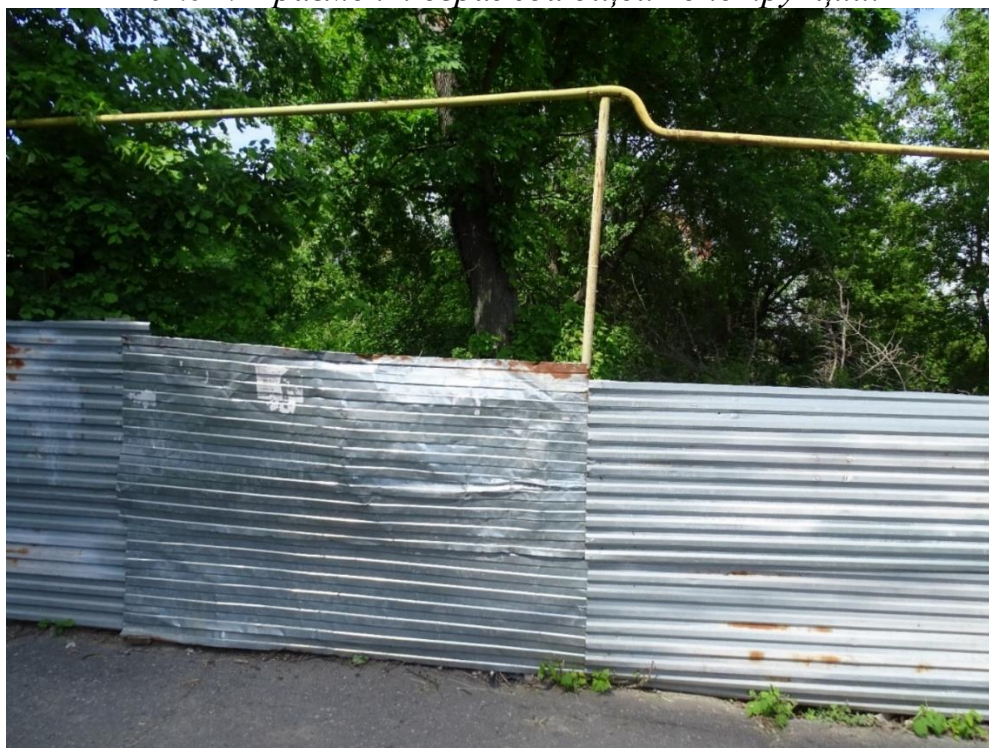
Фото 2. Фрагмент ограждающей конструкции.
