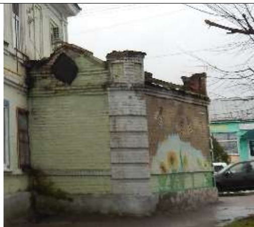
лицевой и дворовый фасады с фронтонами, обрамленными профильным карнизом
