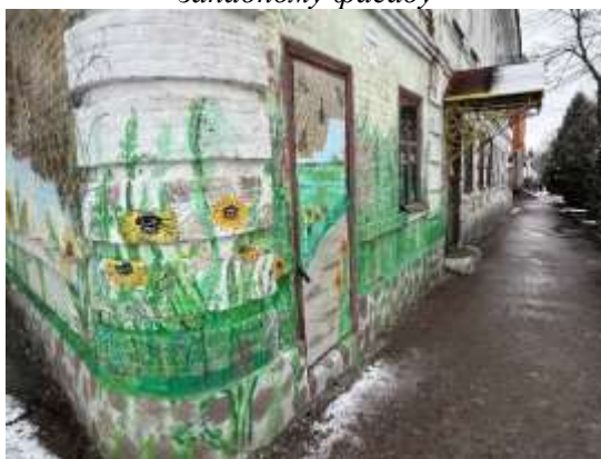
. Скругленные углы с рустованными лопатками
