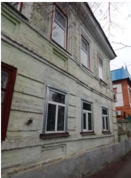
Т.ф. 2. Отдельные элементы декоративного убранства главного фасада Объекта со стороны ул. 1 Мая.
