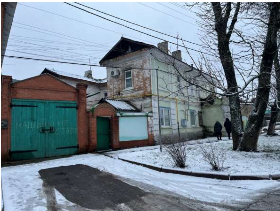
Т.ф. 5. Общій вид бокового фасада Объекта.
