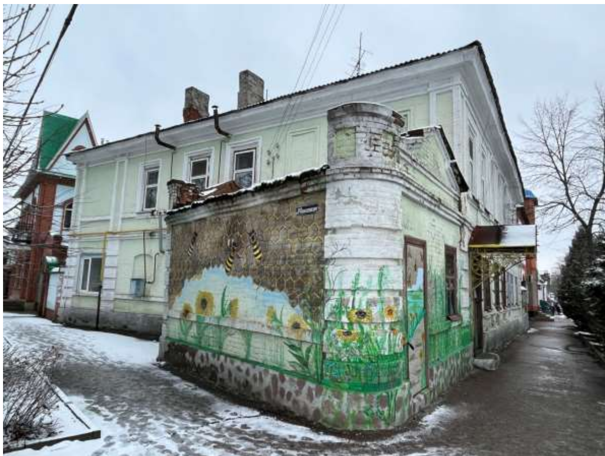
Т.ф. 3. Общий вид Объекта с перекрестка улиц 1 Мая и Розы Люксембург.
