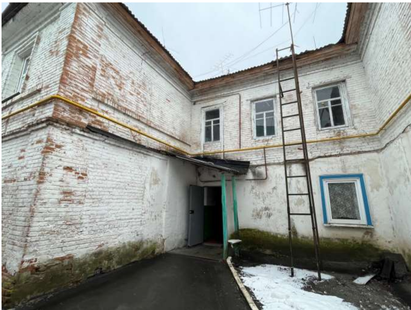
Т.ф. 7. Общий вид дворовой территории Объекта.
