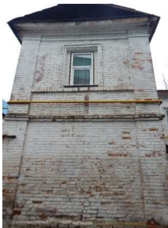
гладкие угловые лопатки; междуэтажный карниз в виде полочки; подоконная тяга, подоконный гладкий фриз
