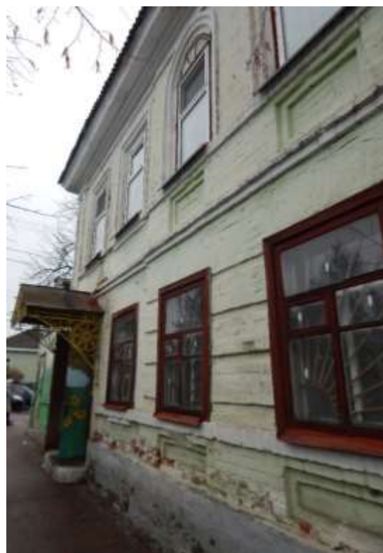
Декор оконных проемов первого и второго этажей; руст первого этажа
