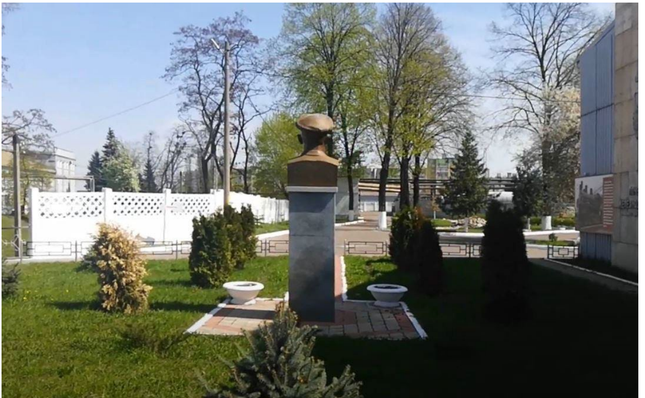
Фото 4. Общий вид Объекта с западной стороны.
