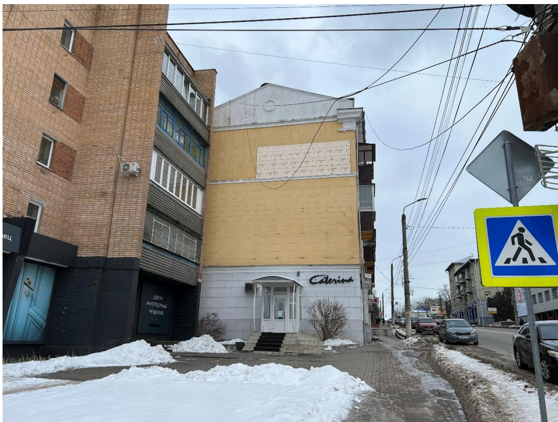
Фотография № 3. Вид с северо-востока на Объект.
