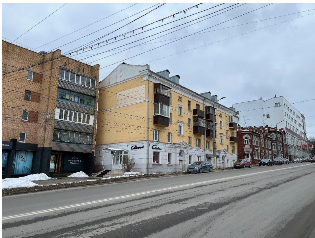
Фотография № 2. Вид с северо-востока на Объект.
