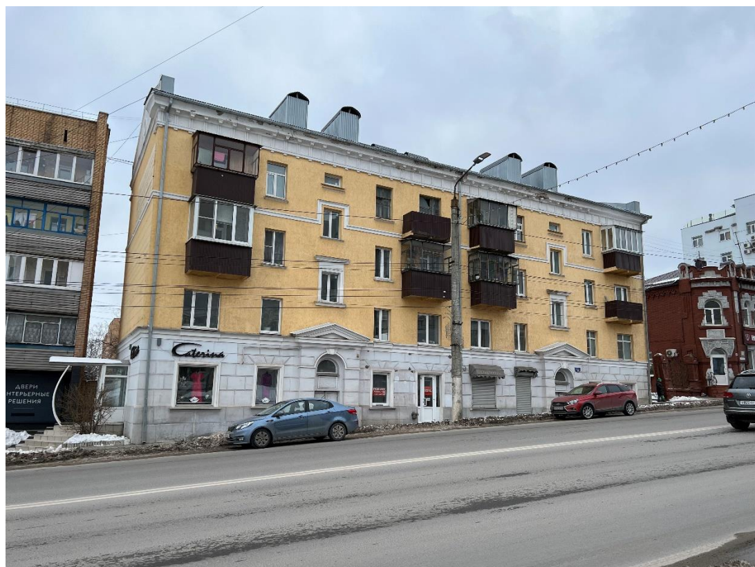
Фотография № 4. Вид с севера на Объект.
