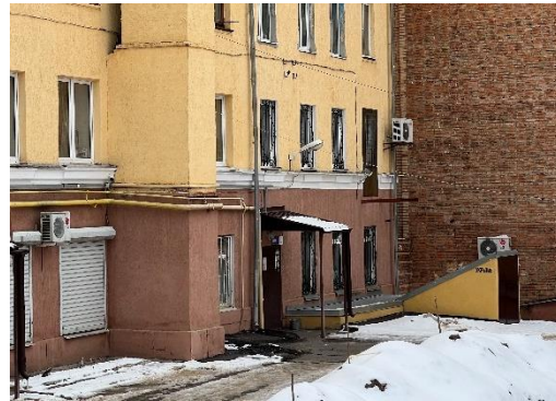
Вход в подвал
