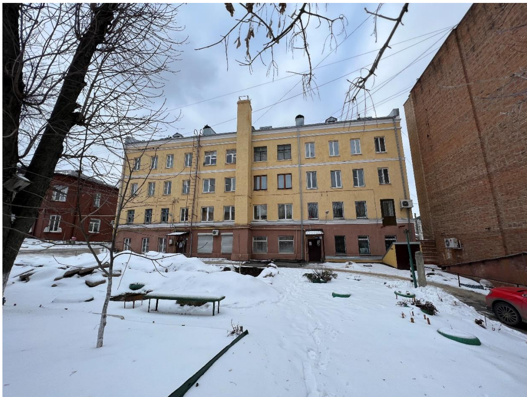
Фотография № 9. Вид с юго-востока на Объект.
