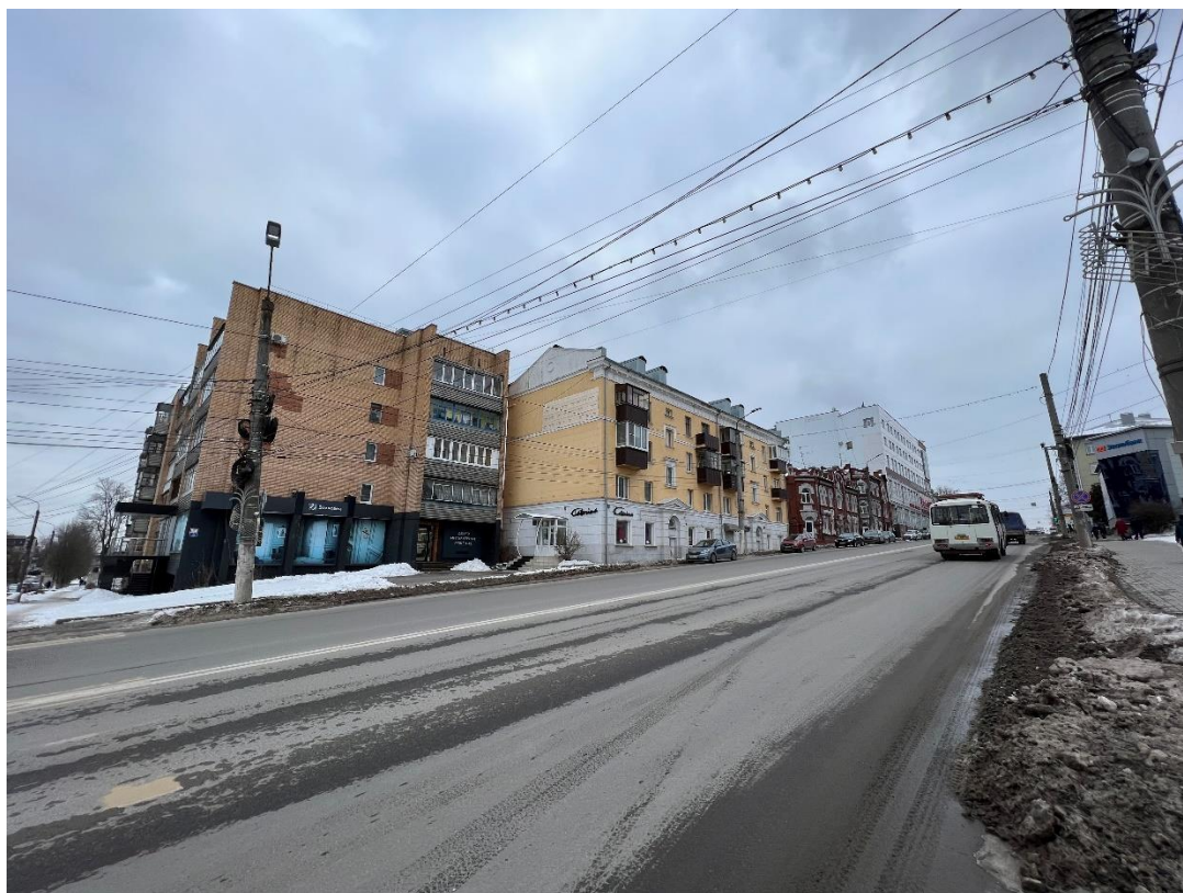
Фотография № 1. Вид с северо-востока на Объект.
