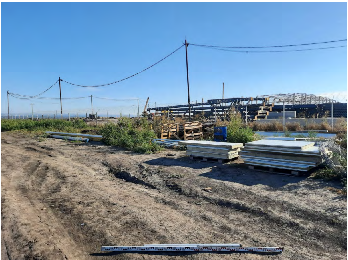
Илл. 18. Курская область, Курский район, д. Ворошнево. 2022 г. Фото участка исследования, вид с ЮЗ. Точка фотофиксации №10.
