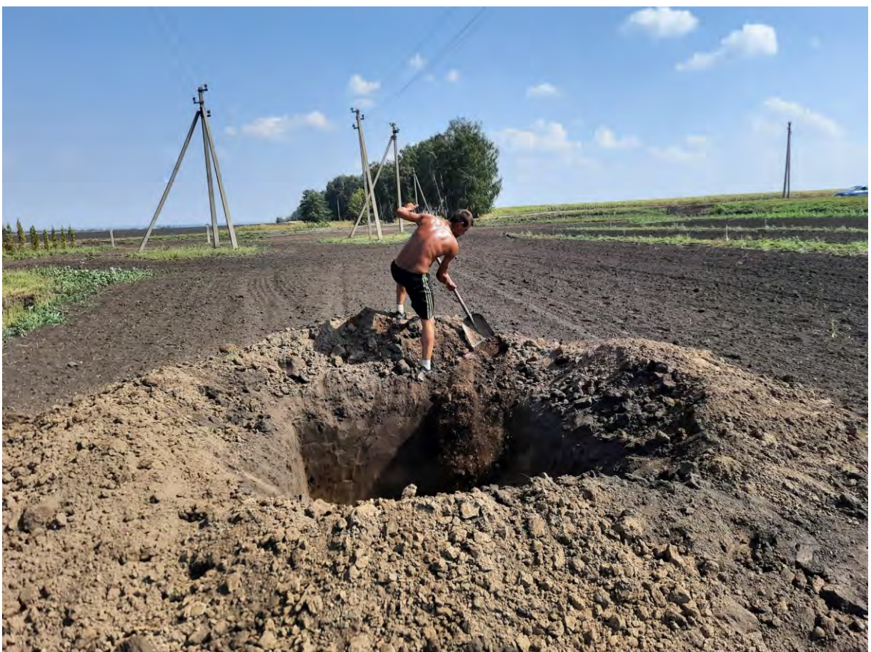
Илл. 54. Курская область, Курский район, д. Ворошнево. 2022 год. Процесс работ. Рекультивация шурфа 1, вид с З.
