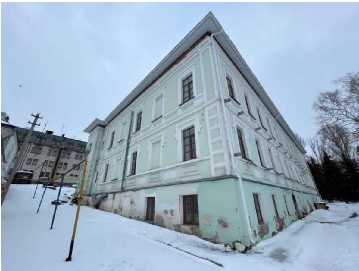
Т.ф. 4. Общий вид Объекта с южной и западной сторон
