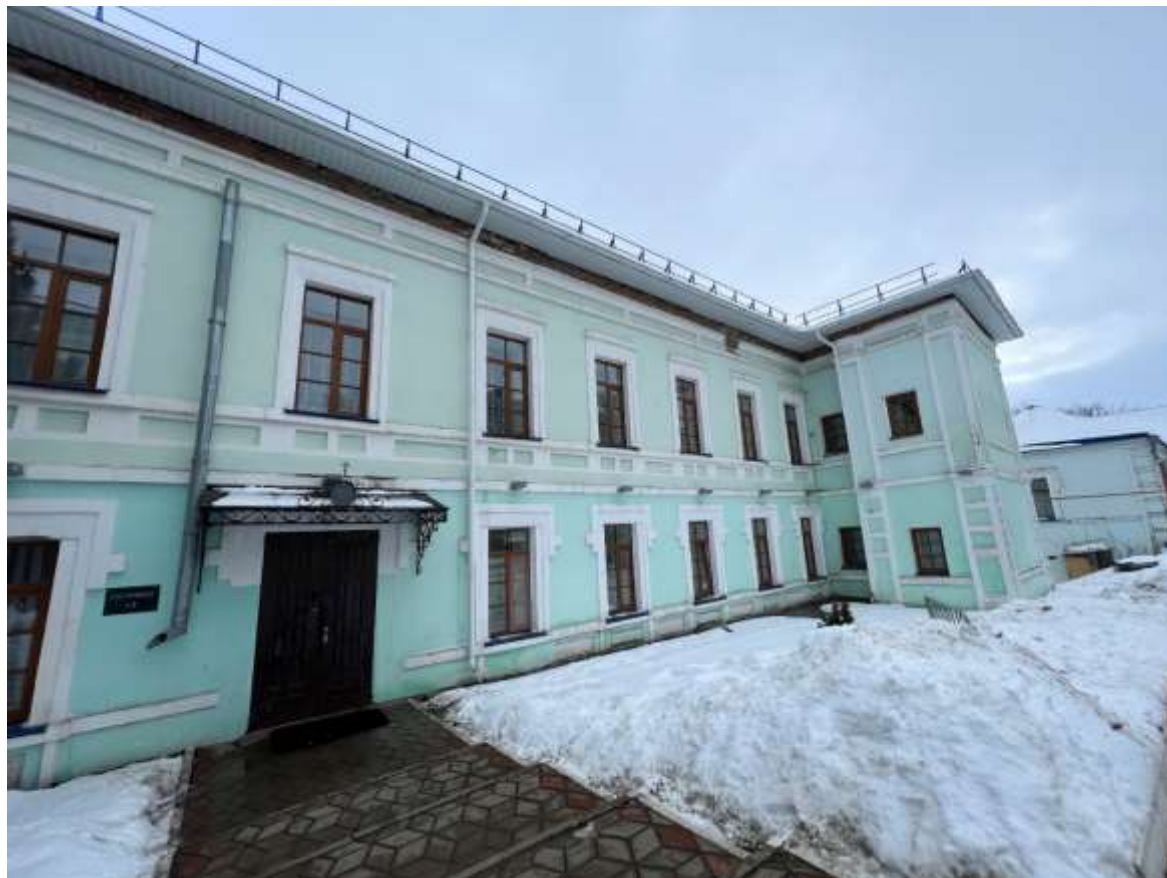
Т.ф. 7. Входная группа в здание со стороны северного фасада
