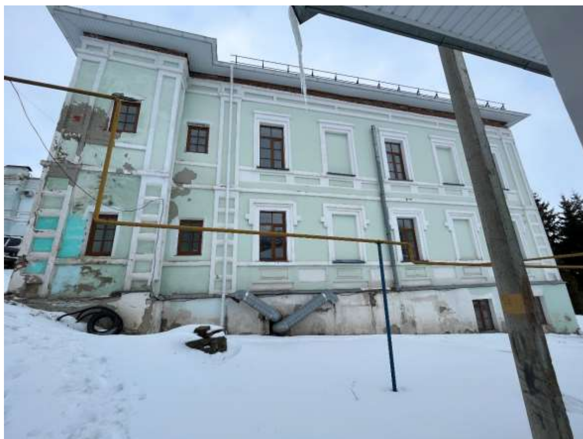
Т.ф. 5. Общий вид западного фасада Объекта
