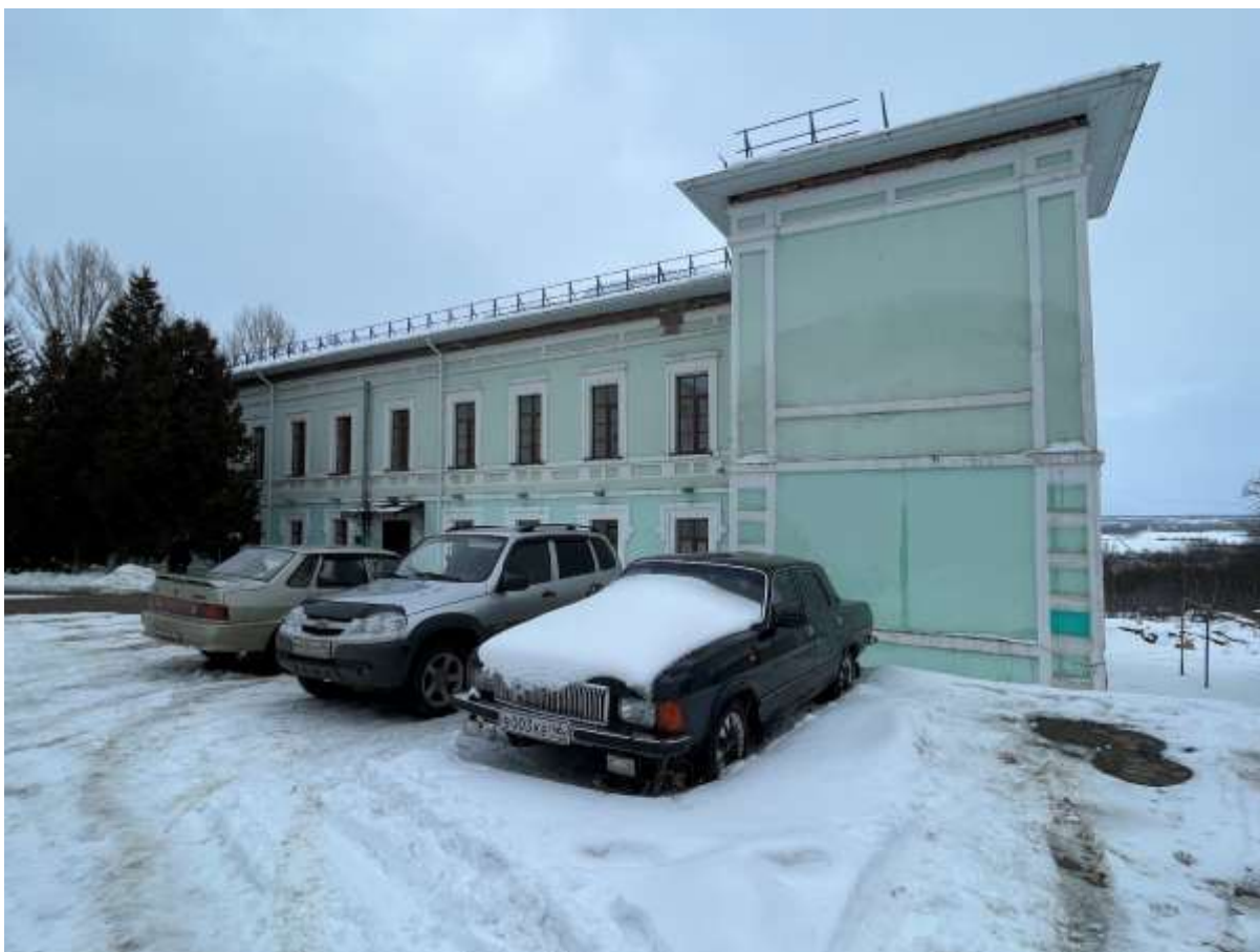
Т.ф. 6. Общий вид северного фасада Объекта
