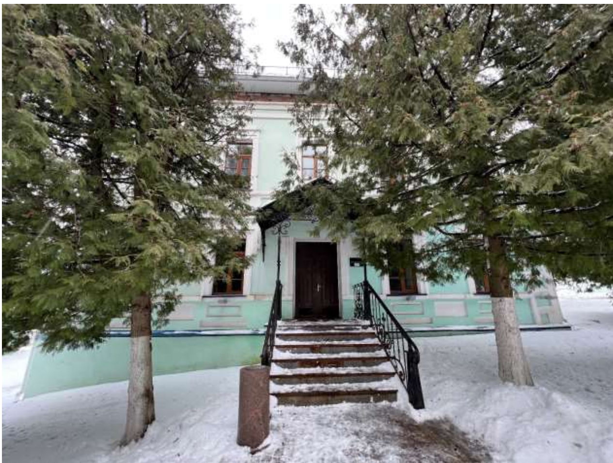
Т.ф. 2. Входная группа в здание со стороны восточного фасада
