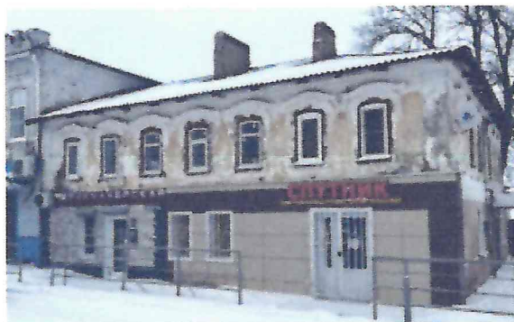
Вид на южный фасад
