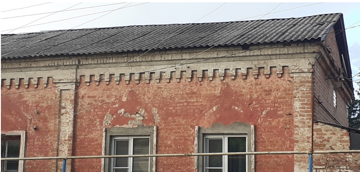
Фотография № 10. Вид с запада на Объект. Центральный фасад. Фрагмент.
