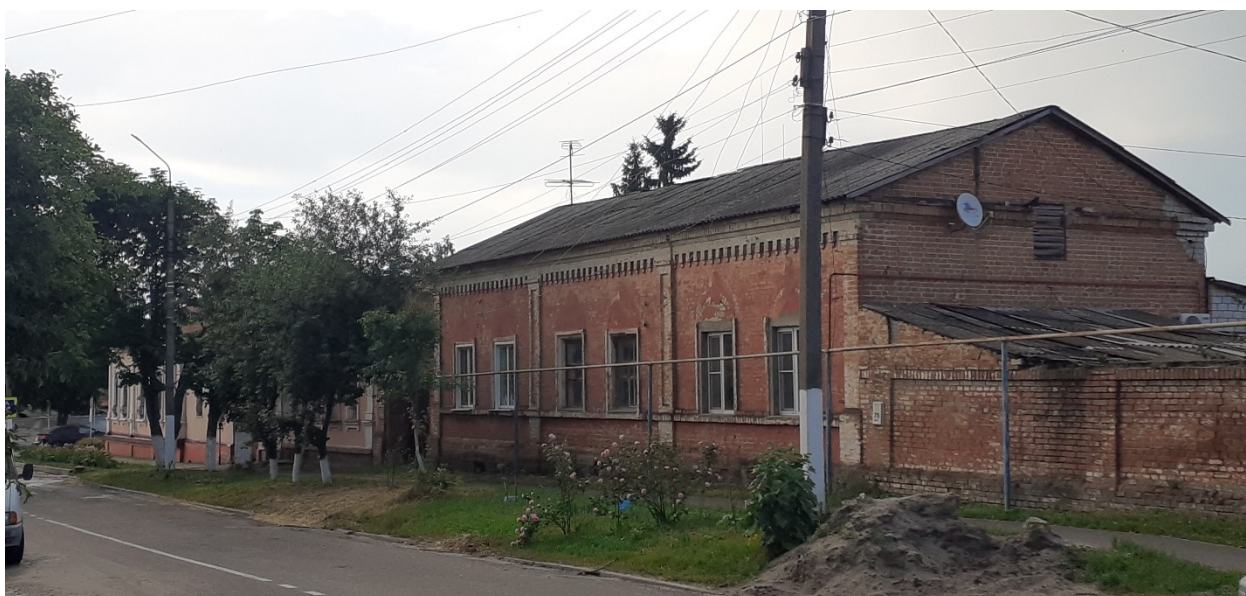
Фотография № 4. Вид с юго-запада на Объект.
