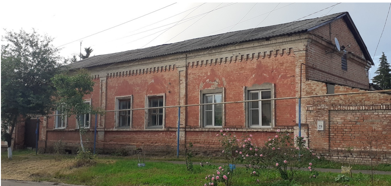
Фотография № 5. Вид с юго-запада на Объект.
