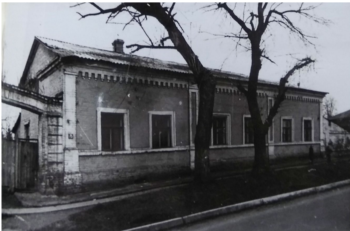
16. Дом по ул. Урицкого, 75. Здание Объекта на фотографии в «Проекте охранных зон г. Рыльска Курской обл.» 1990 года.
