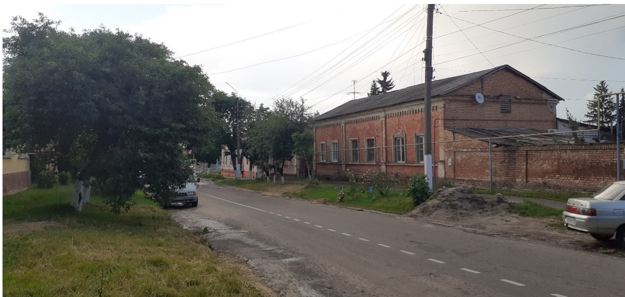
Фотография № 3. Вид с юго-запада на Объект.
