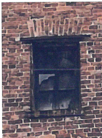
Заполнение оконных проемов. Фасады башни
