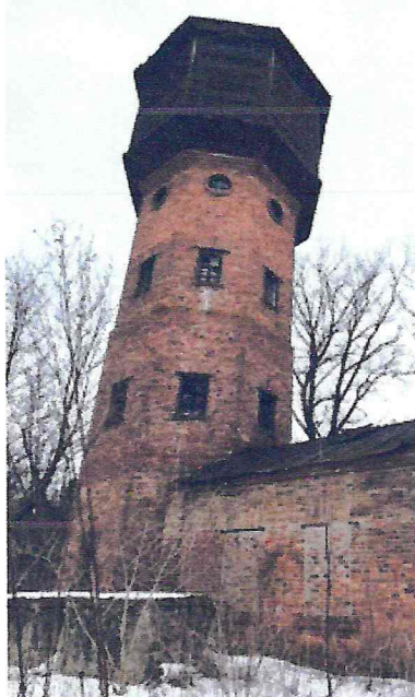
Вид с юго-запада
