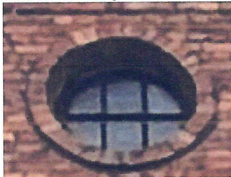
Заполнение оконных проемов. Фасады башни
