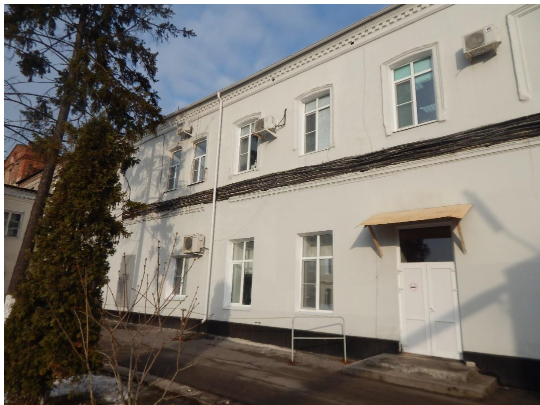
Фотография № 6. Вид с юго-запада на Объект.
