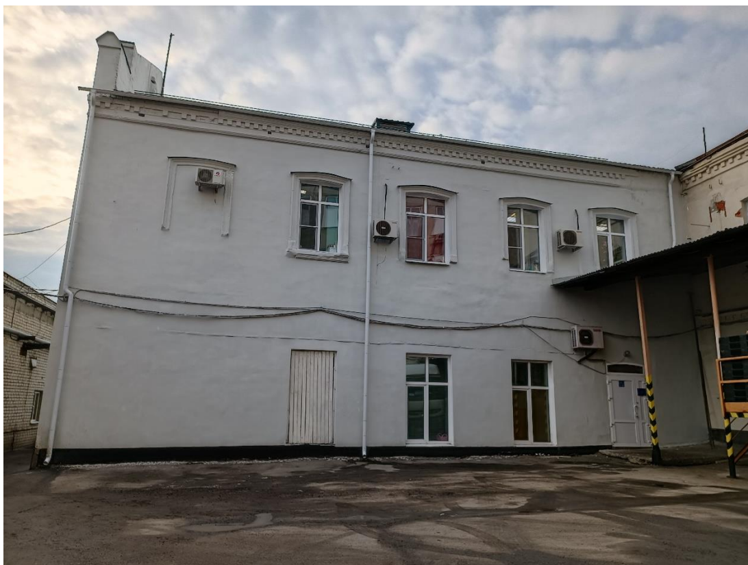
Фотография № 3. Вид с востока на Объект.
