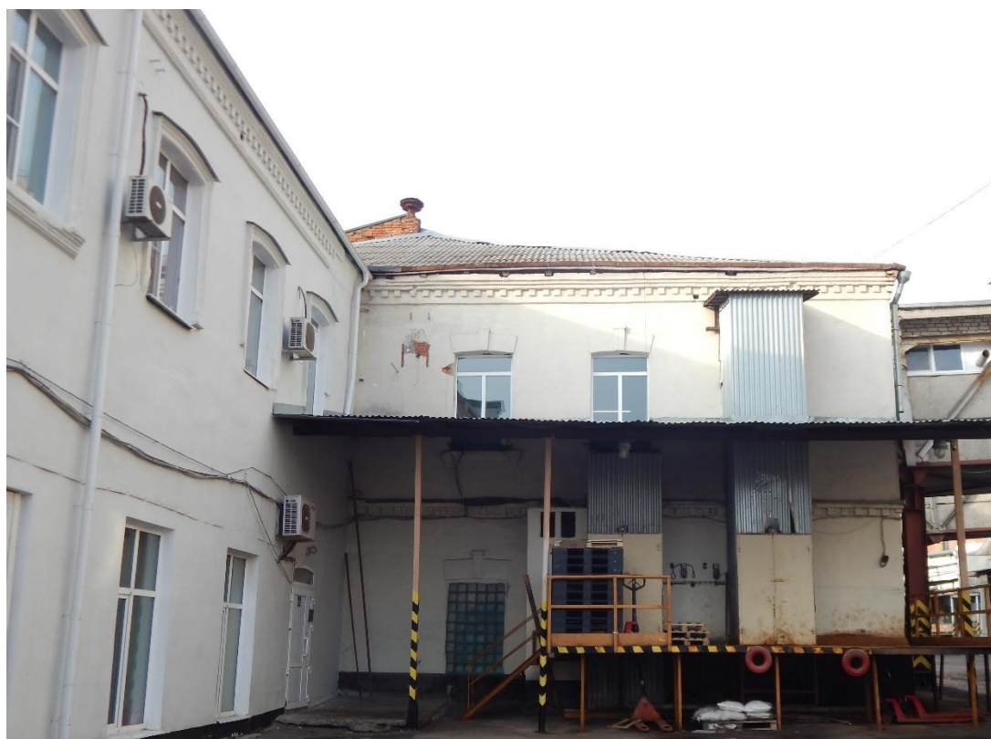
Фотография № 2. Вид с юга на Объект.
