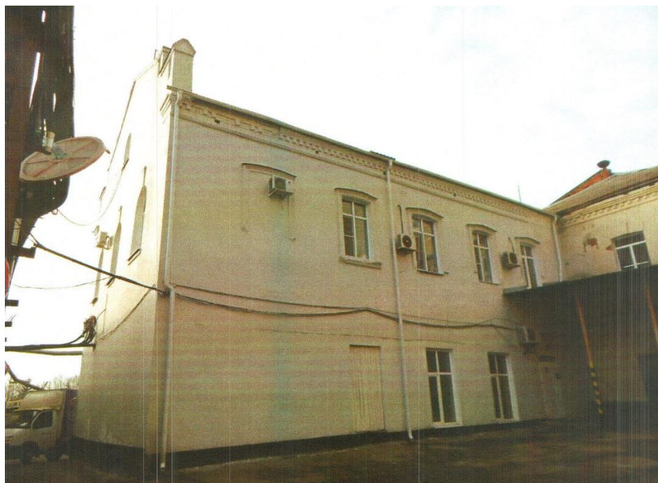
Выявленный объект культурного наследия «Промышленная постройка, XIX в.», расположенный по адресу: Курская область, г. Курск, ул. Радищева, 44. Фотофиксация из акта проведения осмотра выявленного объекта культурного наследия от 09.03.2023 № 58
