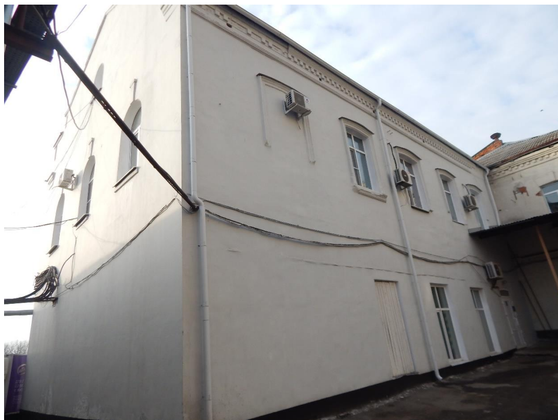
Фотография № 4. Вид с юго-востока на Объект.
