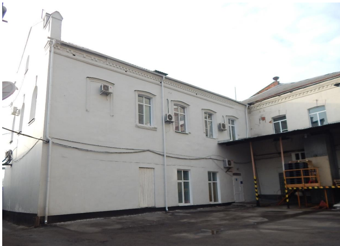
Фотография № 1. Вид с юго-востока на Объект.
