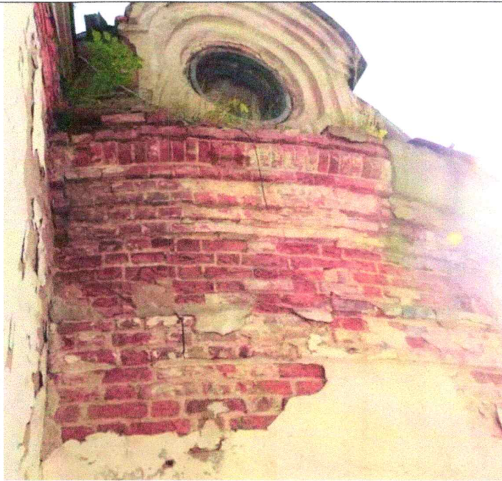
Материал штукатурного покрытия фасада – известковая штукатурка с окраской
