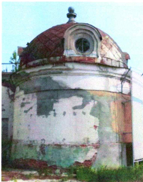
Сооружение - круглое в плане, завершенное полусферическим куполом с люкарнами по сторонам света,
