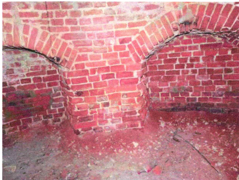
Стены здания кирпичные, выполнены из полнотелого керамического разноформатного кирпича, уложенного на известковый раствор;
