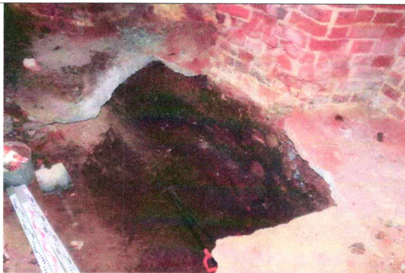
Материал фундаментов - полнотелый керамический разноформатный кирпич, уложенный на известковый раствор
