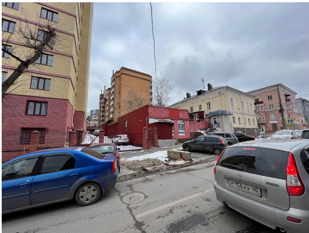
Фотография № 8. Вид с юго-запада на территорию расположения Объекта.
