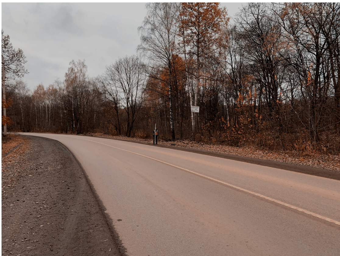
Рис. 18. Южная часть землеотвода, вид с Севера.
