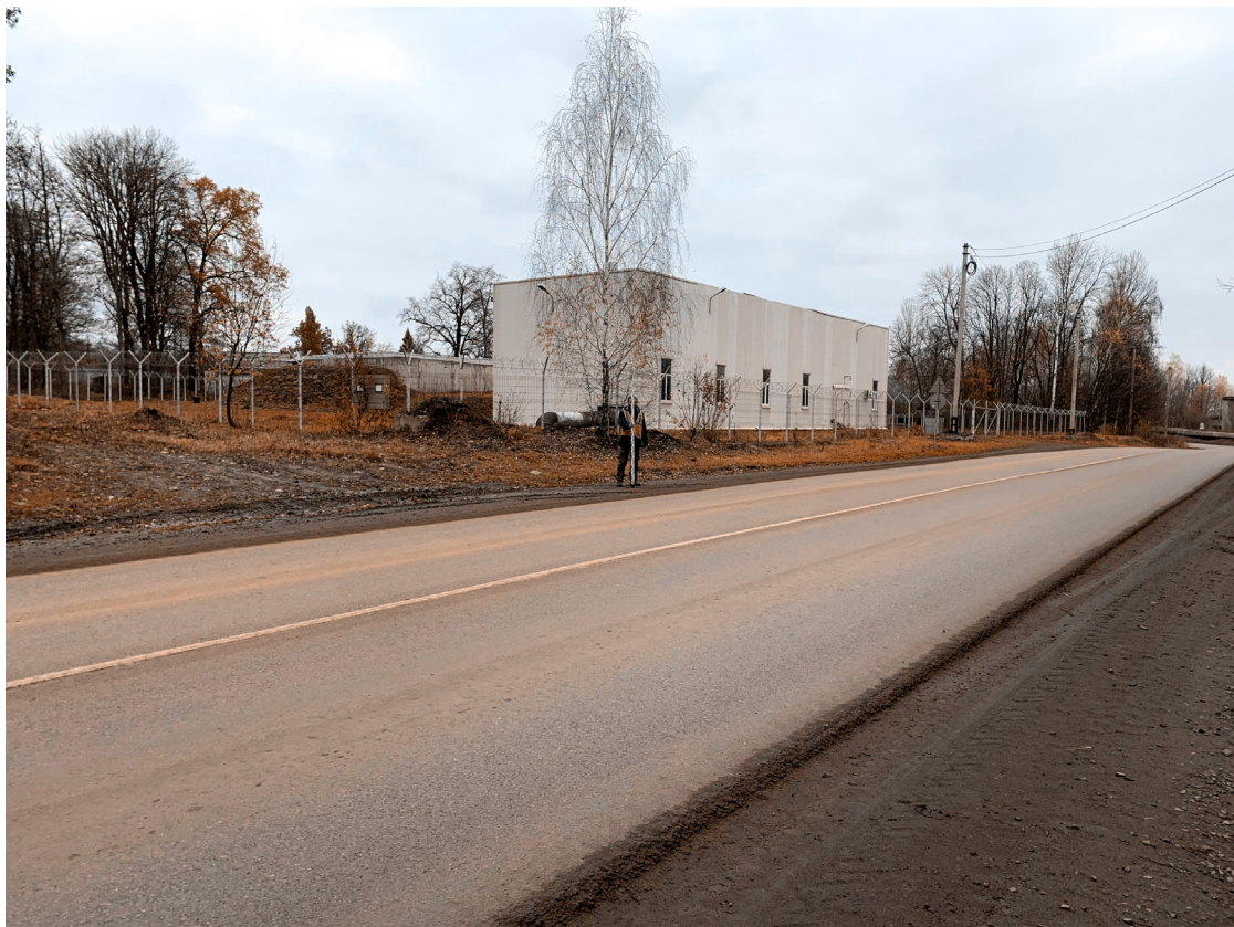
Рис. 19. Центральная часть землеотвода, вид с Востока.
