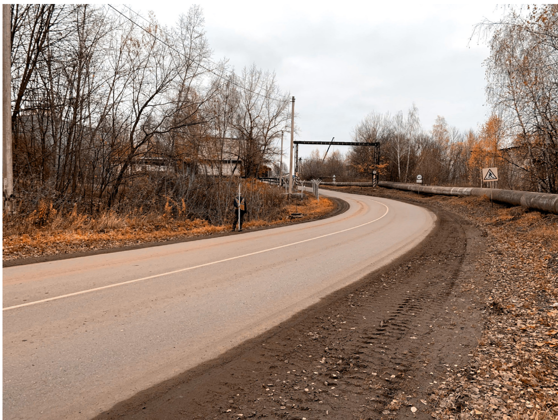
Рис. 23. Северная часть землеотвода, вид с ЮЮВ.
