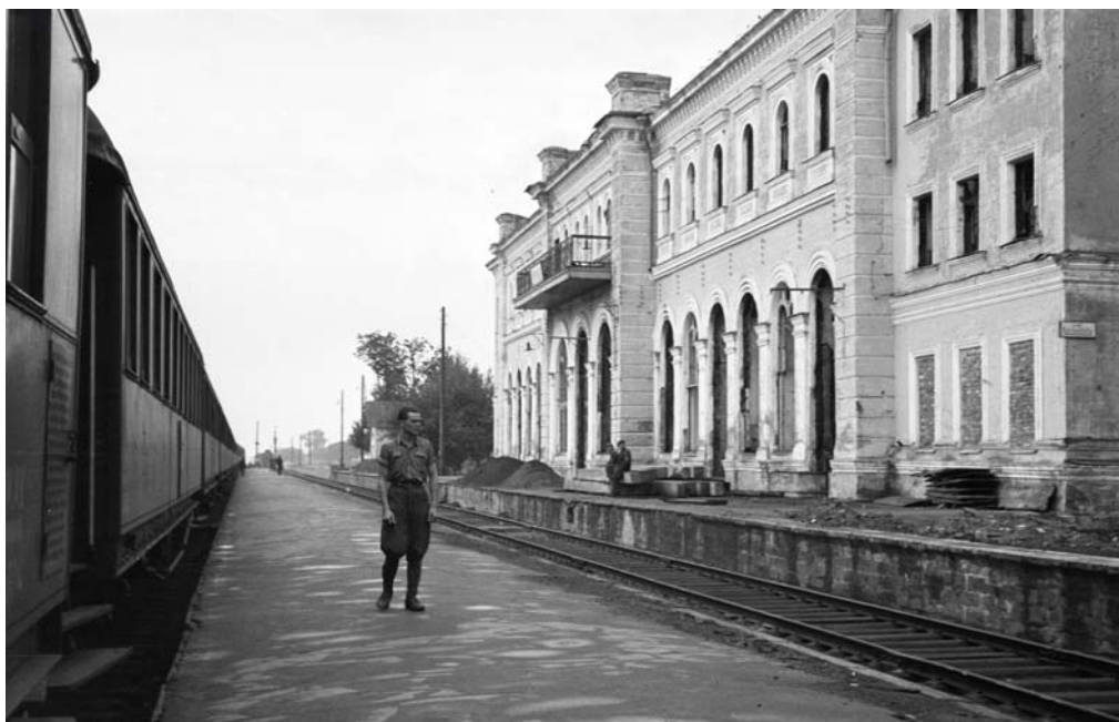
Станция Поньры. Фото 1942 г.
