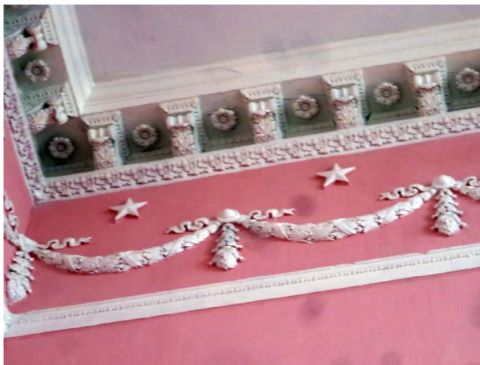
43. Декор стен и потолка вестибюля
