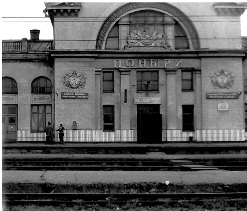
Станция Поньры. Фото 1982 г.
