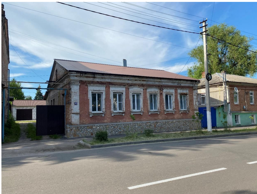
Фотография № 7. Вид с юго-запада на Объект.
