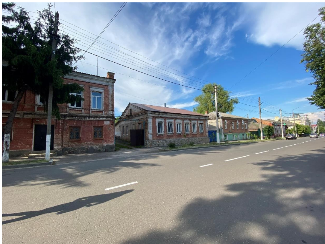
Фотография № 9. Вид с юго-запада на Объект.
