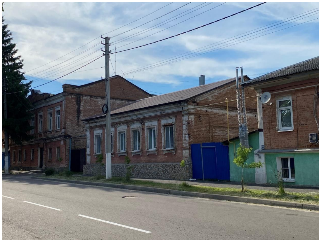
Фотография № 3. Вид с юго-востока на Объект.
