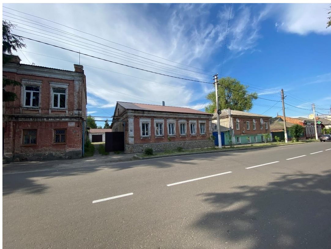
Фотография № 8. Вид с юго-запада на Объект.
