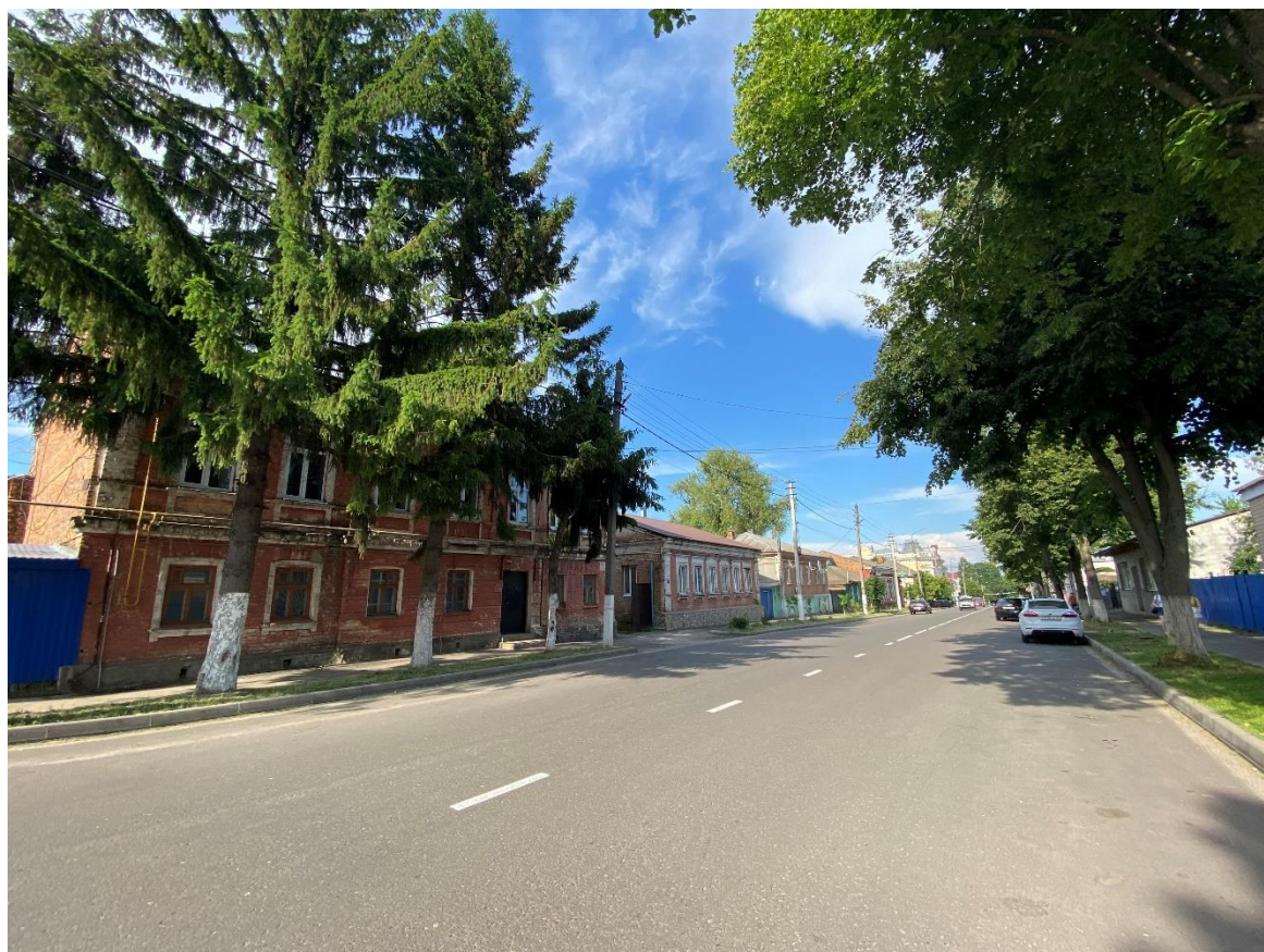
Фотография № 10. Вид с юго-запада на Объект.
