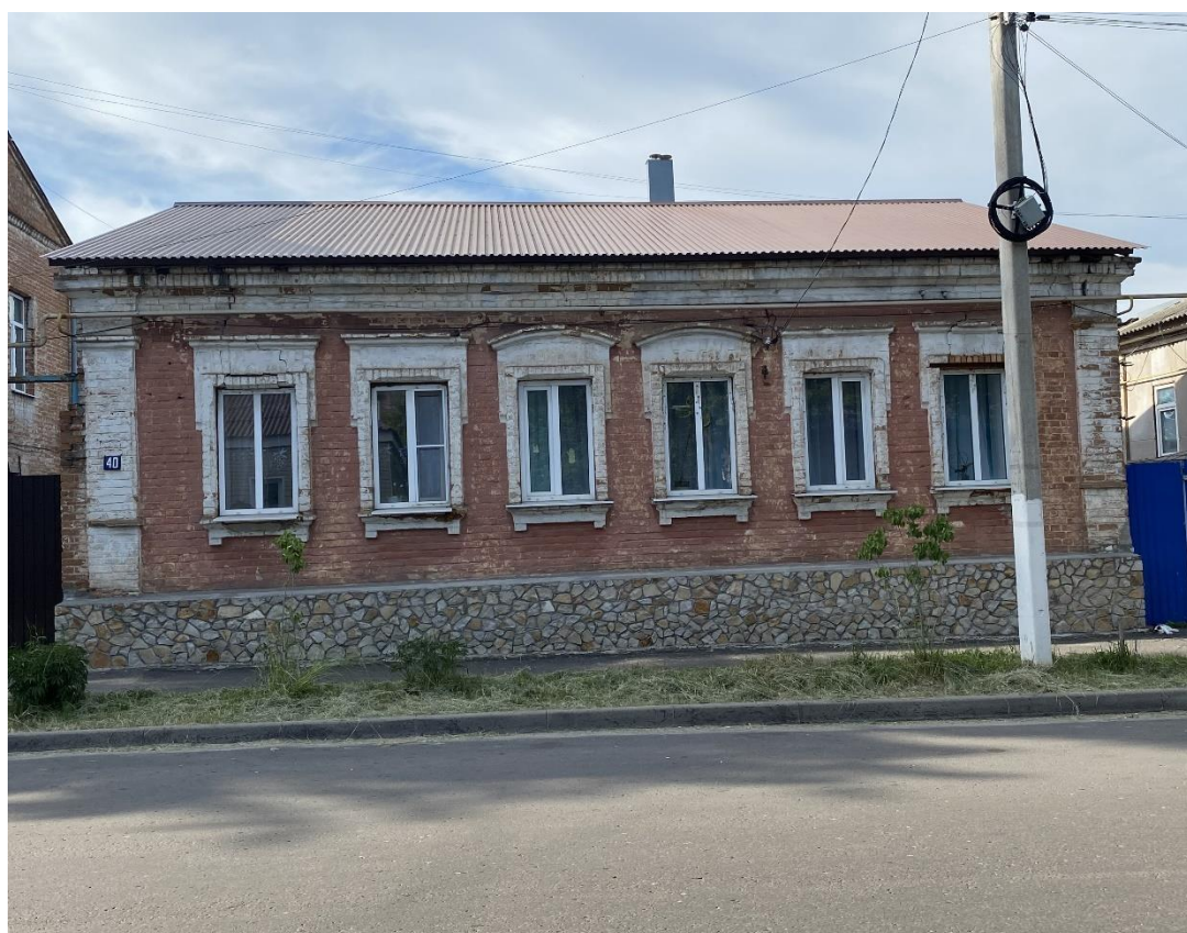
Фотография № 6. Вид с юга на Объект. Южный (центральный) фасад.
