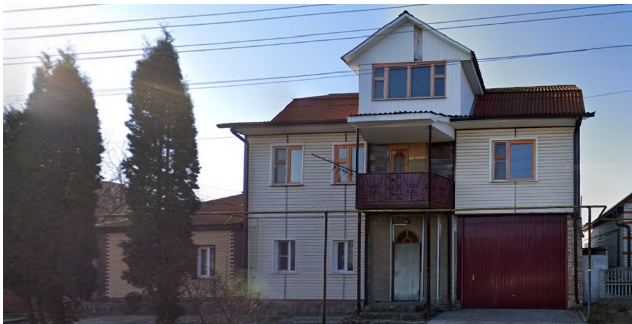
Фотография № 7. Вид с севера на Объект.
