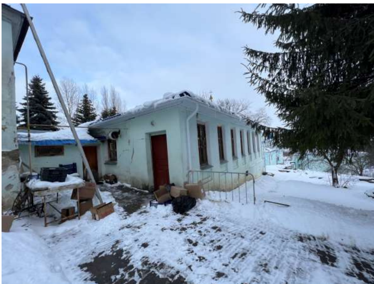
Т.ф. 6. Общий вид на здание с юго-западной стороны
