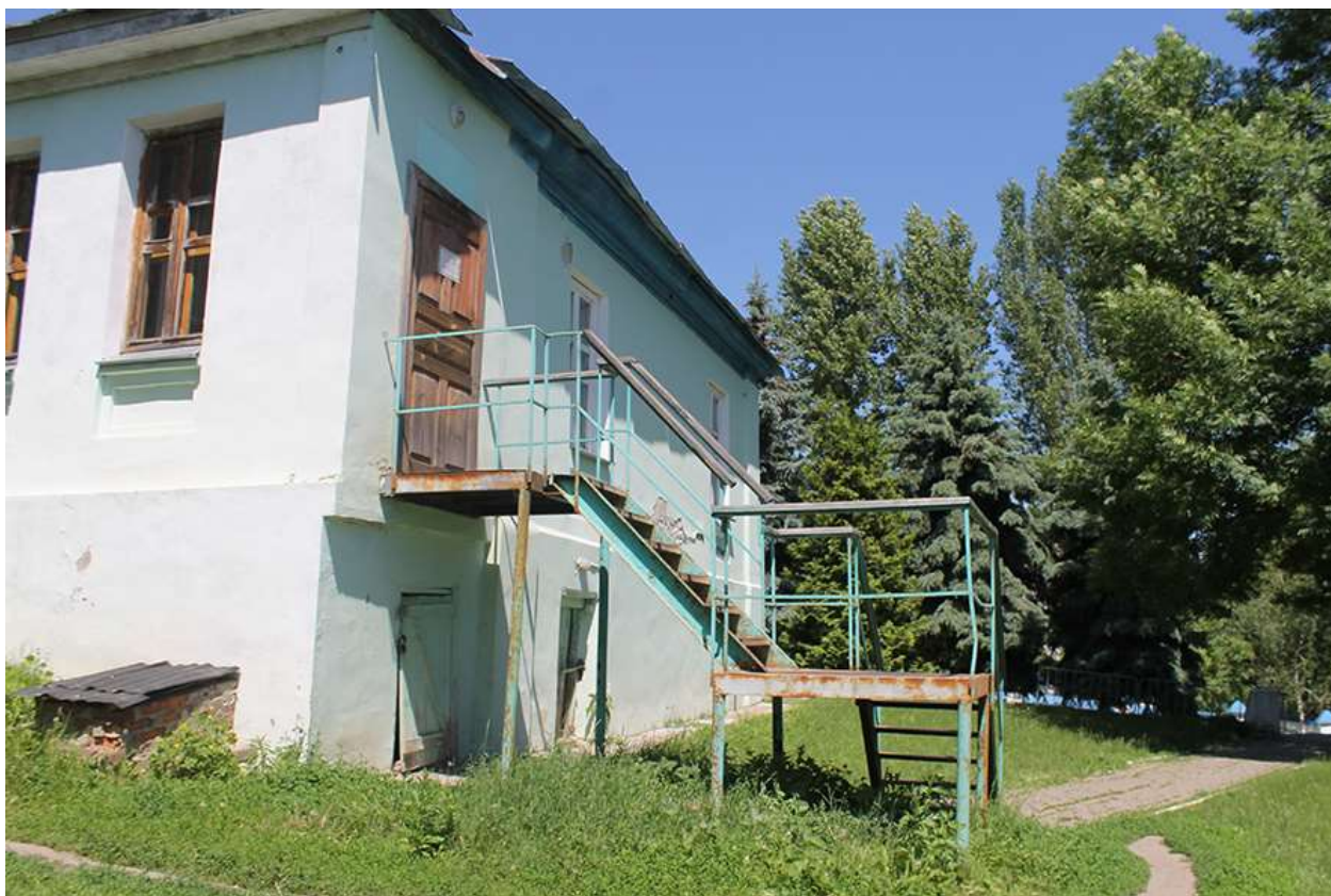
Общий вид восточного фасада Объекта
