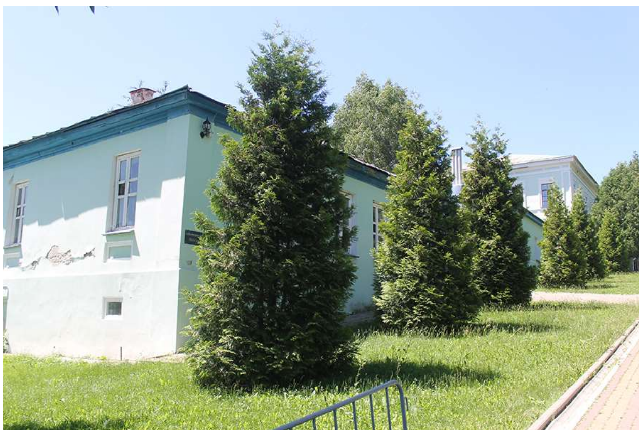
Общий вид северного фасада Объекта
