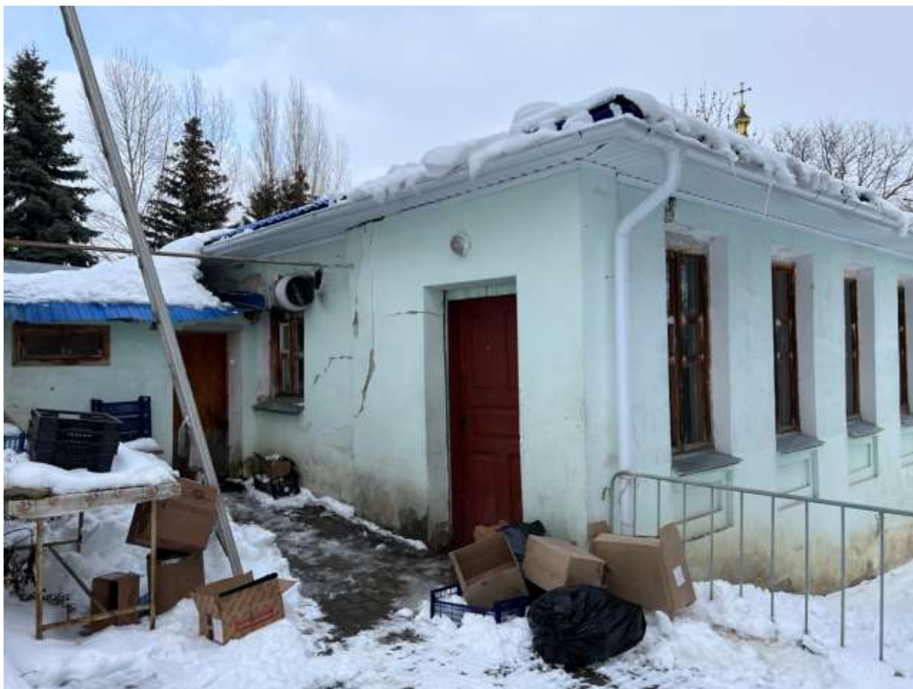
Т.ф. 7. Общий вид входной группы в здание со стороны южного фасада
