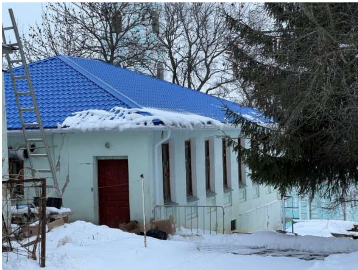
Т.ф. 5. Общий вид южного фасада Объекта
