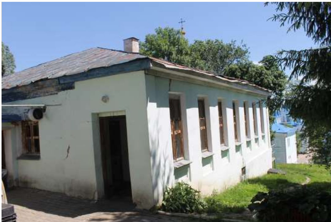
Т.ф. 1. Общий вид западного и южного фасадов Объекта
