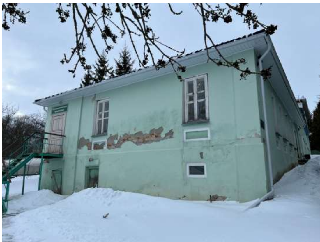
Т.ф. 2. Общий вид восточного фасада Объекта
