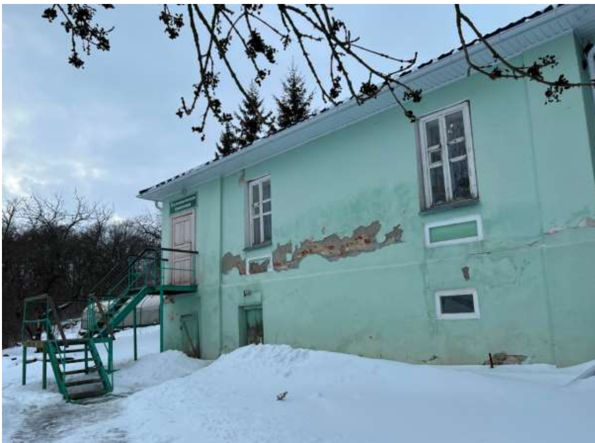
Т.ф. 3. Входная группа в здание со стороны восточного фасада Объекта
