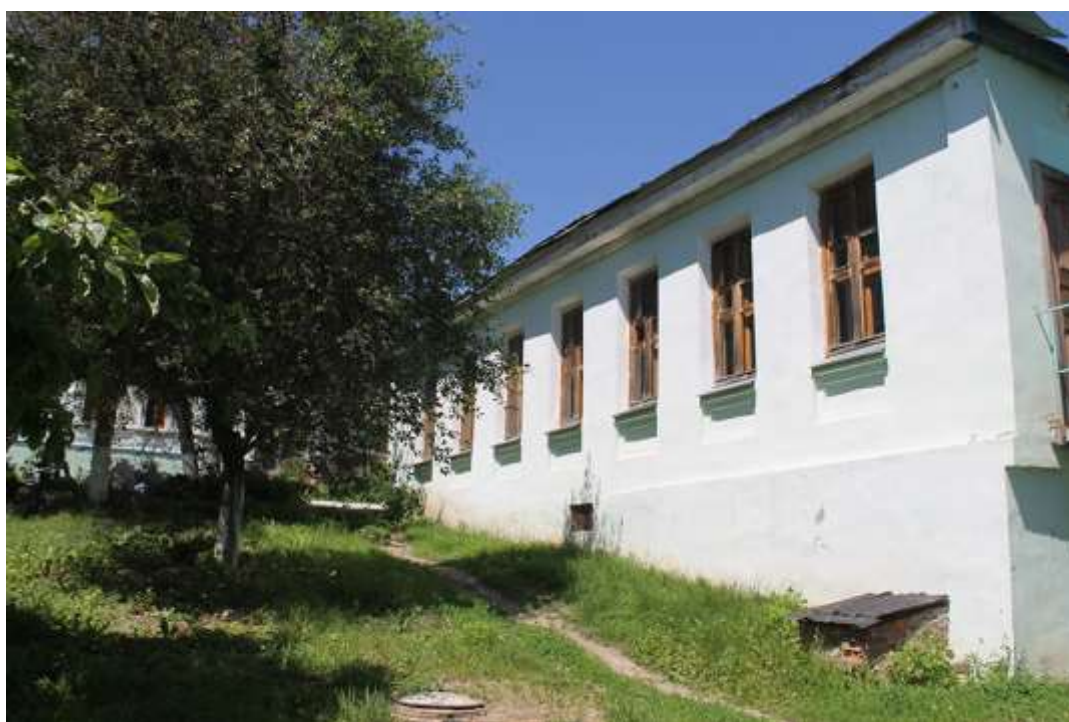
Общий вид южного фасада Объекта
