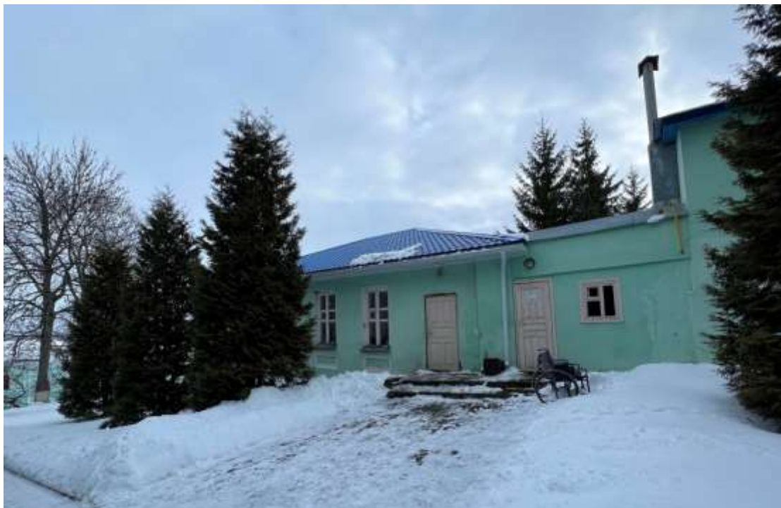
Т.ф. 1. Общий вид Объекта с северной стороны
