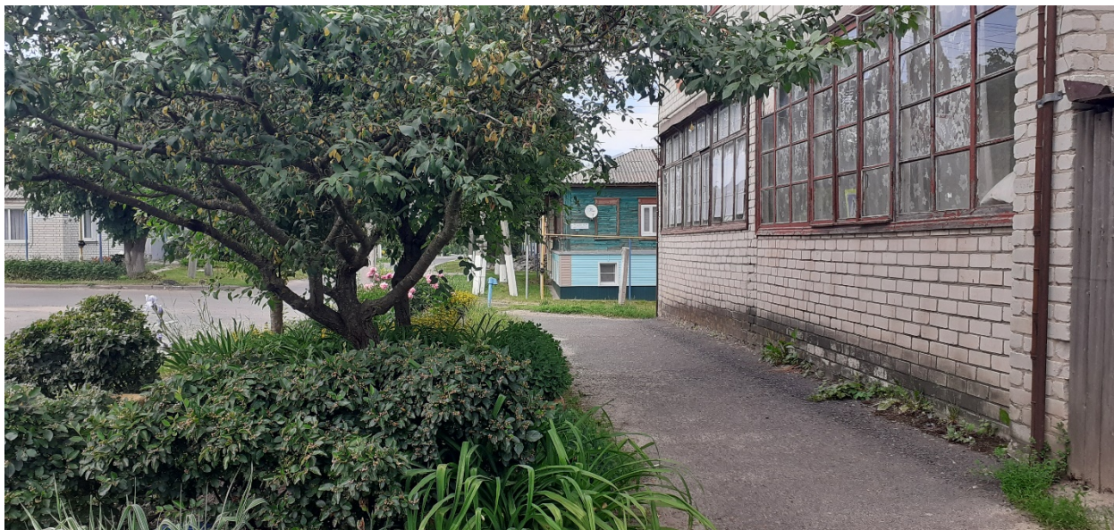
Фотография № 5. Вид с юга на Объект.
