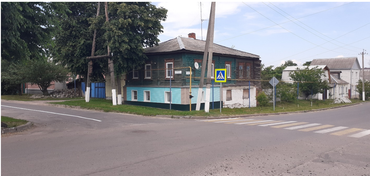
Фотография № 3. Вид с юго-запада на Объект.
