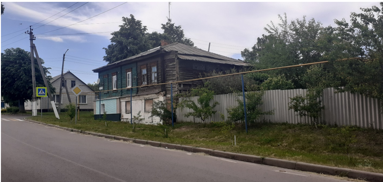
Фотография № 7. Вид с юго-востока на Объект.
