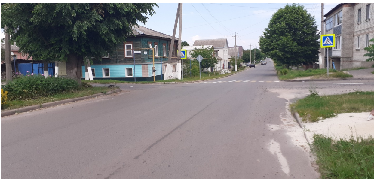
Фотография № 2. Вид с юго-запада на Объект.
