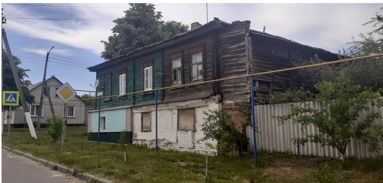
Фотография № 6. Вид с юго-востока на Объект.
