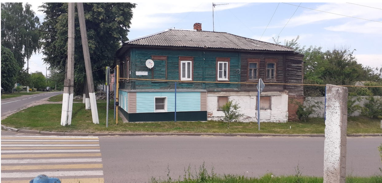
Фотография № 4. Вид с юга на Объект.
