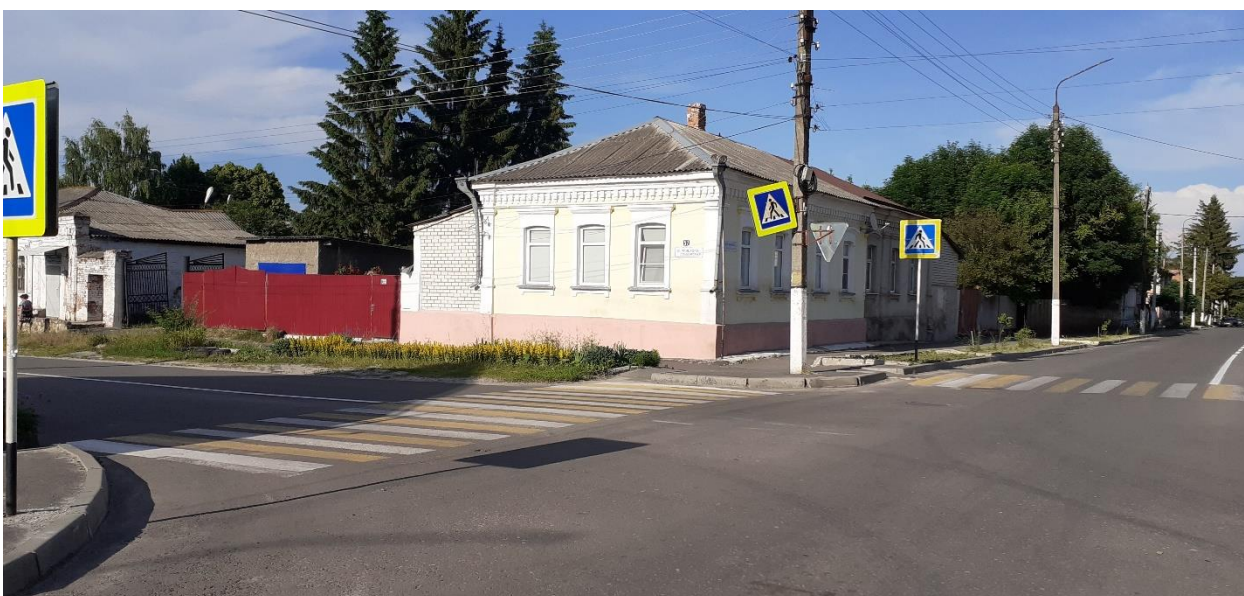
Фотография № 8. Вид с юго-запада на Объект.
