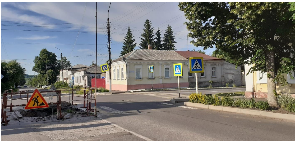
Фотография № 6. Вид с юго-запада на Объект.
