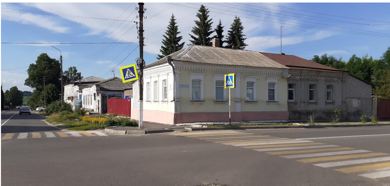
Фотография № 5. Вид с юго-запада на Объект.
