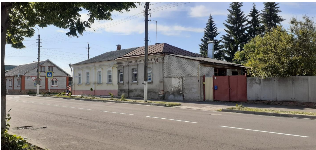
Фотография № 3. Вид с юго-востока на Объект.
