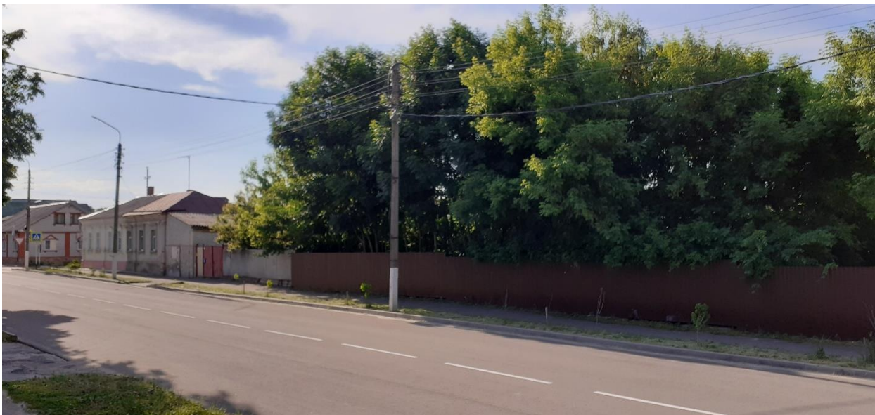
Фотография № 1. Вид с юго-востока на Объект.
