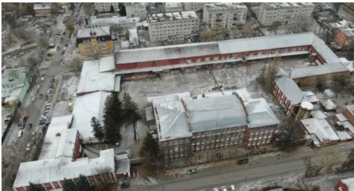
Выявленный объект культурного наследия «Ансамбль спиртзавода Сперанского» ( https://kpravda.ru/wp-content/uploads/2023/02/lvz2.jpg )
