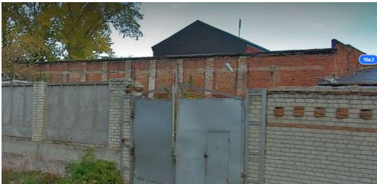
34. Вид на производственный корпус №2 Ликеро-водочного завода (ул. Халтурина, 16). Фотография, 2010 г. Источник: https://yandex.ru/maps/
