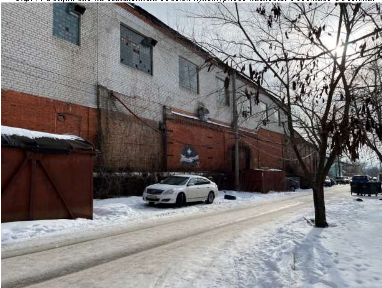
Т.ф. 8. Общий вид на выявленный объект культурного наследия в составе Объекта.
