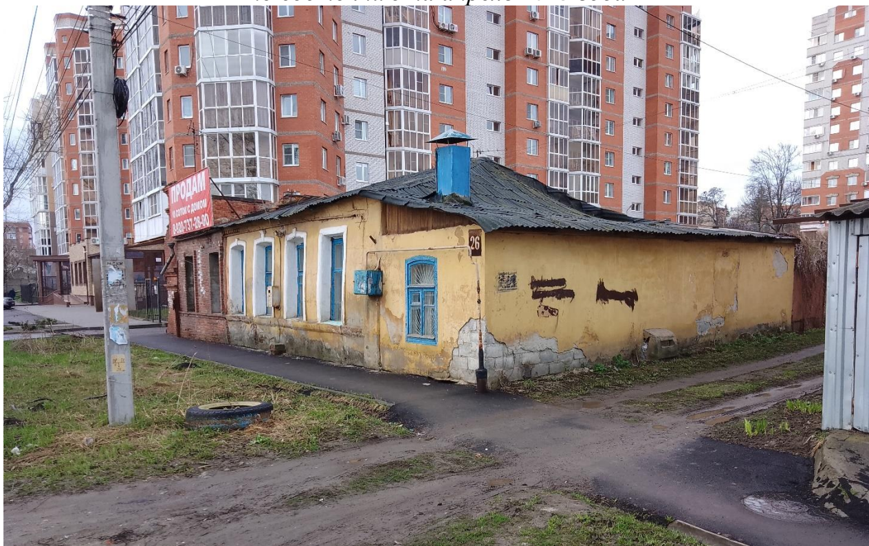
Фото 1. Общий вид Объекта
