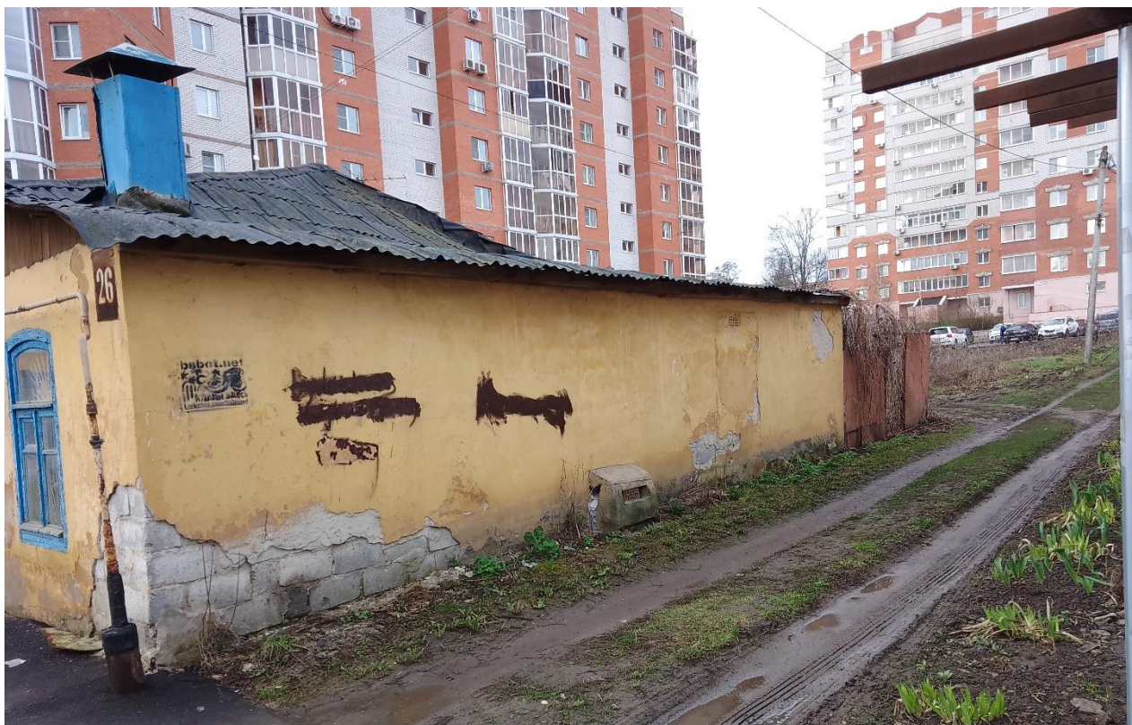
Фото 5. Северный фасад Объекта
