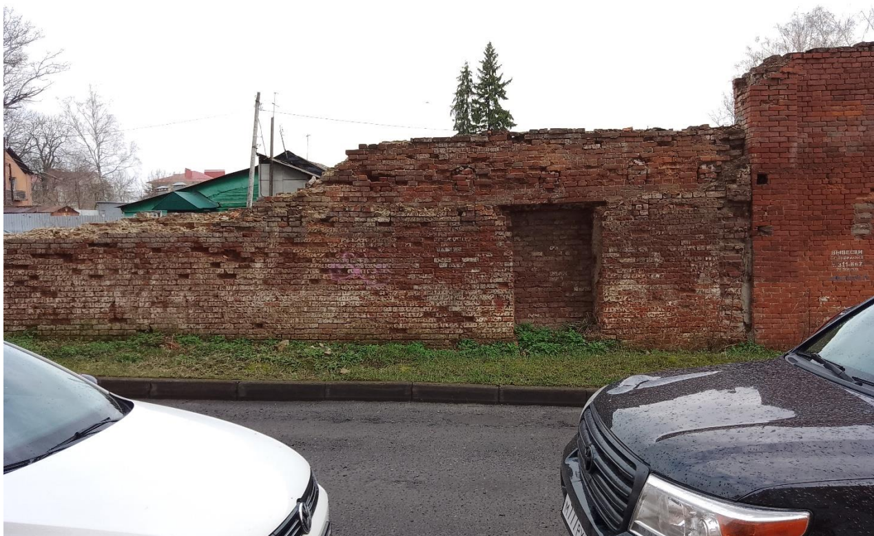
Фото 9. Фрагмент южной стены
