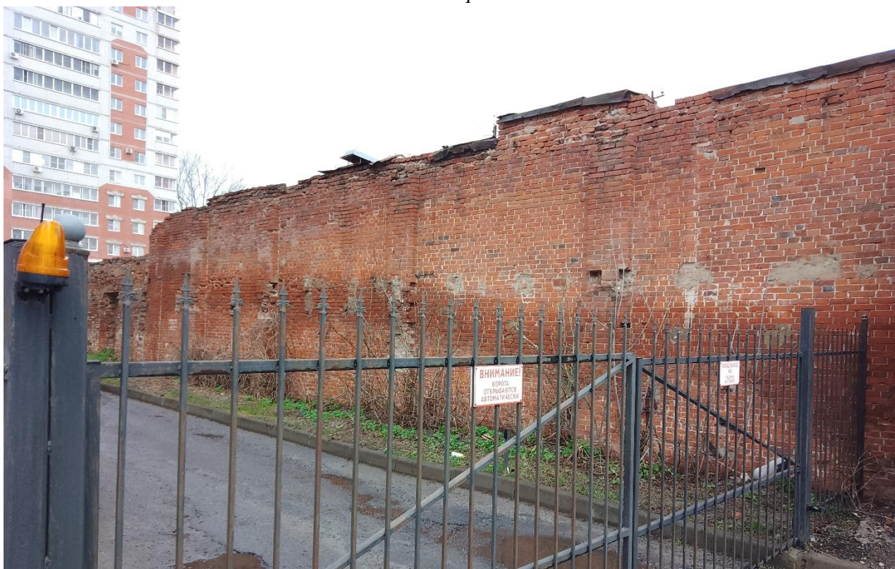
Фото 8. Южная брандмауэрная стена Объекта.
