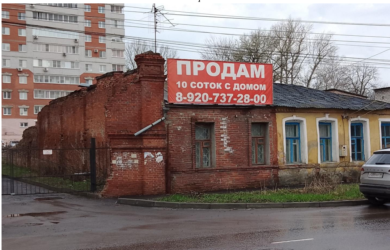
Фото 4. Общий вид Объекта
