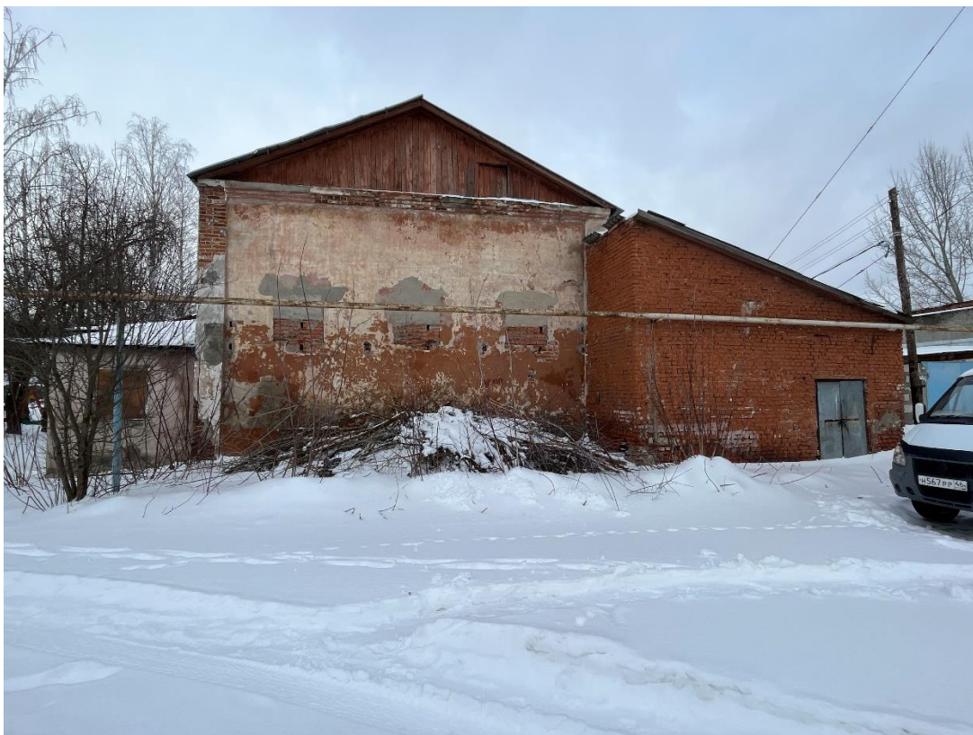
Фотография № 8. Вид с юго-востока на Объект.
