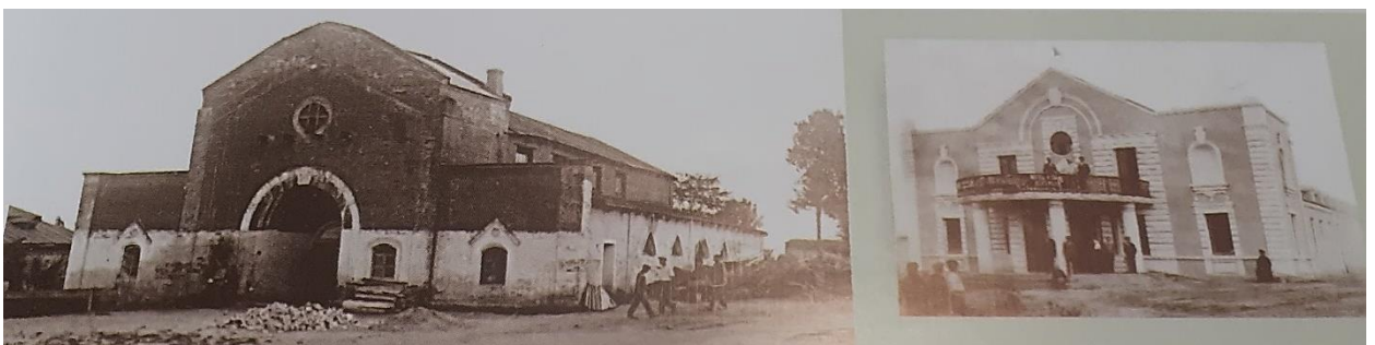
22. Фотографические изображения здания Объекта.
