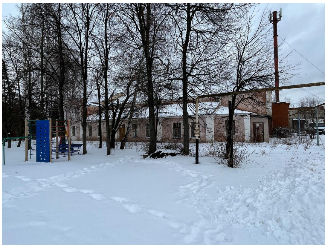
Фотография № 6. Вид с юго-запада на Объект.
