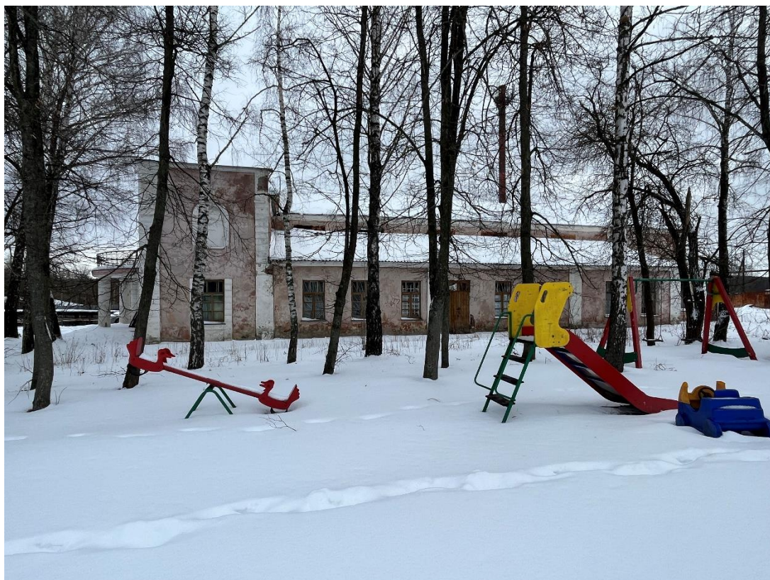
Фотография № 4. Вид с юго-запада на Объект.
