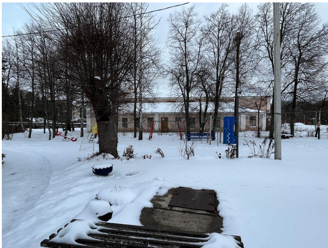
Фотография № 5. Вид с юго-запада на Объект.
