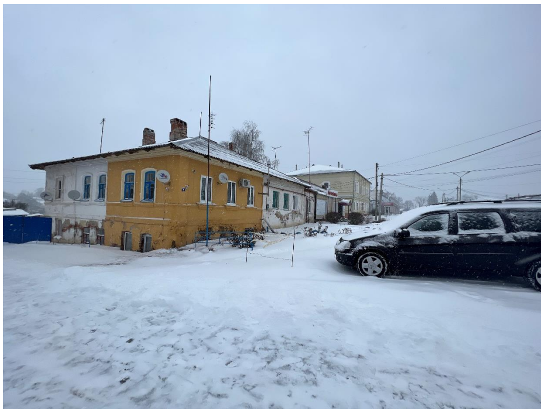
Фотография № 1. Вид с юго-запада на Здание-І.
