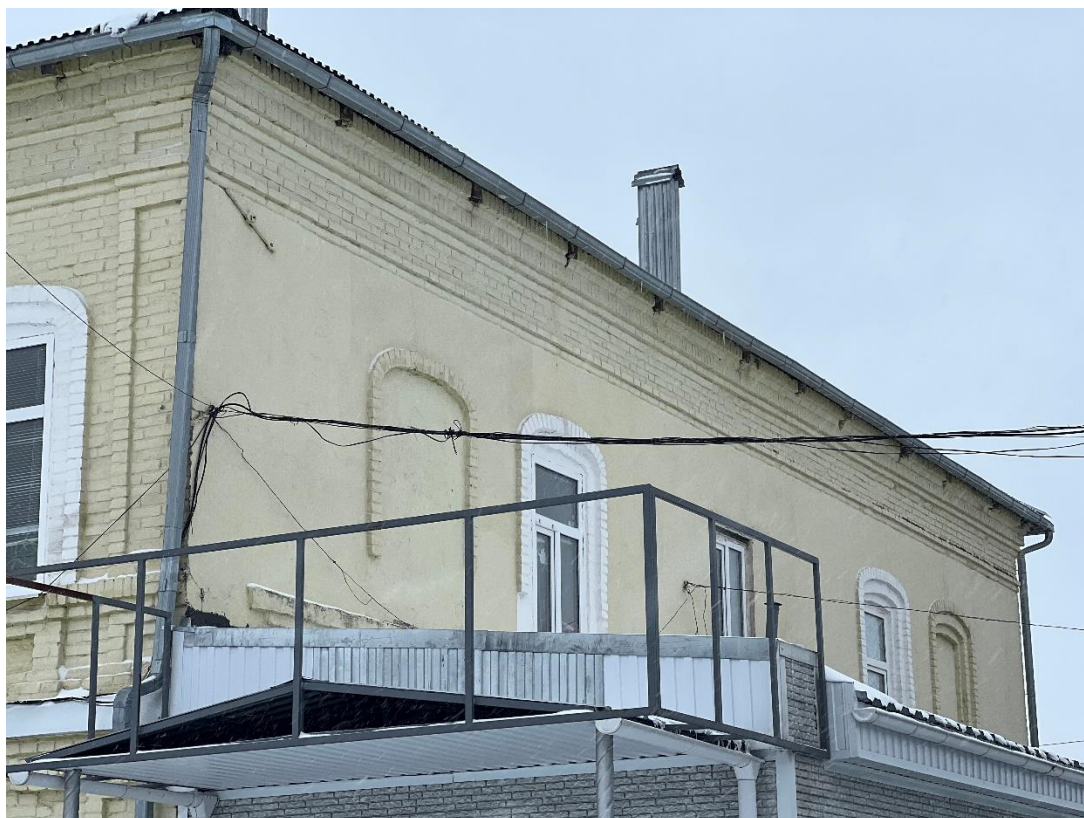
Фотография № 13. Вид с юго-востока на Здание-1.
