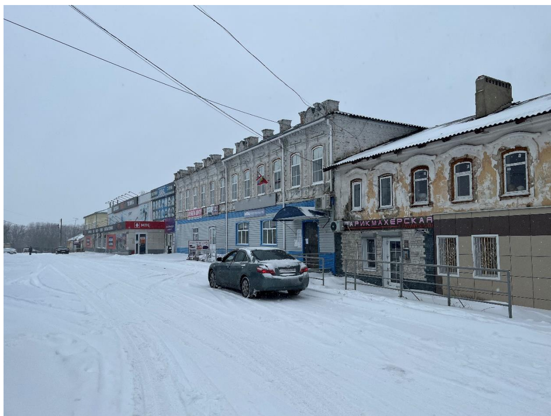
Фотография № 38. Вид с востока на Объекты.
