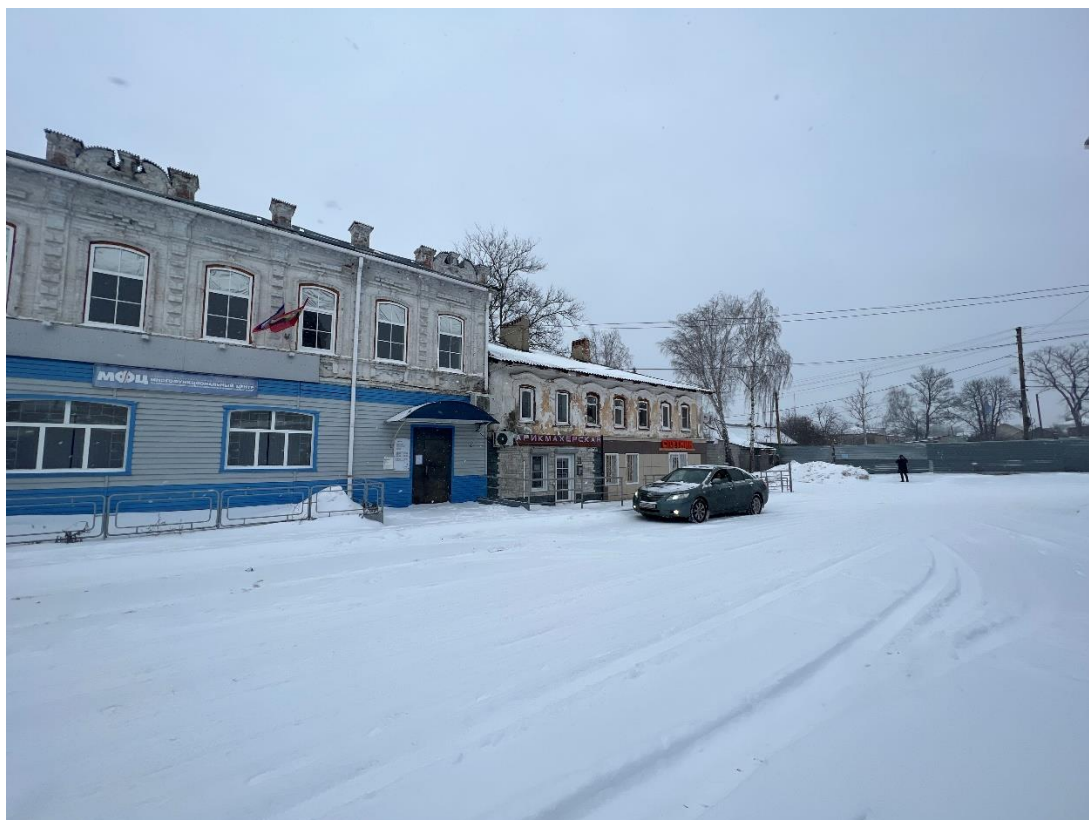
Фотография № 33. Вид с юго-запада на Здание-3, Здание-4.
