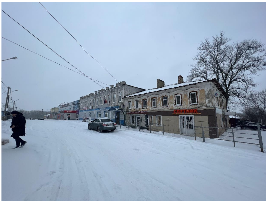
Фотография № 43. Вид с востока на Объекты.
