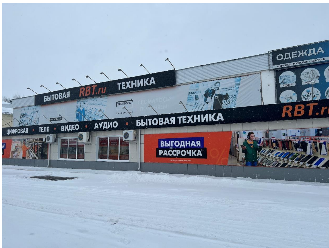
Фотография № 25. Вид с юго-востока на Здание-2.
