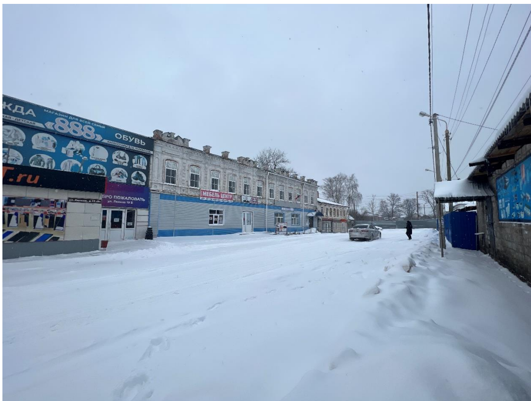
Фотография № 27. Вид с юго-запада на Здание-2, Здание-3, Здание-4.
