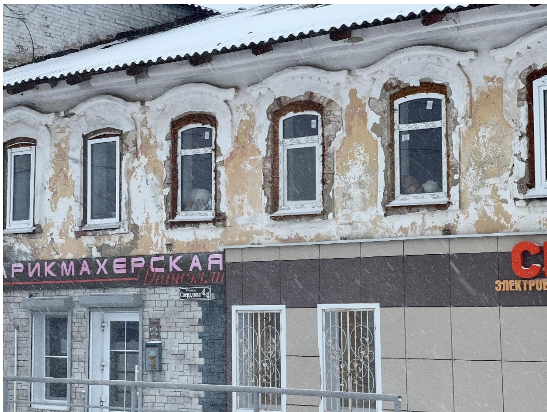
Фотография № 41. Вид с юго-востока на Здание-4.
