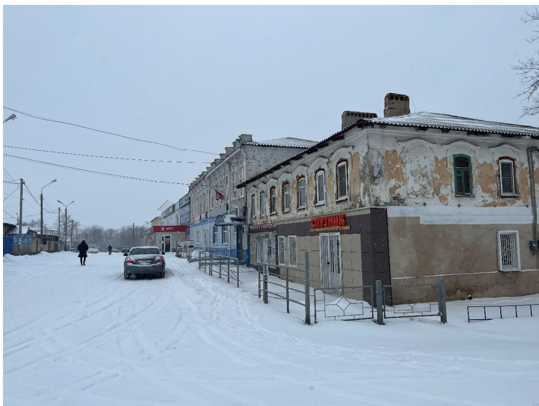
Фотография № 44. Вид с северо-востока на Объекты.
