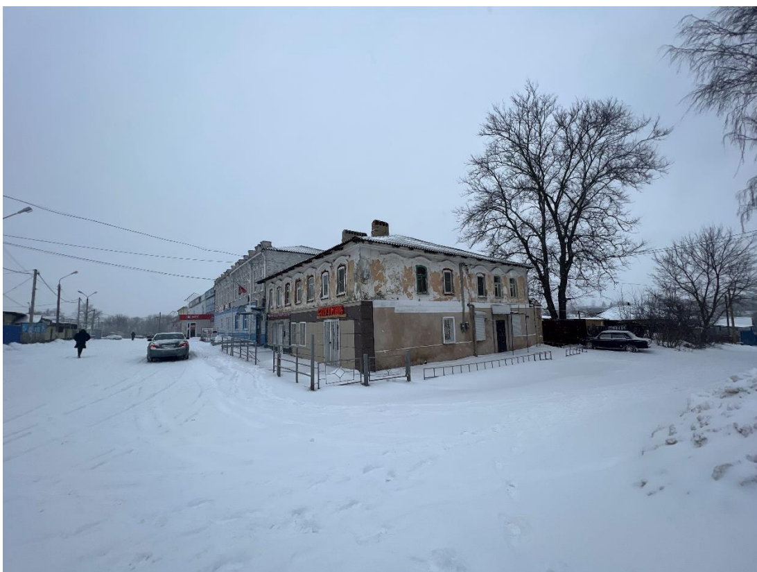
Фотография № 46. Вид с юго-востока на Здание-4.
