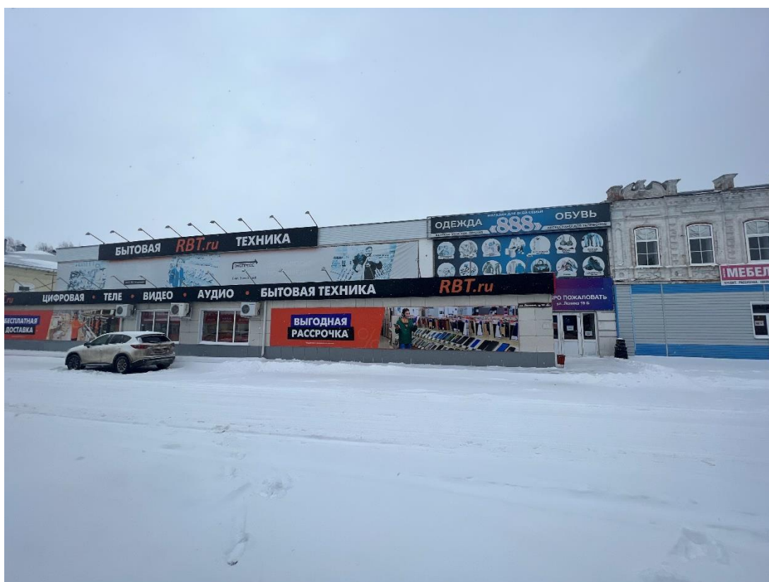
Фотография № 24. Вид с юго-востока на Здание-2, Здание-3.
