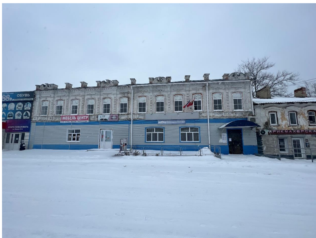
Фотография № 30. Вид с юго-востока на Здание-3, Здание-4.
