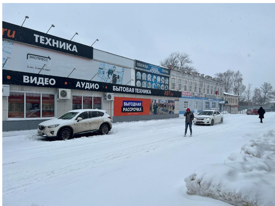
Фотография № 22. Вид с юго-запада на Здание-2, Здание-3.
