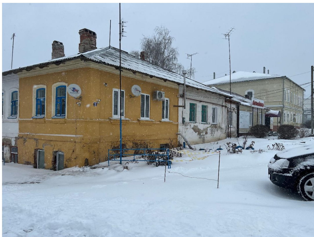
Фотография № 2. Вид с юго-запада на Здание-І.
