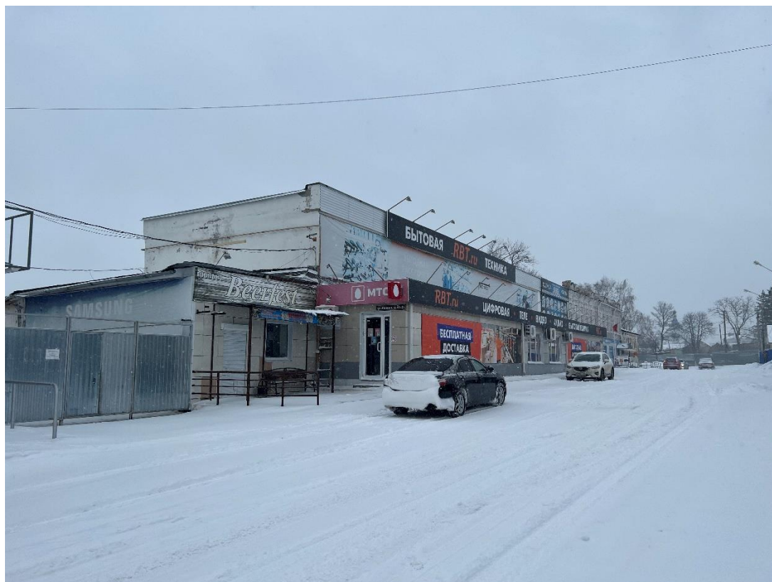
Фотография № 17. Вид с юго-запада на Здание-2, Здание-3.
