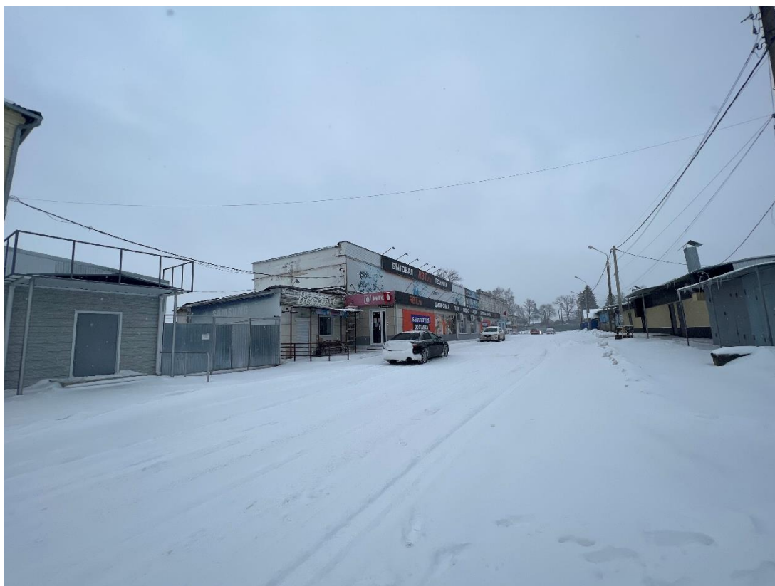
Фотография № 16. Вид с юго-запада на Здание-2, Здание-3.
