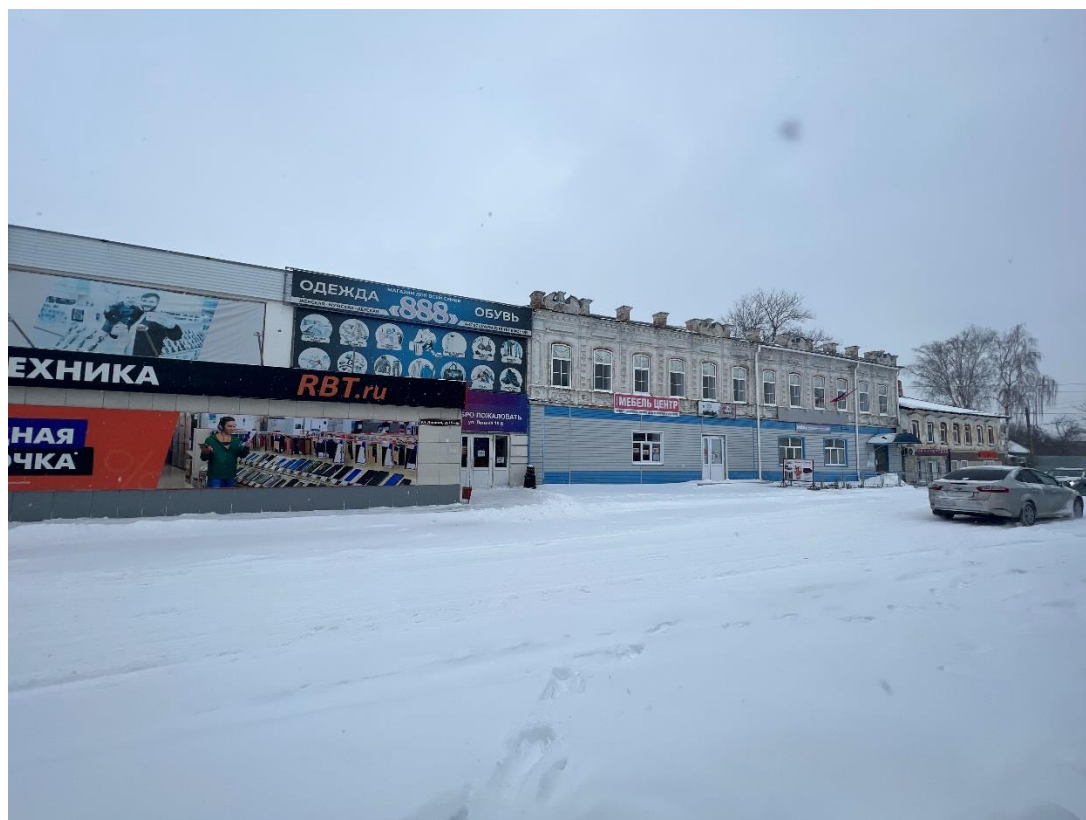
Фотография № 26. Вид с юго-запада на Здание-2, Здание-3, Здание-4.
