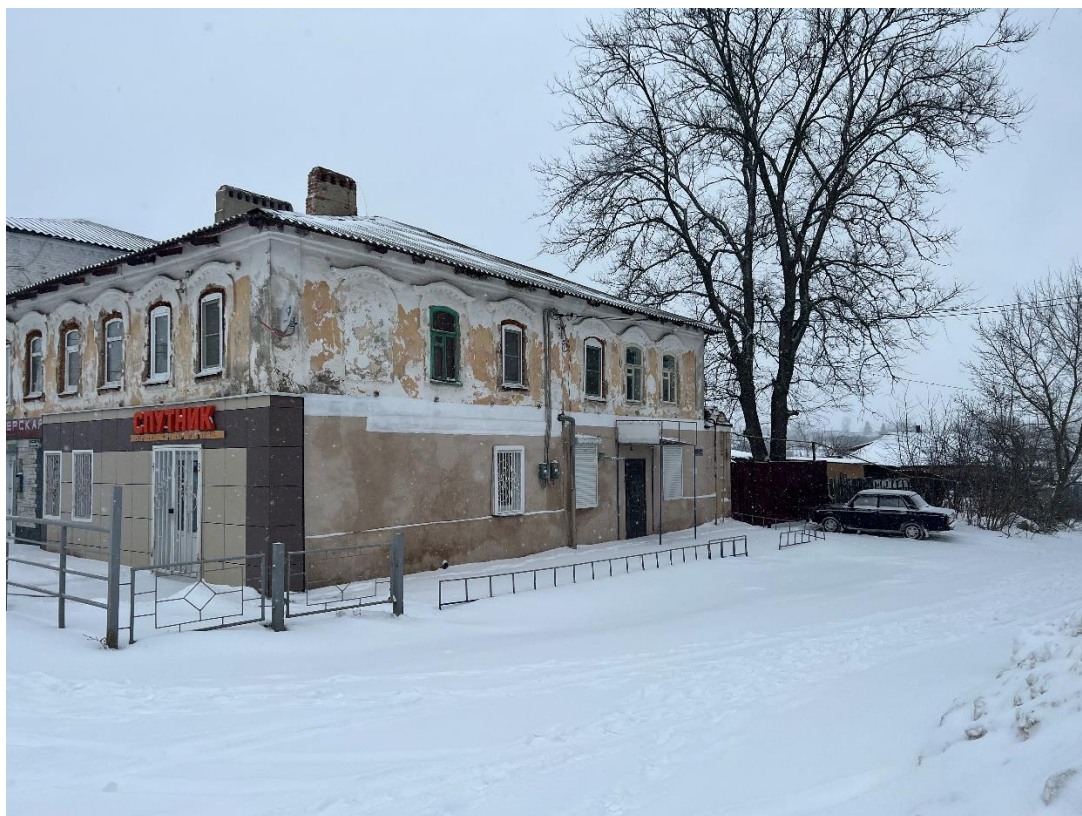
Фотография № 45. Вид с юго-востока на Здание-4.
