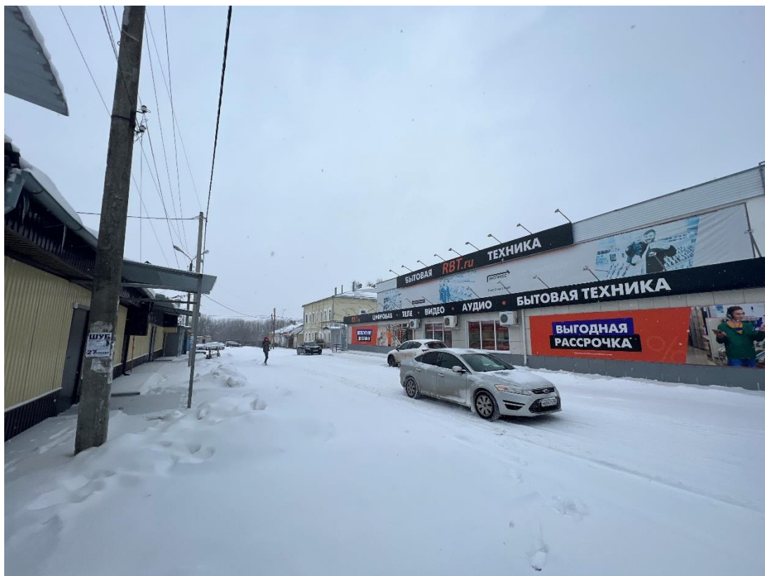
Фотография № 23. Вид с востока на Здание-1, Здание-2.
