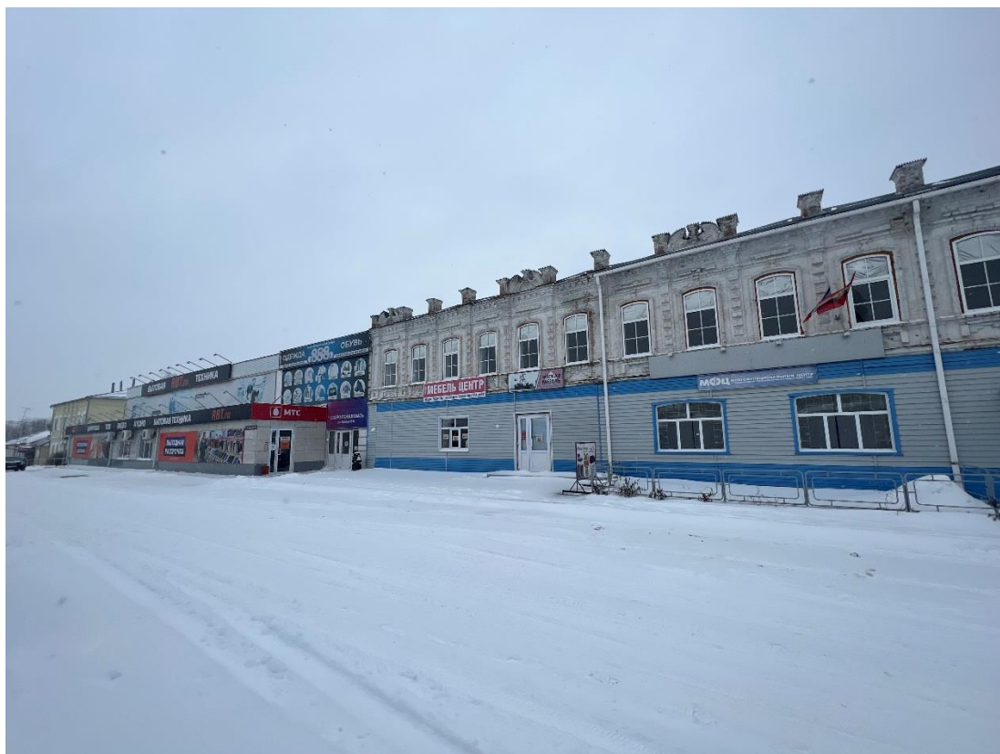
Фотография № 35. Вид с востока на Здание-1, Здание-2, Здание-3.
