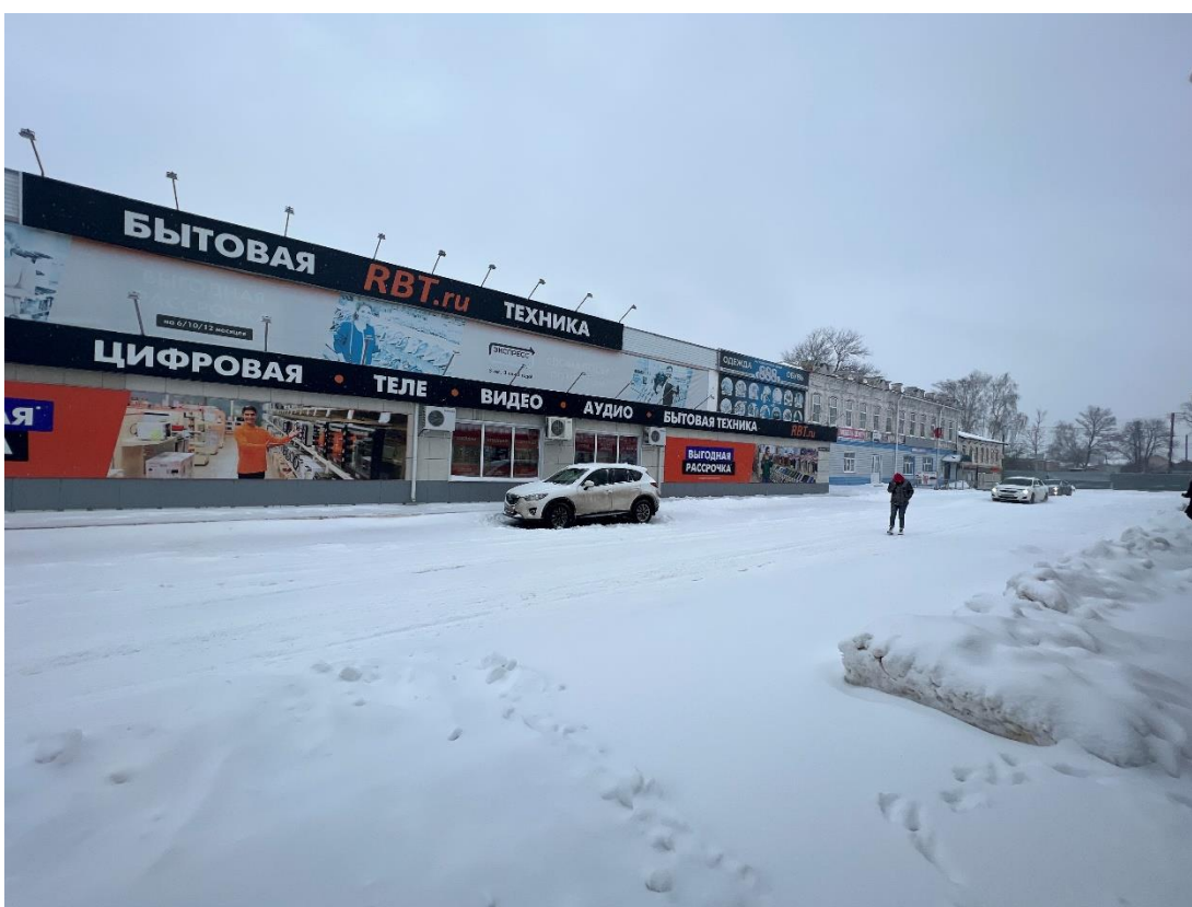
Фотография № 20. Вид с юго-запада на Здание-2, Здание-3.
