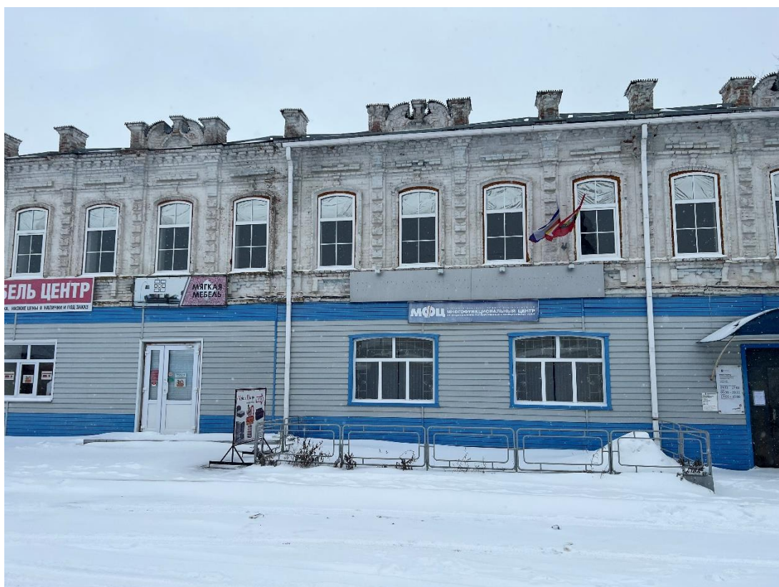
Фотография № 31. Вид с юго-востока на Здание-3.
