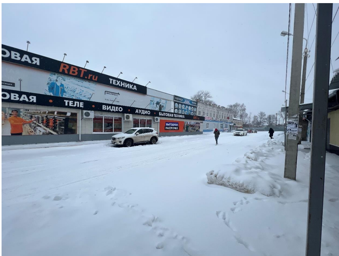
Фотография № 21. Вид с юго-запада на Здание-2, Здание-3.
