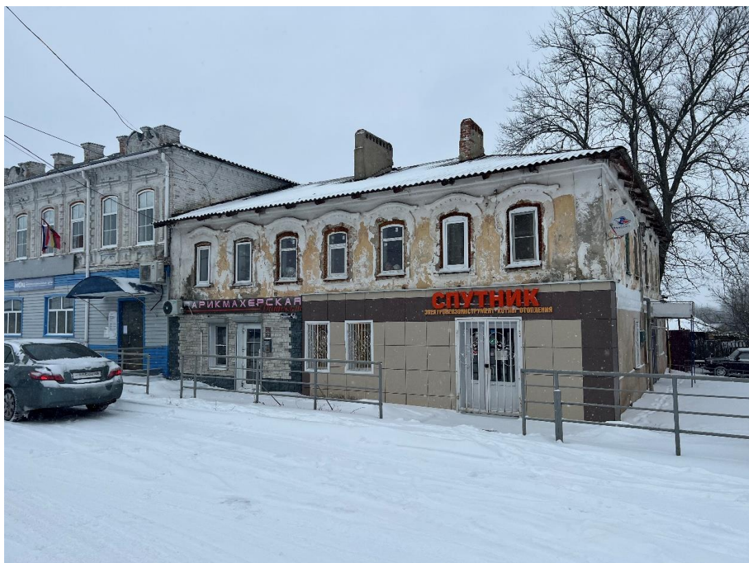
Фотография № 40. Вид с юго-востока на Здание-4.
