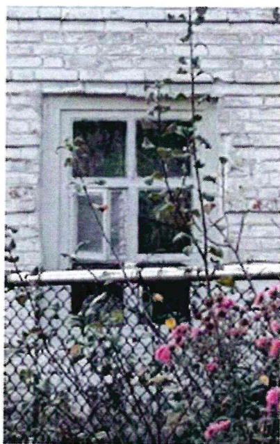
Оформление оконных проемов
