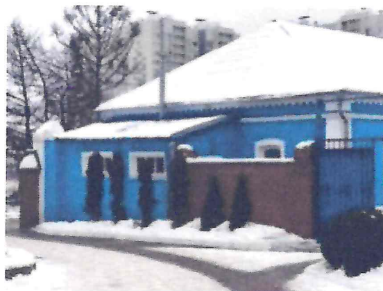
Вид на боковой северный фасад (без поздней пристройки)
