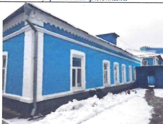
композиция западного дворового фасада
