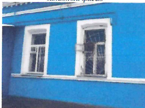
Расстекловка оконных проемов бокового фасада
