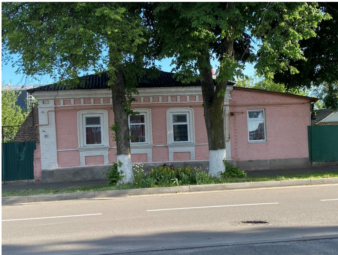
Фотография № 5. Вид с севера на Объект.
