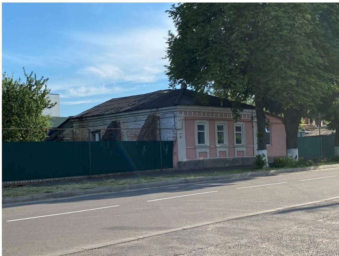
Фотография № 3. Вид с северо-востока на Объект.
