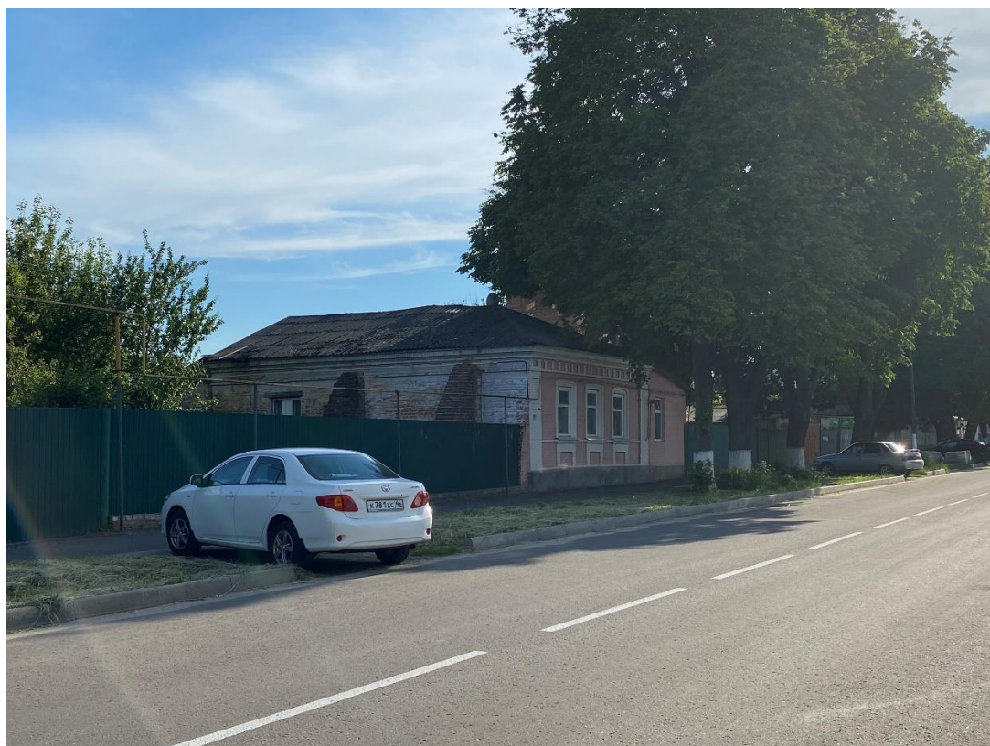
Фотография № 2. Вид с северо-востока на Объект.
