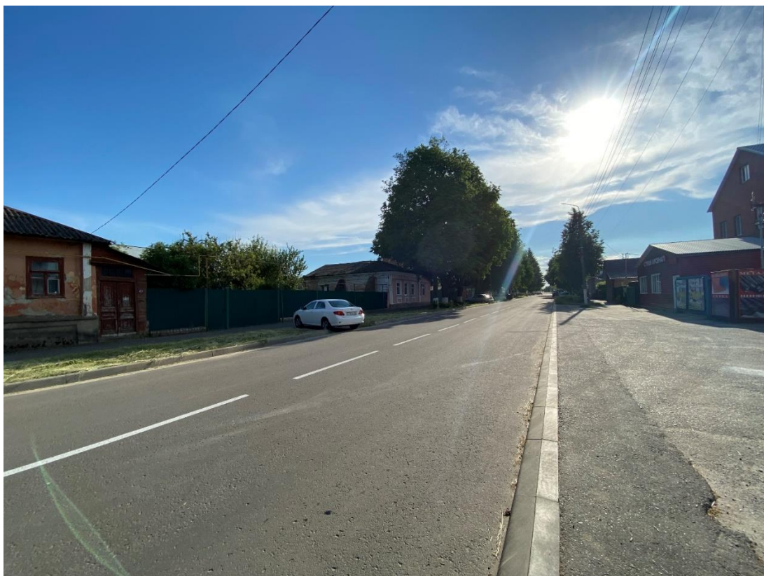
Фотография № 1. Вид с востока на Объект.
