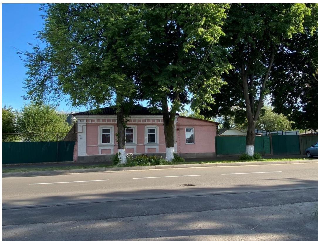
Фотография № 4. Вид с севера на Объект.
