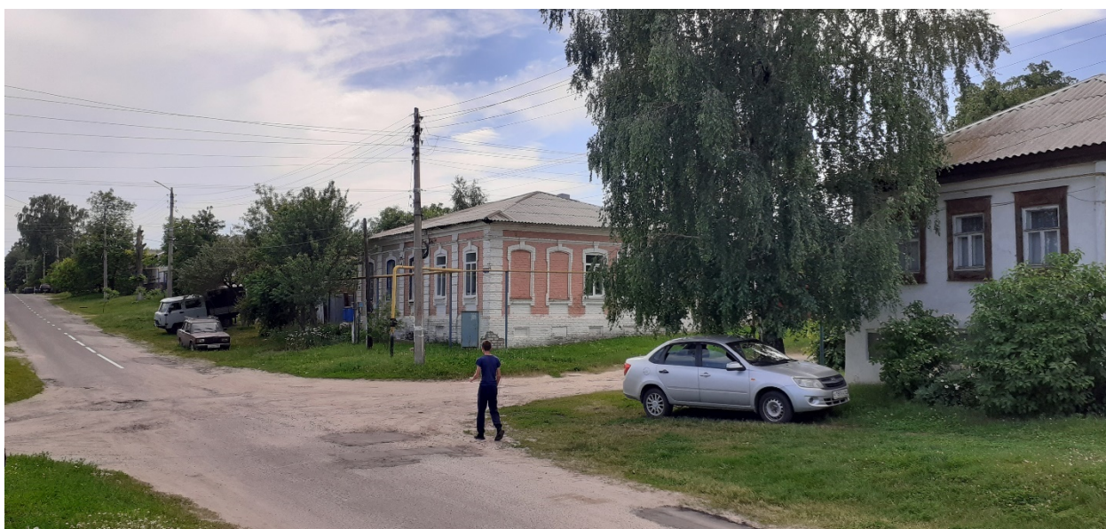
Фотография № 4. Вид с северо-востока на Объект.
