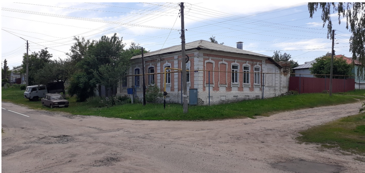
Фотография № 3. Вид с северо-востока на Объект.
