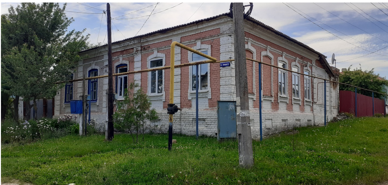
Фотография № 5. Вид с северо-востока на Объект.
