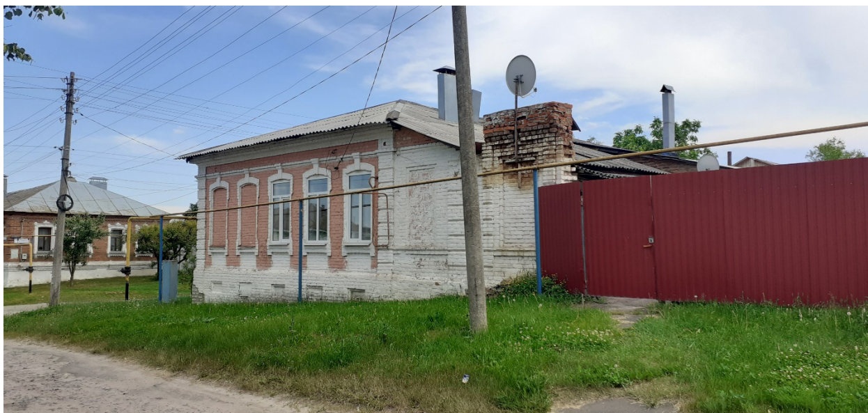
Фотография № 9. Вид с северо-запада на Объект.
