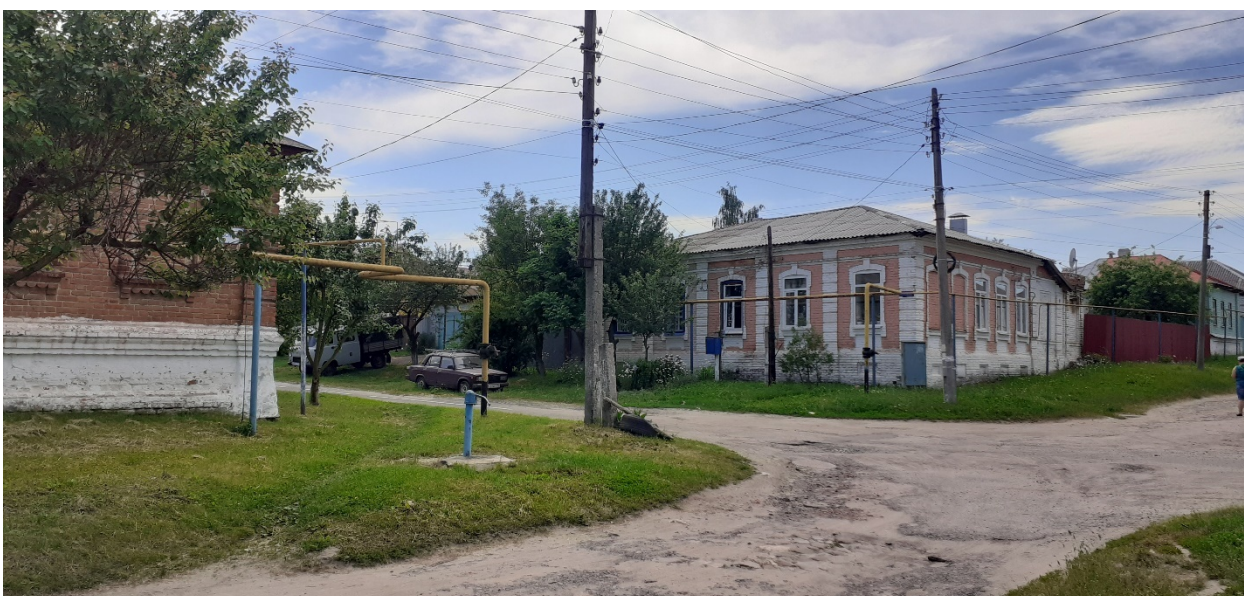
Фотография № 2. Вид с северо-востока на Объект.
