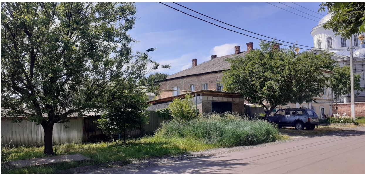
Фотография № 12. Вид с северо-востока на Объект.
