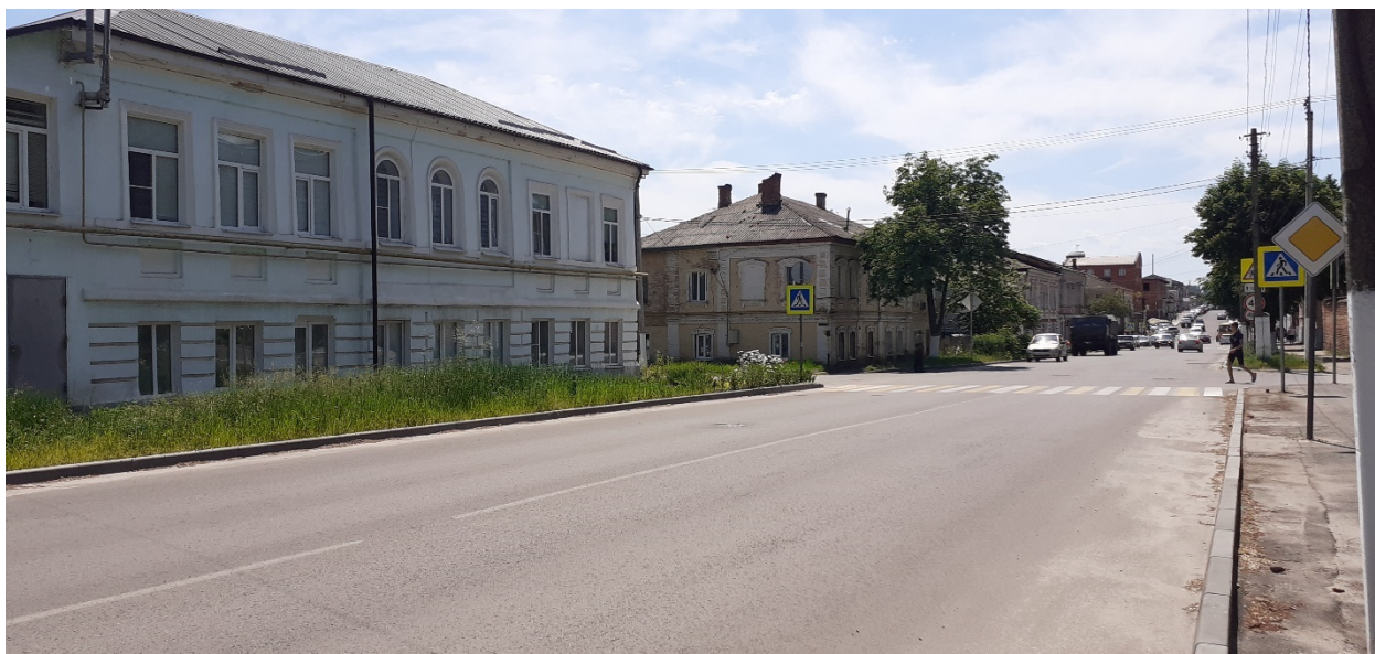
Фотография № 9. Вид с северо-запада на Объект.
