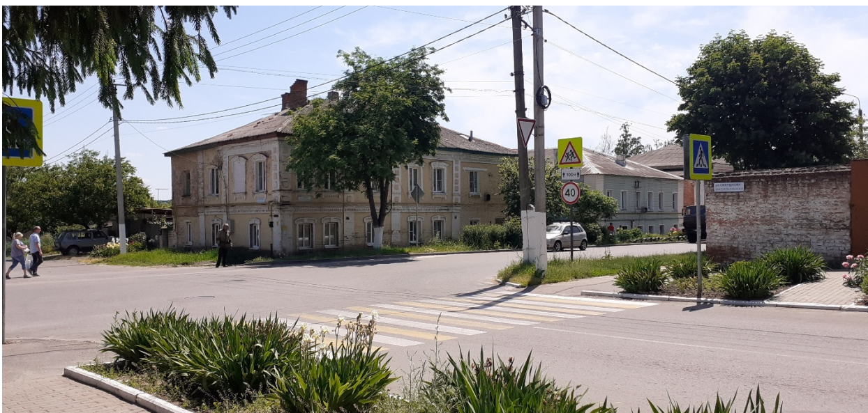
Фотография № 7. Вид с северо-запада на Объект.
