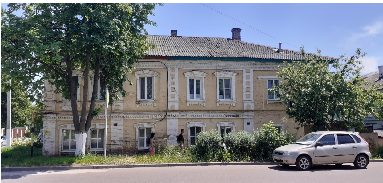
Фотография № 6. Вид с запада на Объект.
