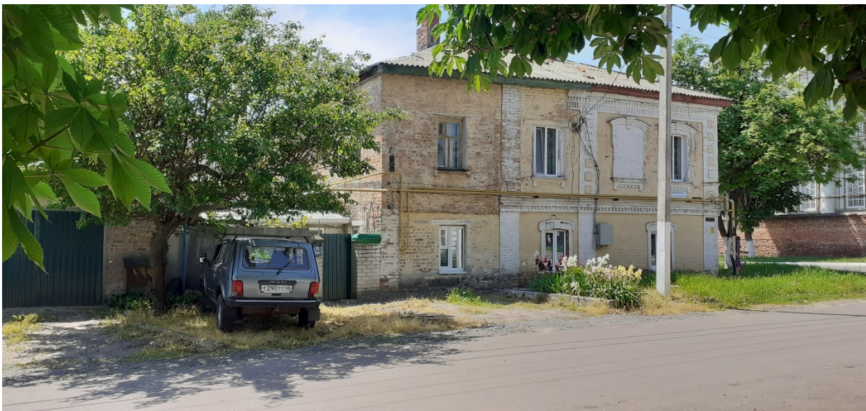
Фотография № 11. Вид с северо-востока на Объект.
