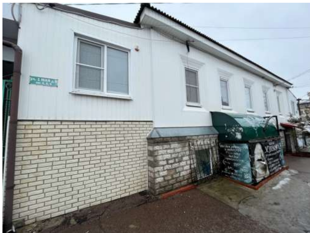
Т.ф. 2. Отдельные элементы декора главного фасада Объекта со стороны ул. 1 Мая.
