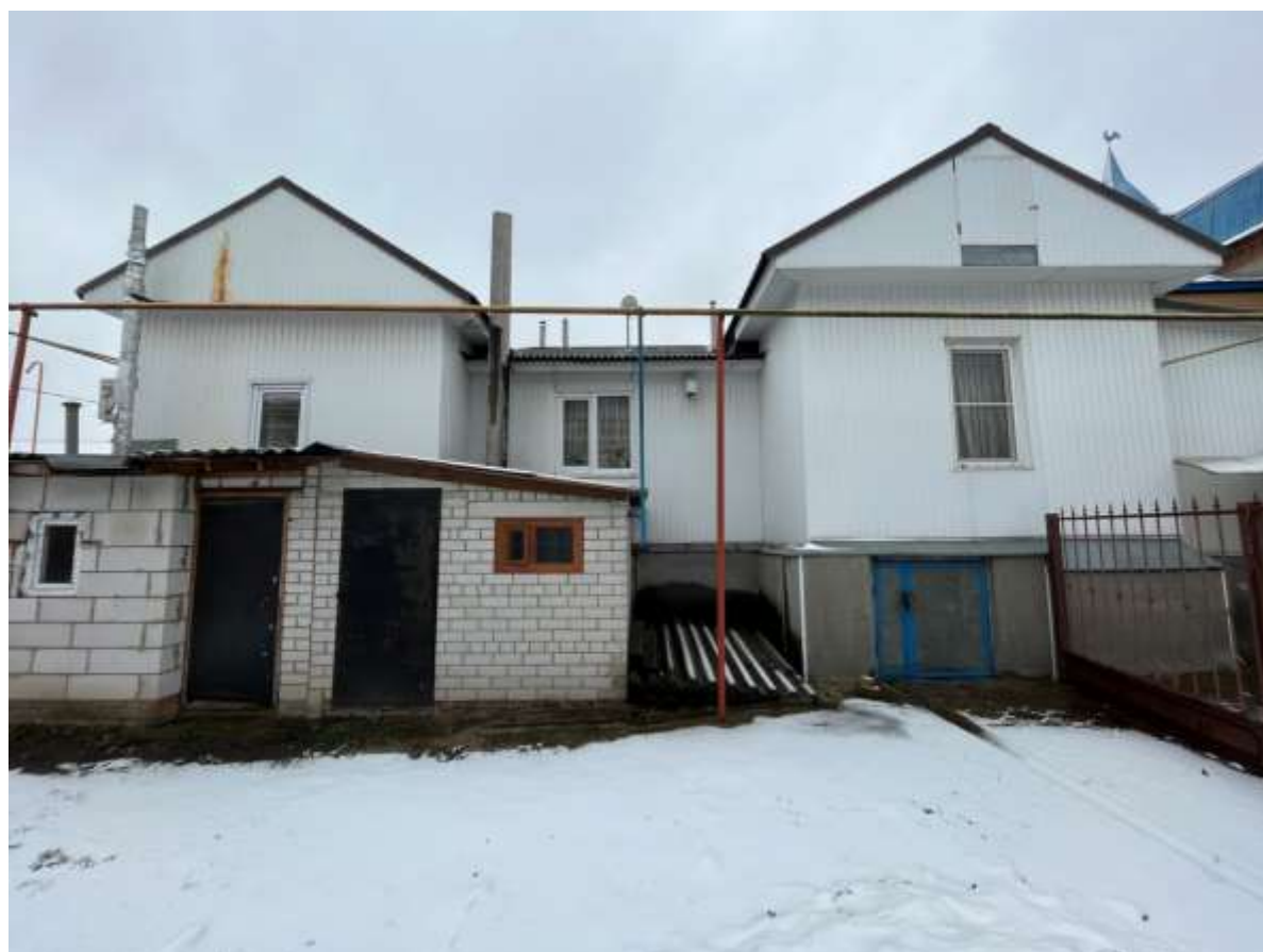
Т.ф. 6. Дворовый фасада Объекта.
