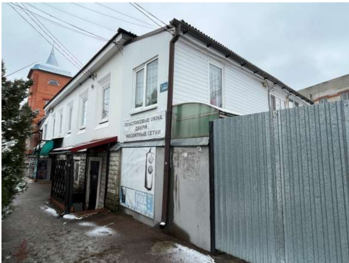
Т.ф. 3. Отдельные элементы декора главного фасада Объекта со стороны ул. 1 Мая.
