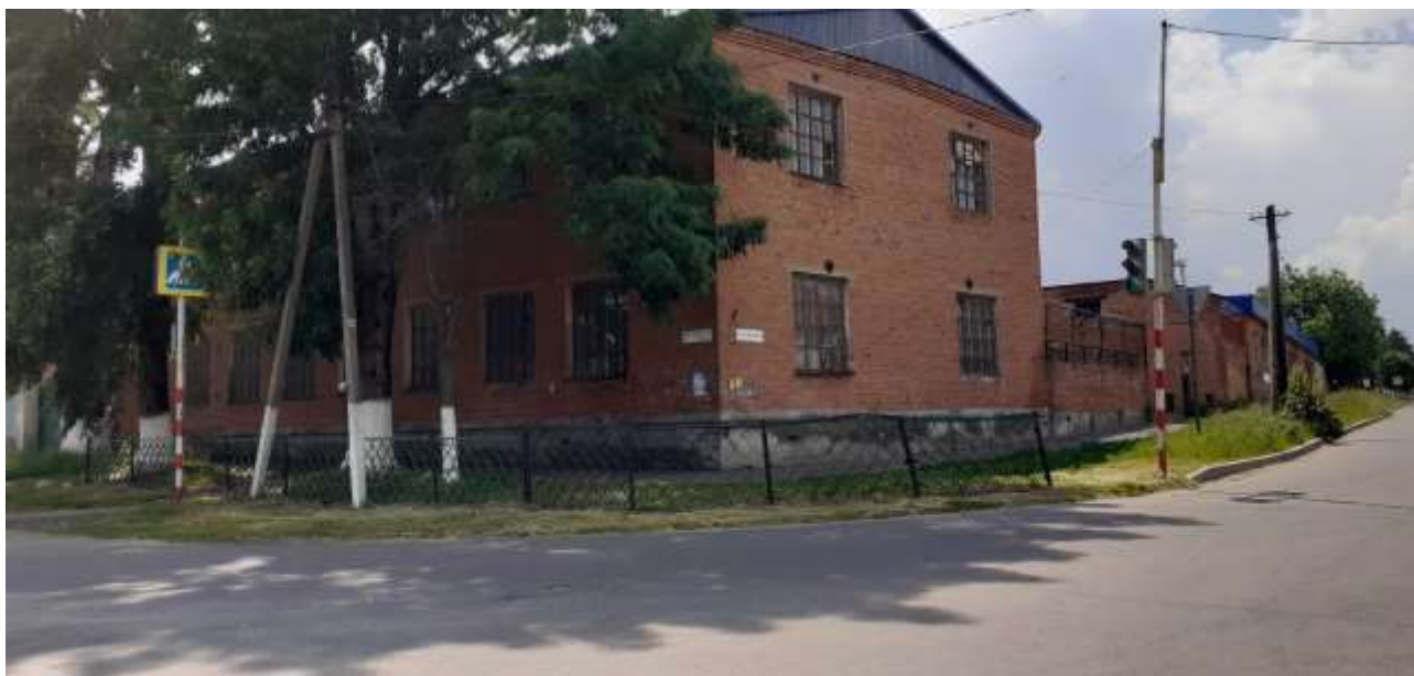
Фотография № 14. Вид на застройку ул. Розы Люксембург.
