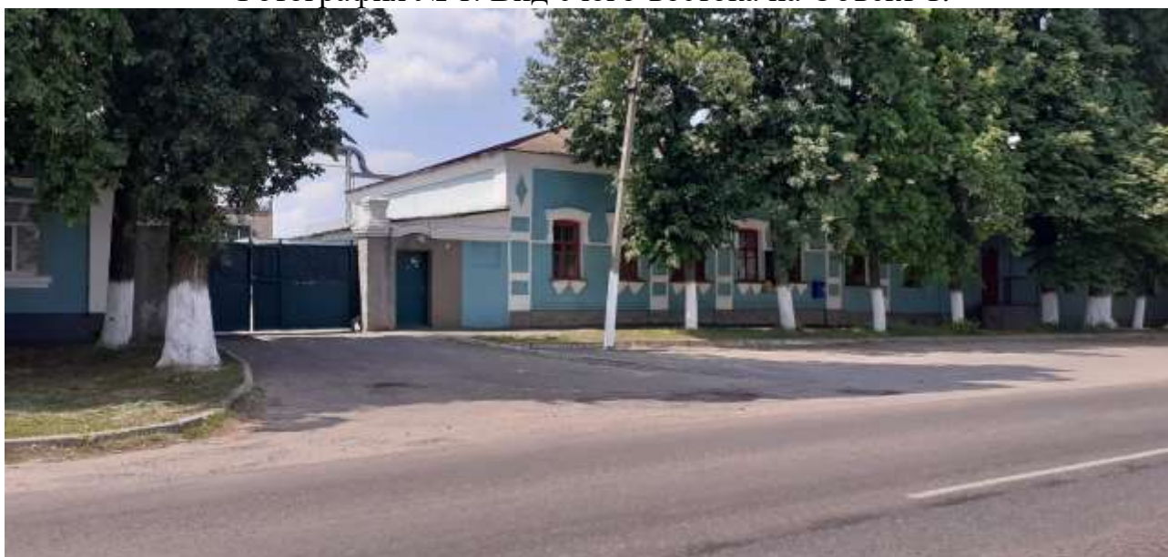
Фотография № 2. Вид с юго-востока на Объект 1.
