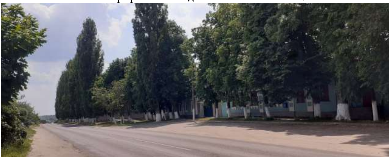
Фотография № 5. Вид с северо-востока на Объект 1.
