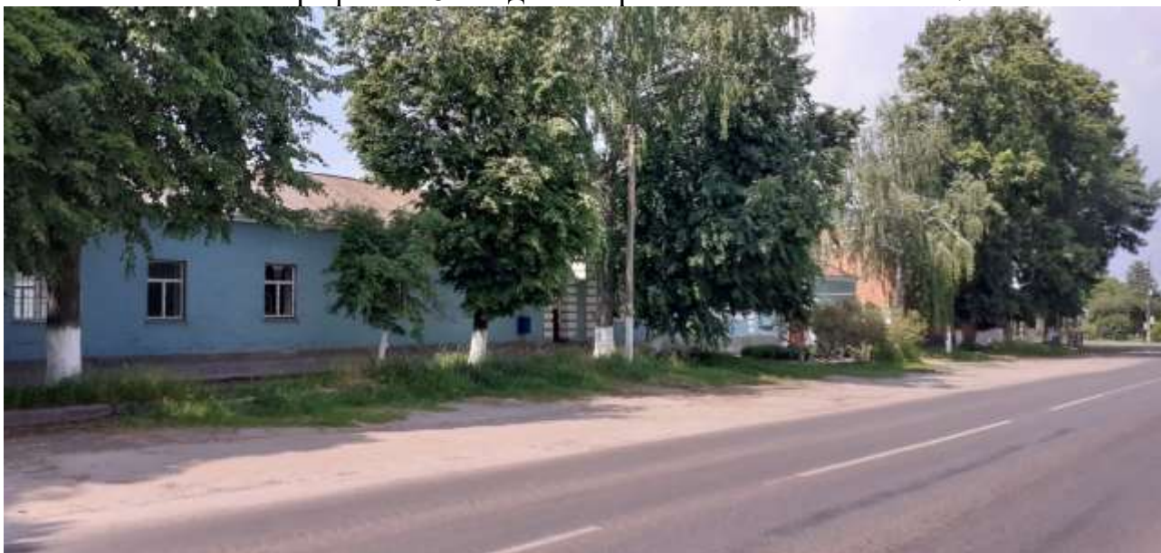
Фотография № 6. Вид с юго-востока на Объект 2.
