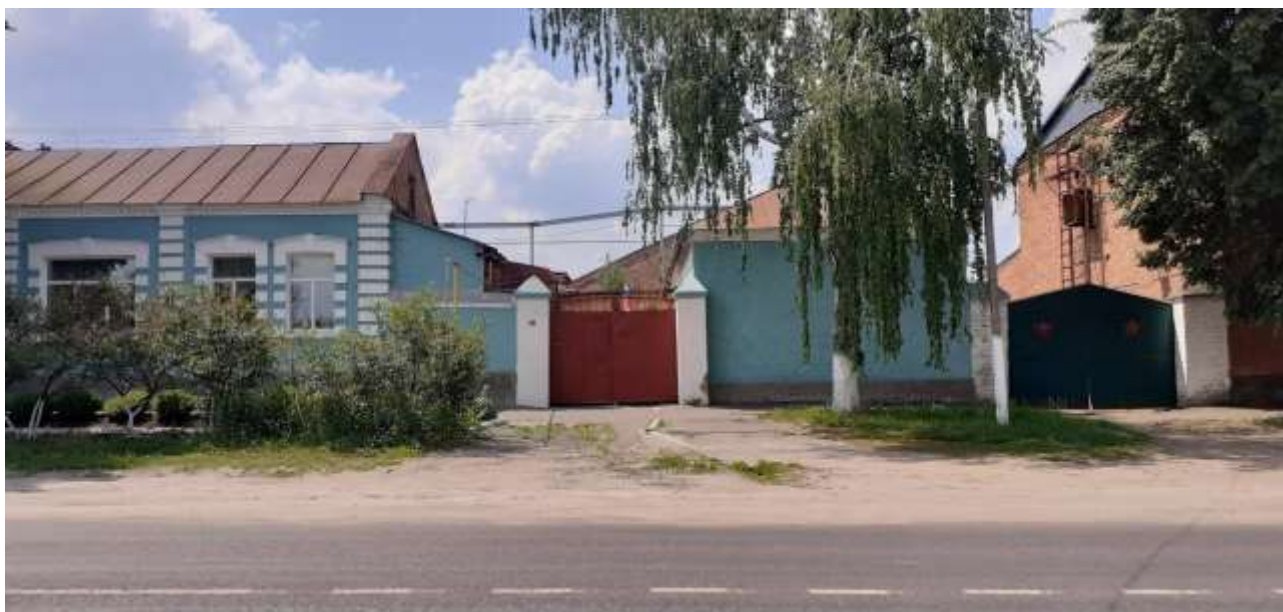
Фотография № 11. Вид с северо-востока на Объект 2.
