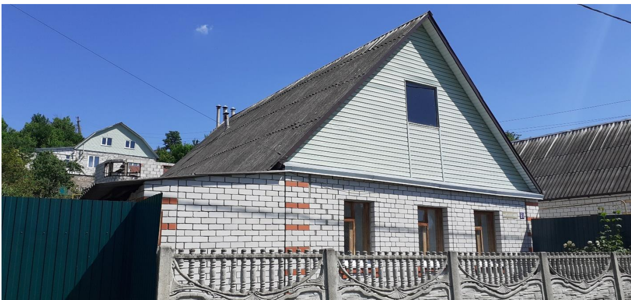
Фотография № 5. Вид с северо-запада на Объект.
